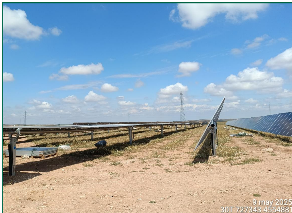
Fotografía 5. Superficie de la zona de hincado.
