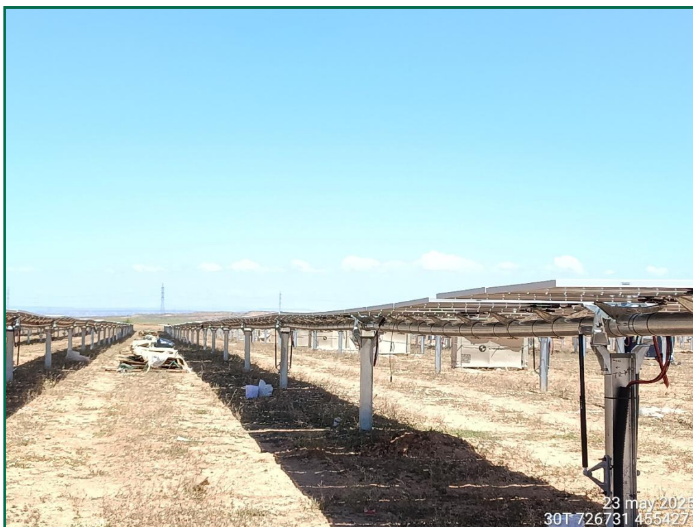
Fotografía 4. Superficie de la zona de hincado.
