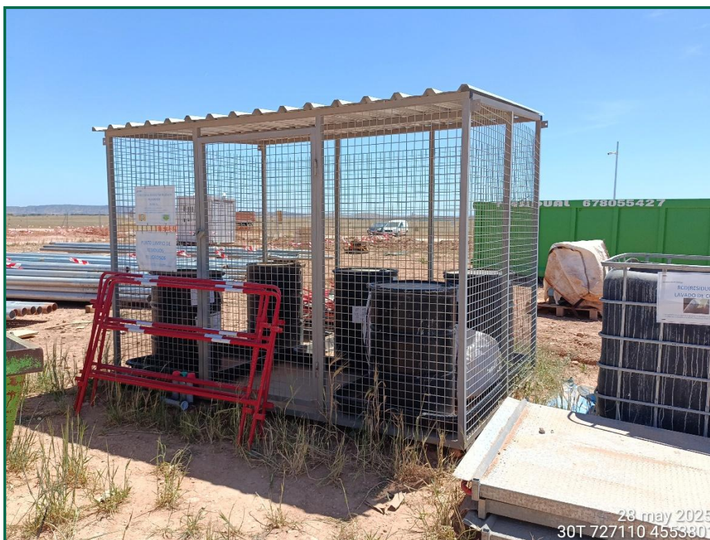
Fotografía 12. Punto limpio para residuos peligrosos.
