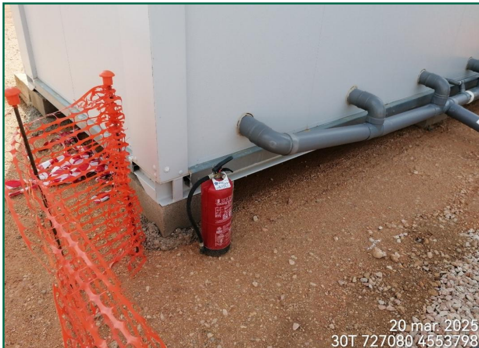
Fotografía 19. Extintor junto a bidones de combustible.
