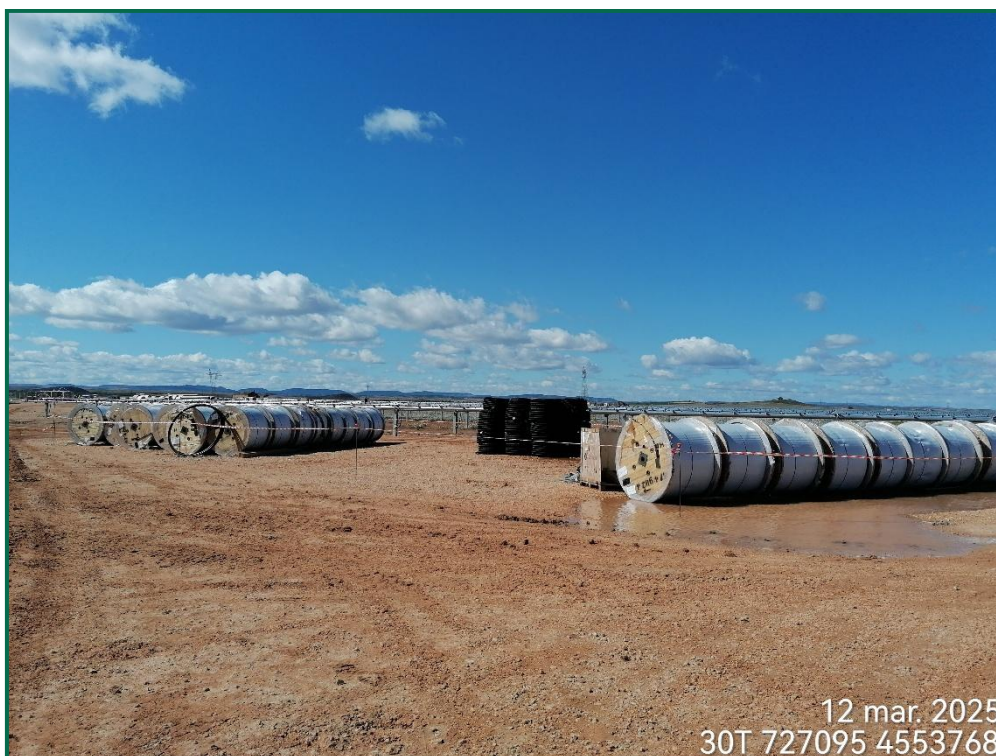
Fotografía 10. Superficie de la zona de acopios.
