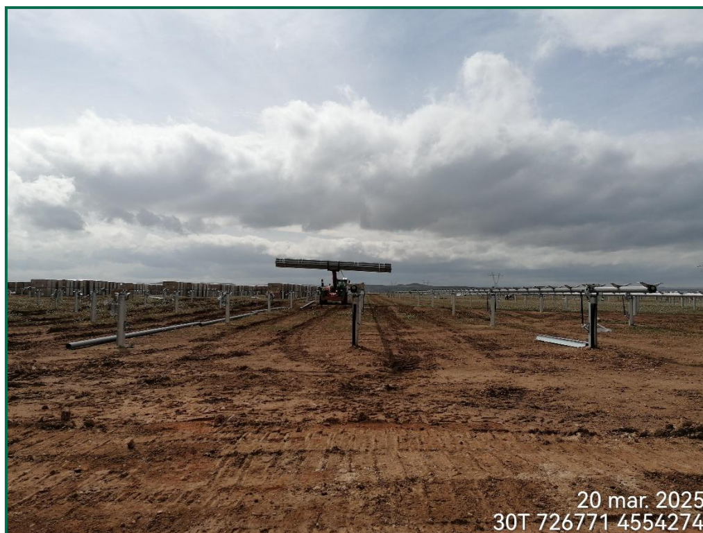
Fotografía 4. Superficie de la zona de hincado.
