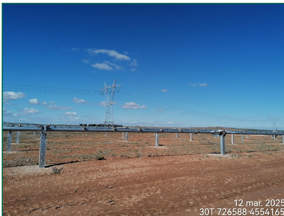
Fotografía 5. Superficie de la zona de hincado.
