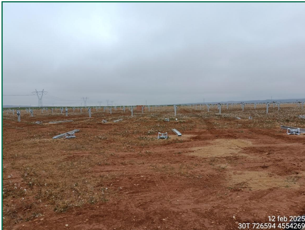
Fotografía 4. Superficie de la zona de hincado.
