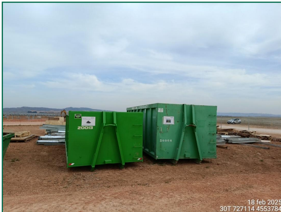
Fotografía 13. Punto limpio de residuos inertes.
