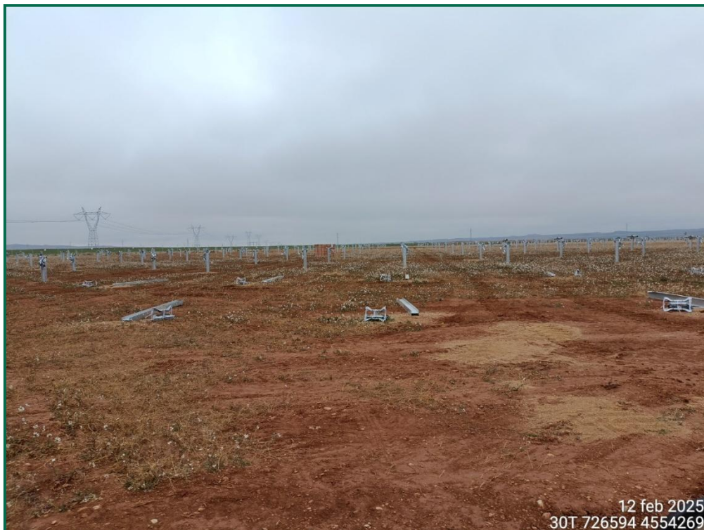
Fotografía 5. Superficie de la zona de hincado.
