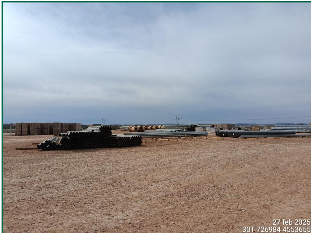
Fotografía 10. Superficie de la zona de acopios.
