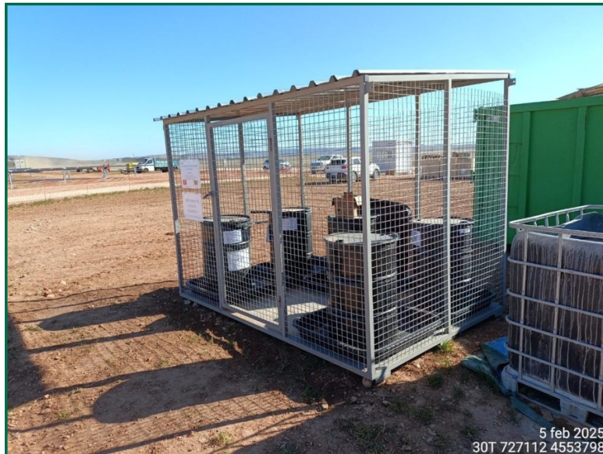
Fotografía 16. Punto limpio para residuos peligrosos.
