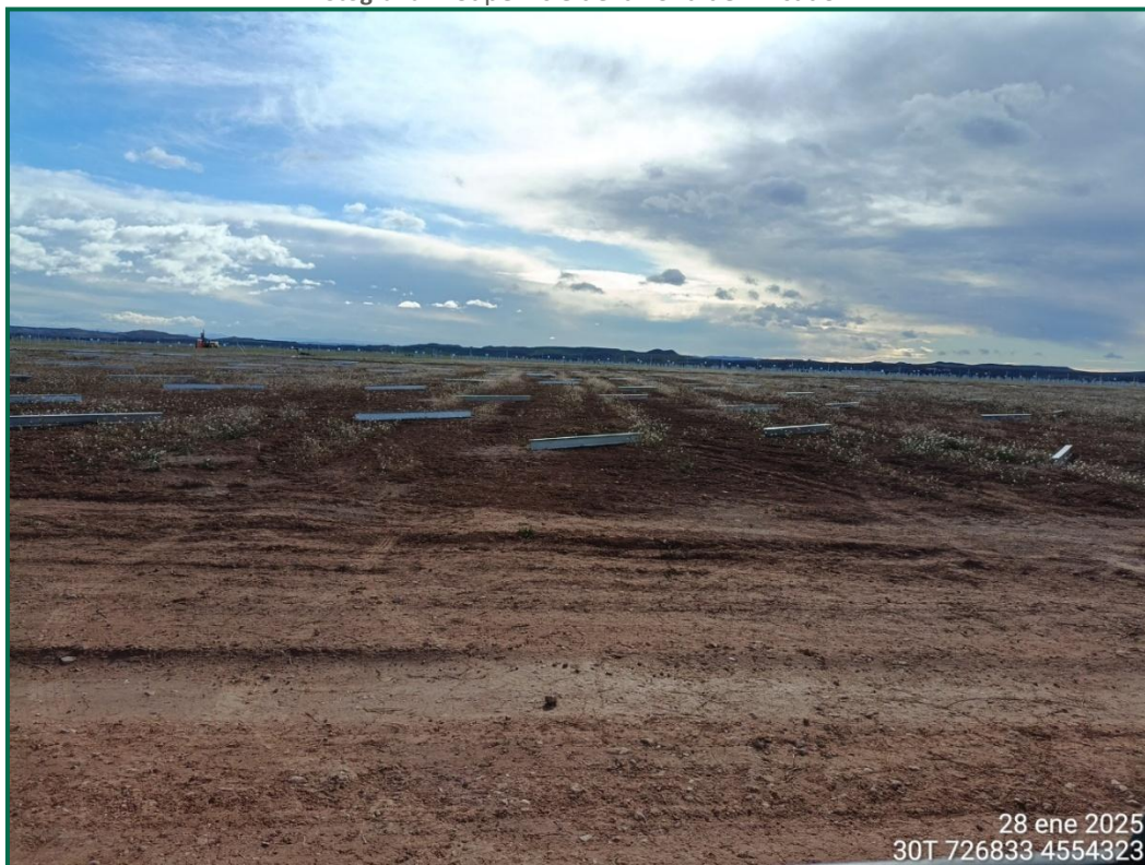
Fotografía 5. Superficie de la zona de hincado.
