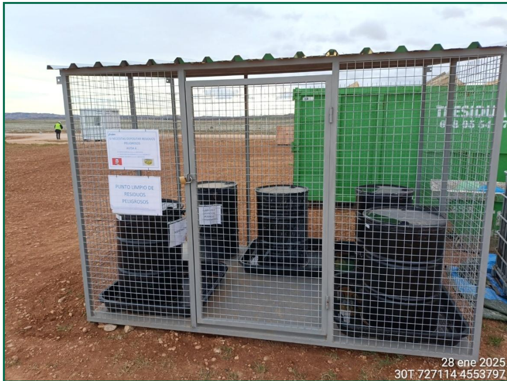
Fotografía 13. Punto limpio para residuos peligrosos.
