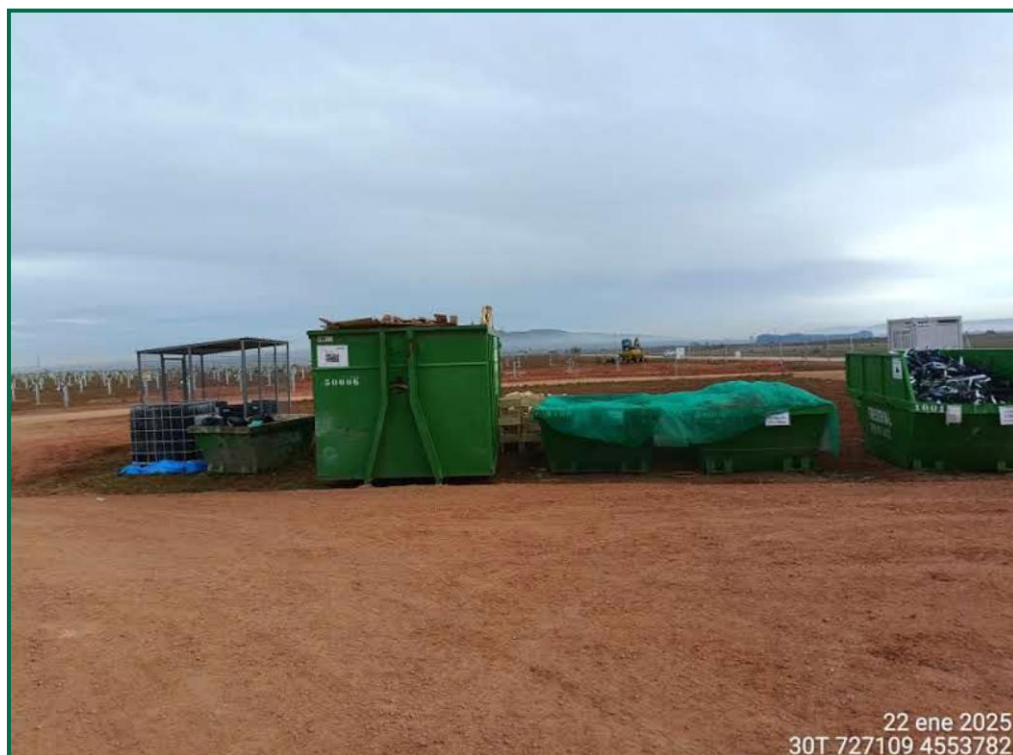
Fotografía 12. Punto limpio de residuos inertes.
