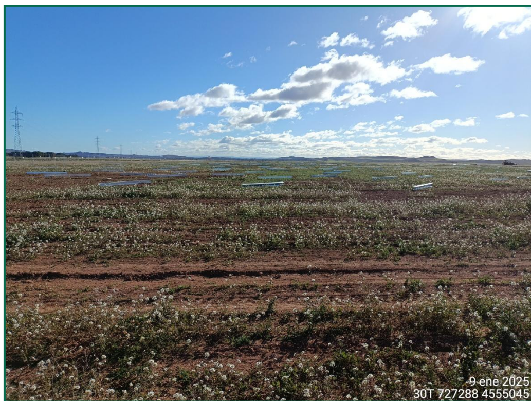
Fotografía 4. Superficie de la zona de hincado.
