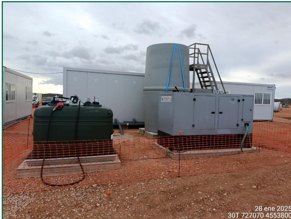
Fotografía 11. Bidones de combustible y fosa séptica.
