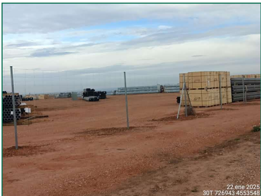
Fotografía 7. Superficie de la zona de acopios.
