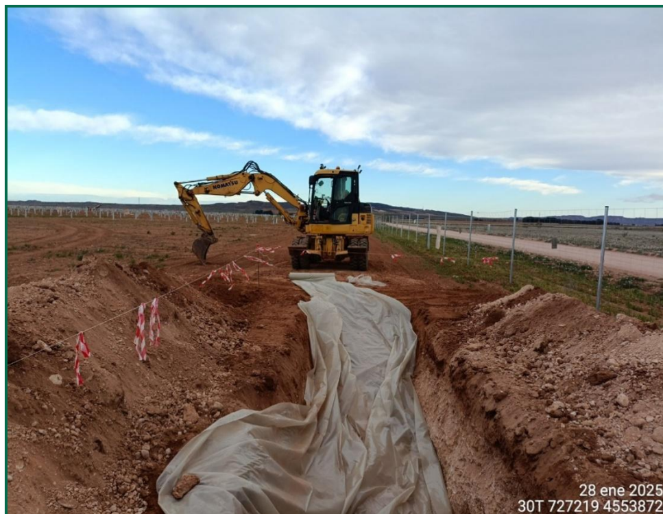
Fotografía 14. Balsa en construcción para lavado de canaletas.
