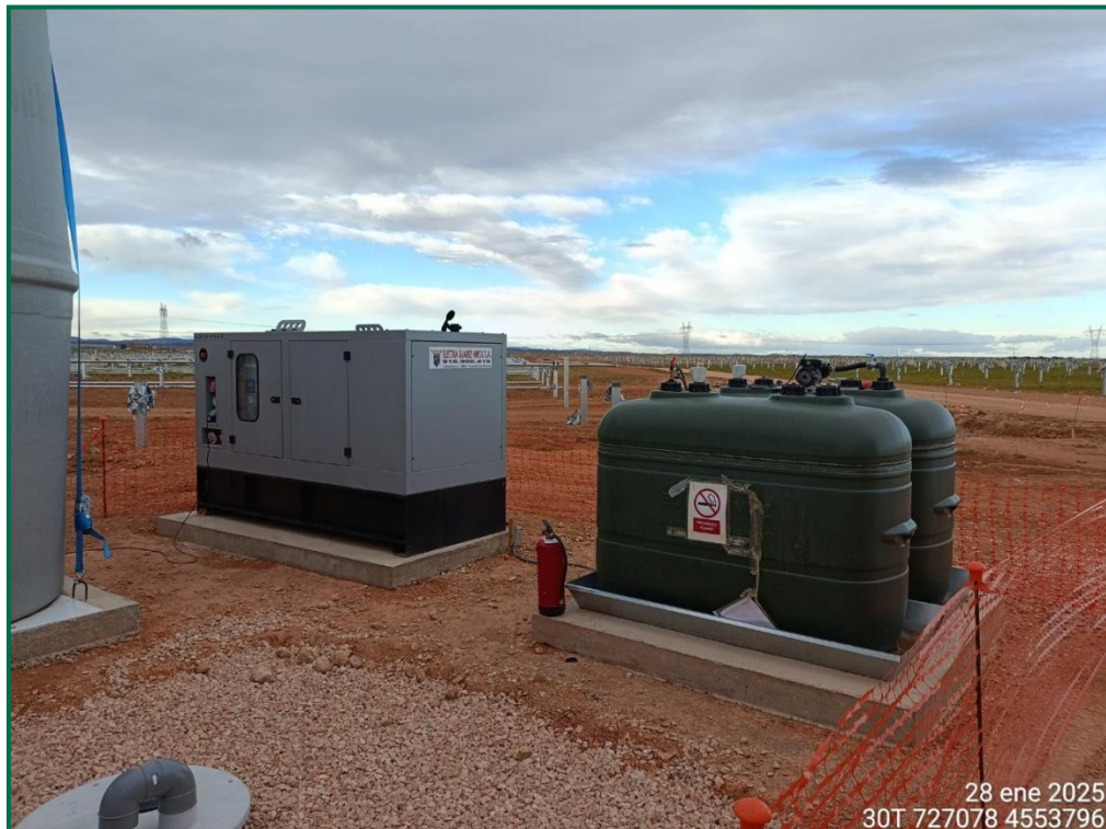
Fotografía 10. Grupo electrógeno.
