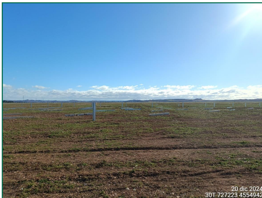
Fotografía 4. Superficie de la zona de hincado.
