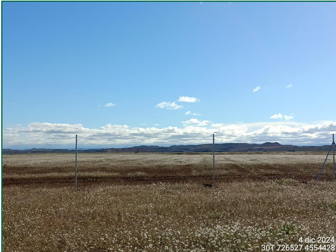
Fotografía 2. Vallado perimetral en proceso.
