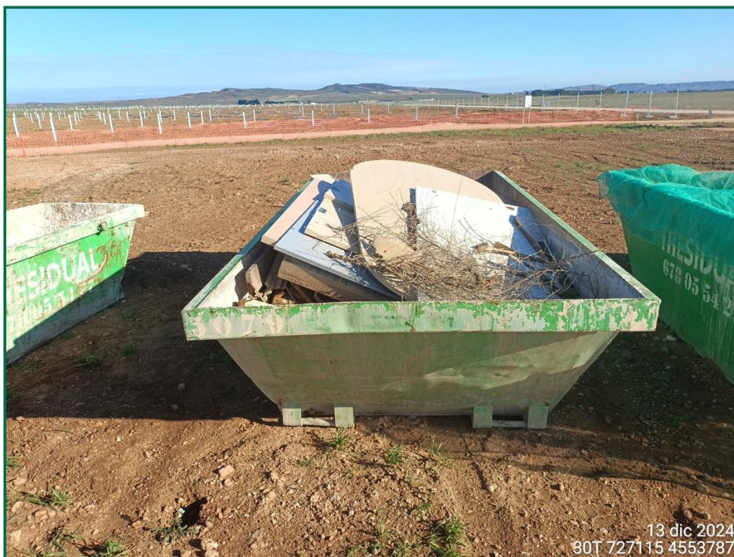
Fotografía 13. Contenedor para madera..
