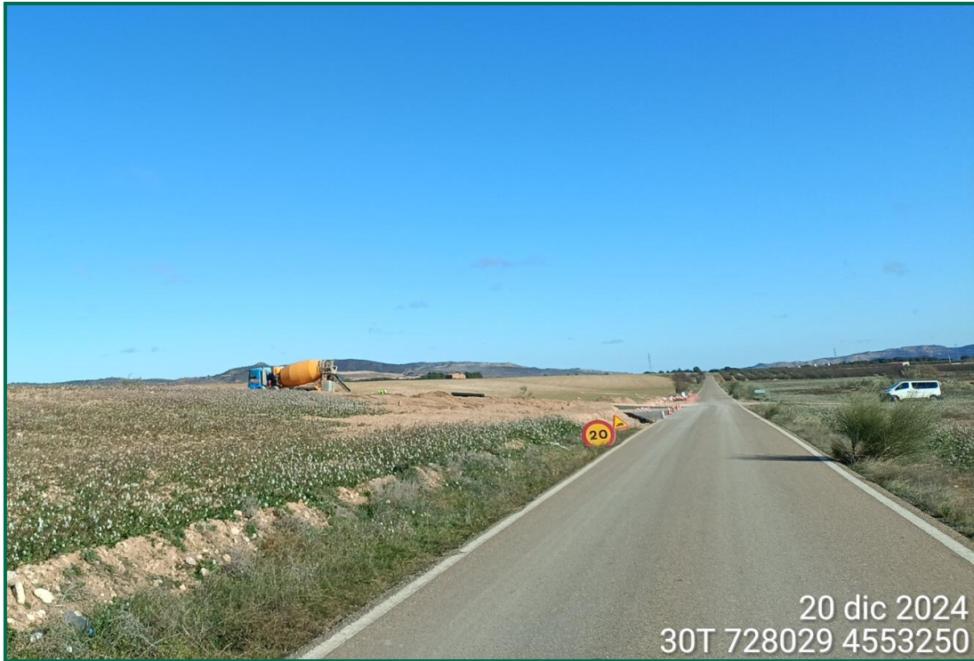
Fotografía 3. Señal de limitación de velocidad.
