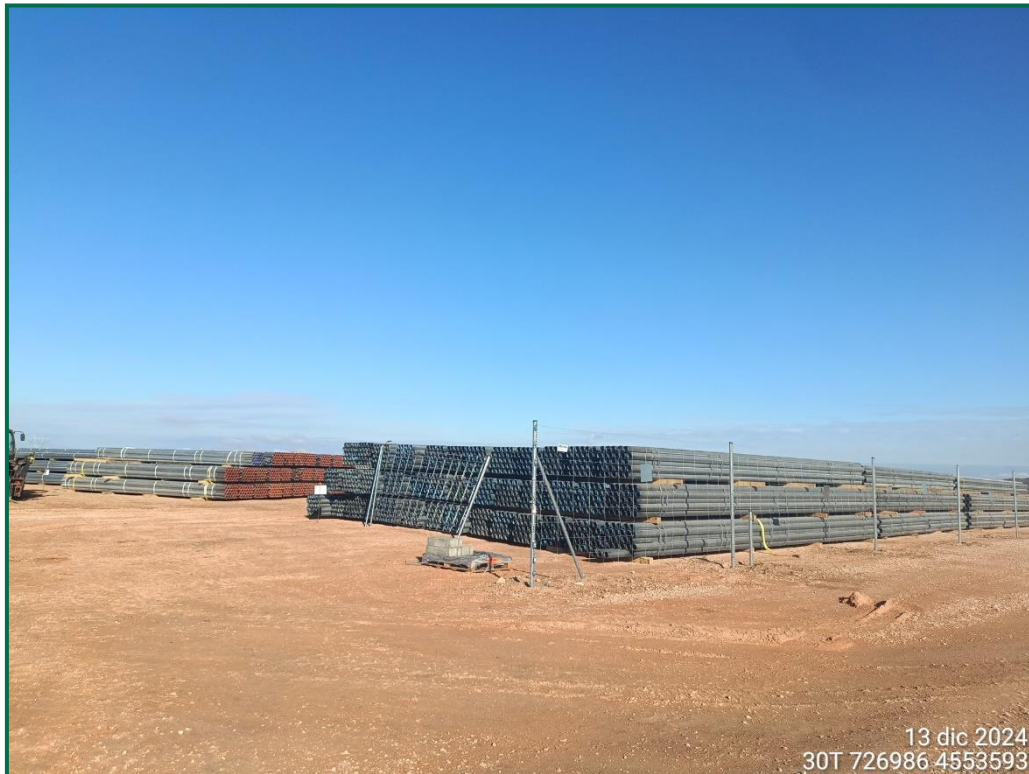
Fotografía 6. Superficie de la zona de acopios.
