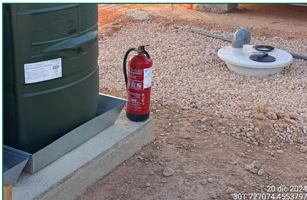
Fotografía 16. Extintor junto a bidones de combustible.
