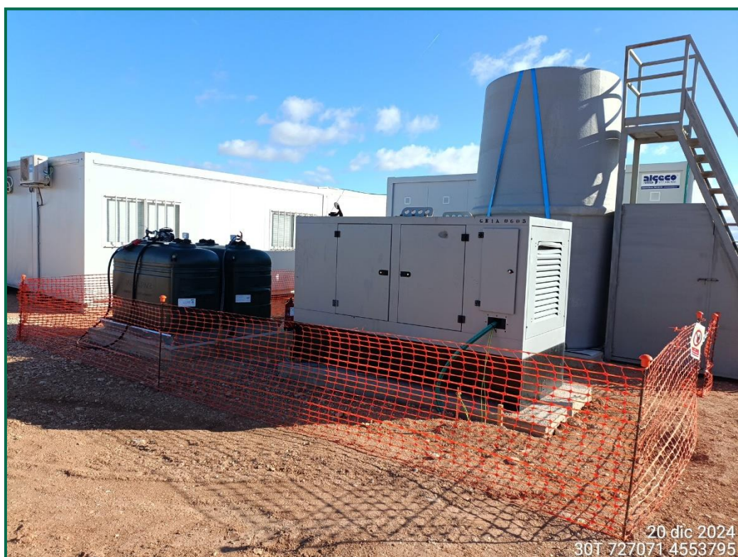
Fotografía 9. Grupo electrógeno.
