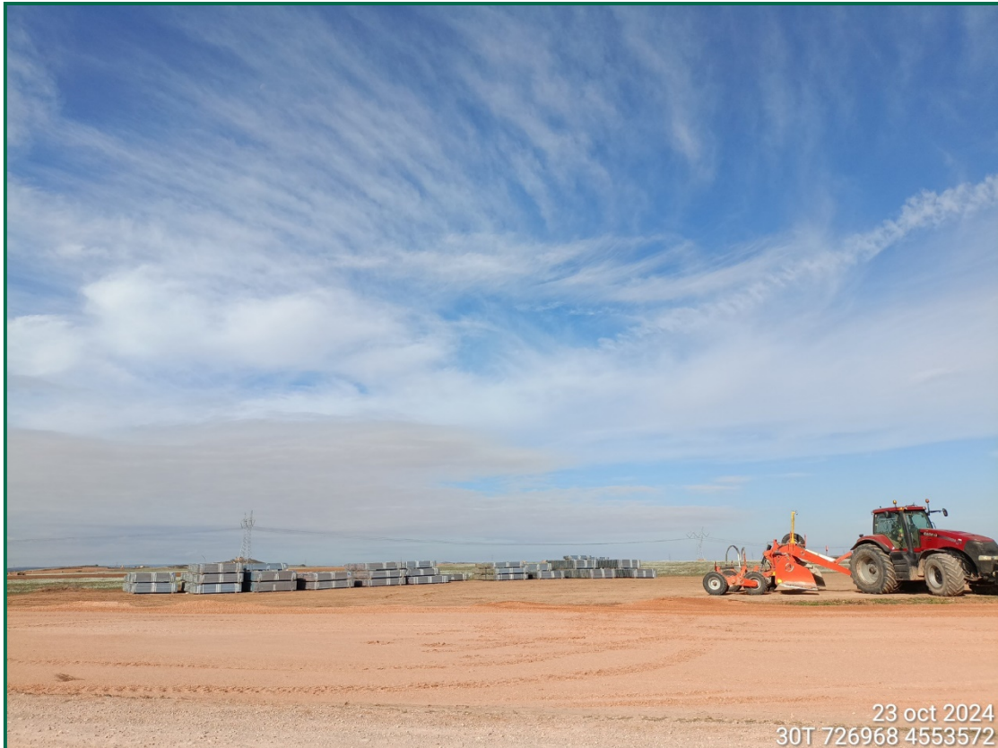
Fotografía 1. Superficie de la zona de acopios.
