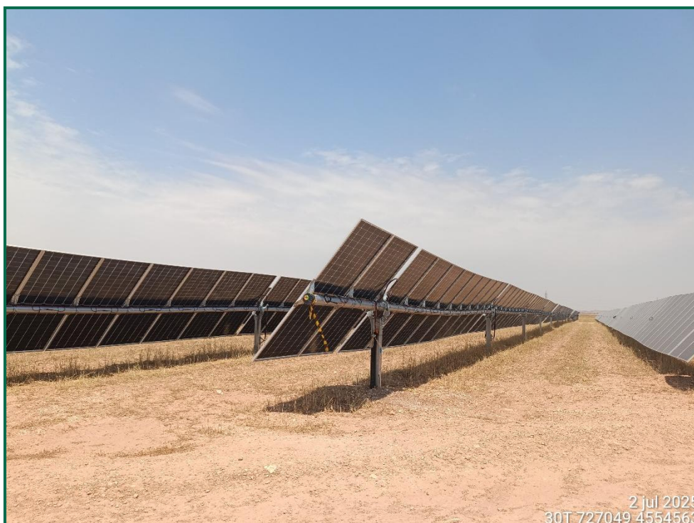
Fotografía 4. Superficie de la zona de hincado.
