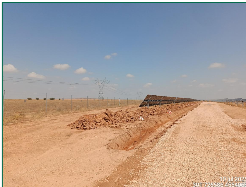
Fotografía 3. Creación de cunetas.
