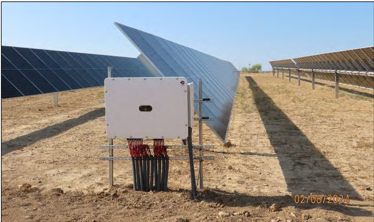
Ilustración 30. Línea de placas finalizada y revisada.
