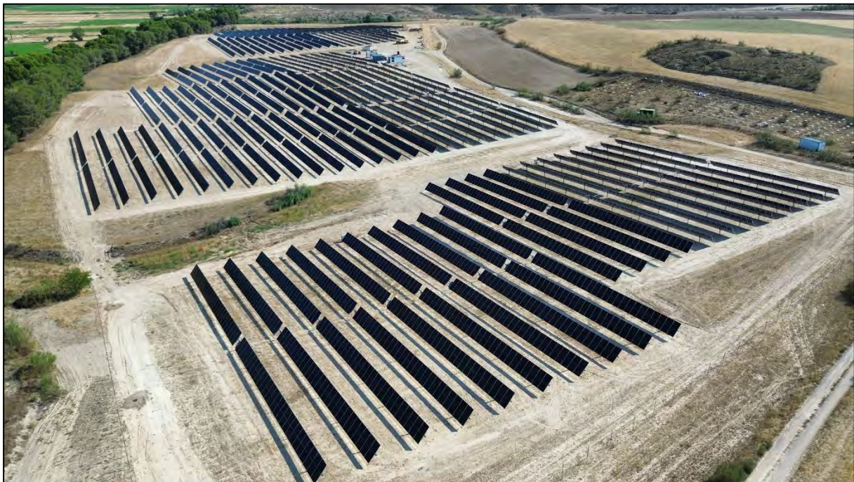
Ilustración 29. Finalización de la instalación de paneles solares (26/07/2024).
