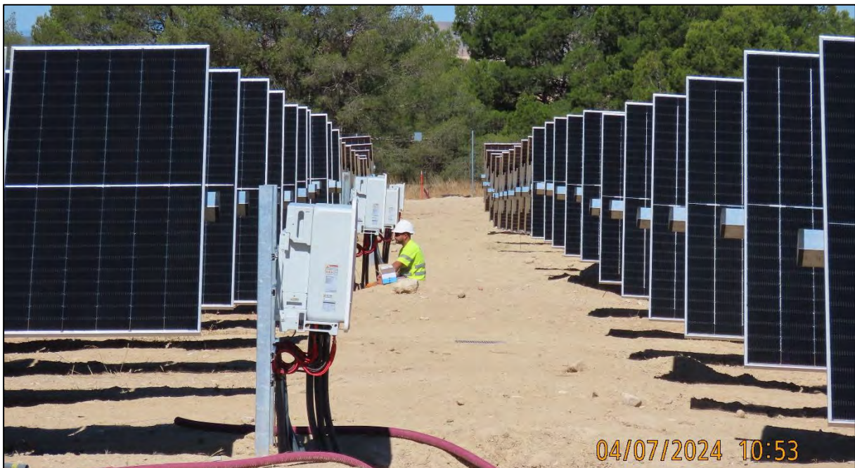
Ilustración 27. Instalación de cableado en el interior de las instalaciones.
