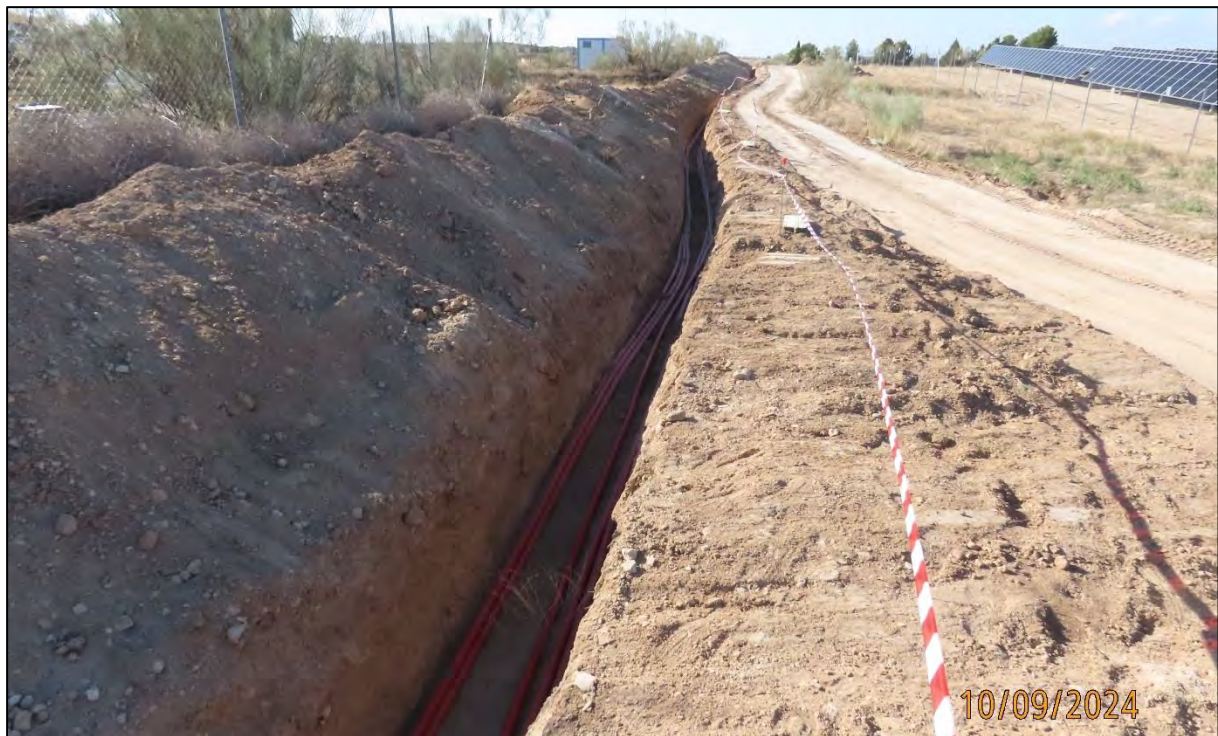
Ilustración 35. Señalización del trazado de la zanja a la altura del PFV "El Boyal".
