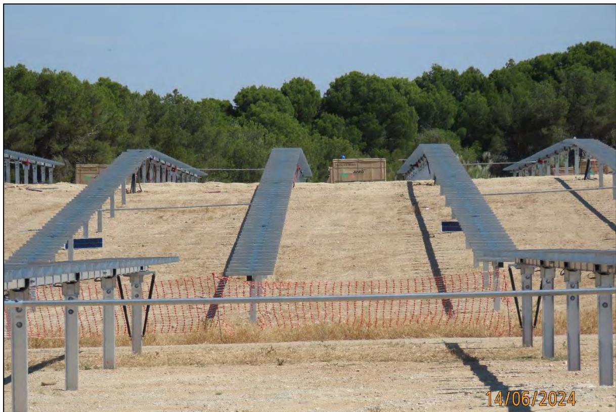
Ilustración 22. Finalización del montaje de las estructuras de los seguidores.
