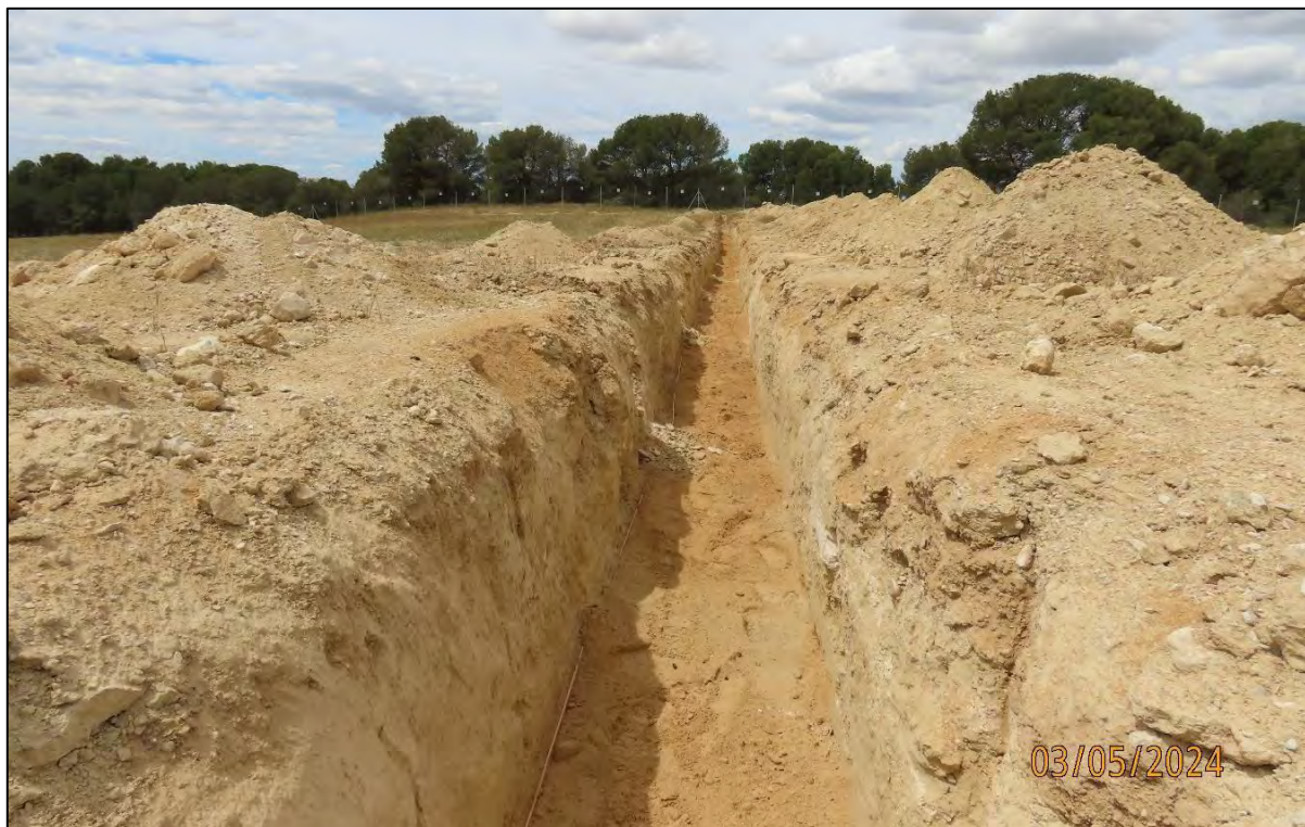
Ilustración 13. Apertura de zanjas y acopio de tierra vegetal.
