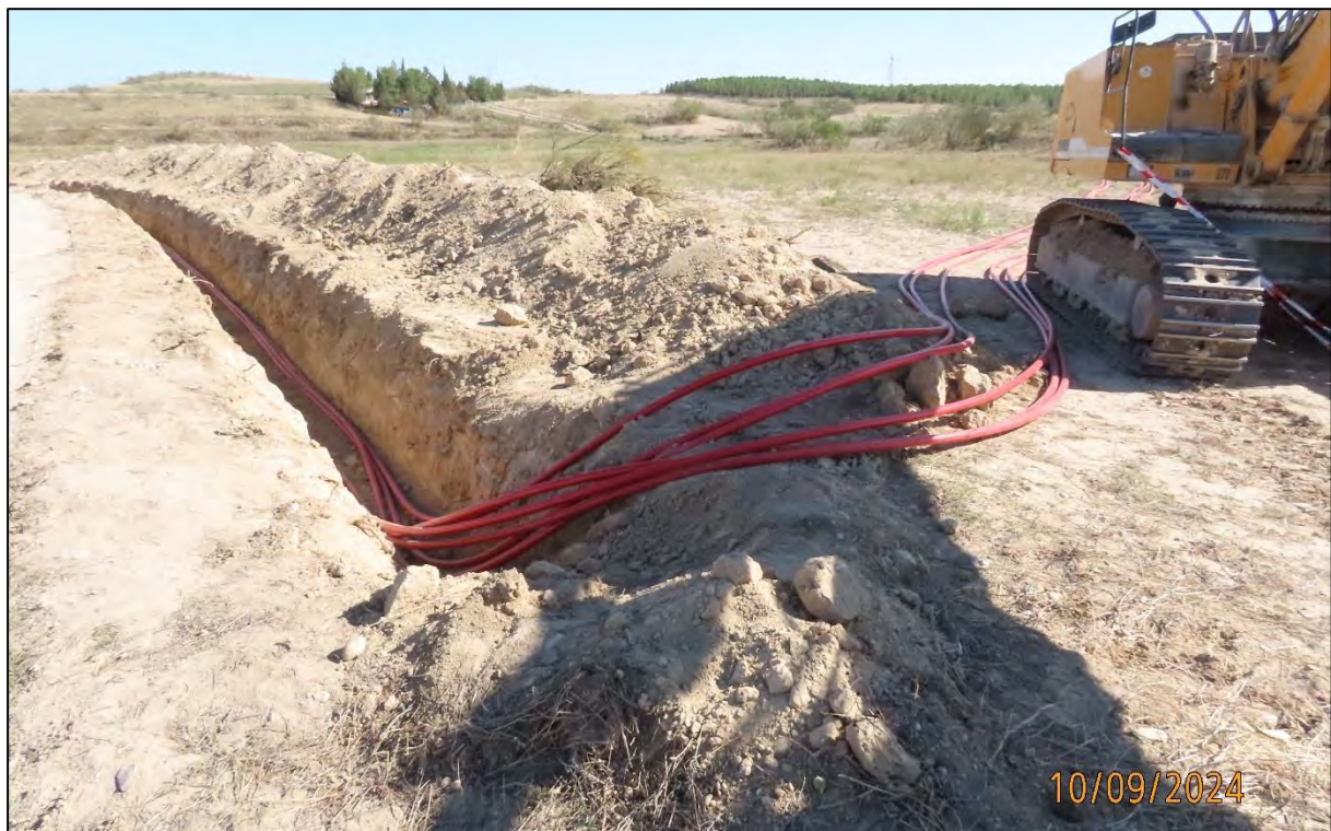
Ilustración 34. Extremo de la LSMT, que parte de la PFV "La Pallaruela".
