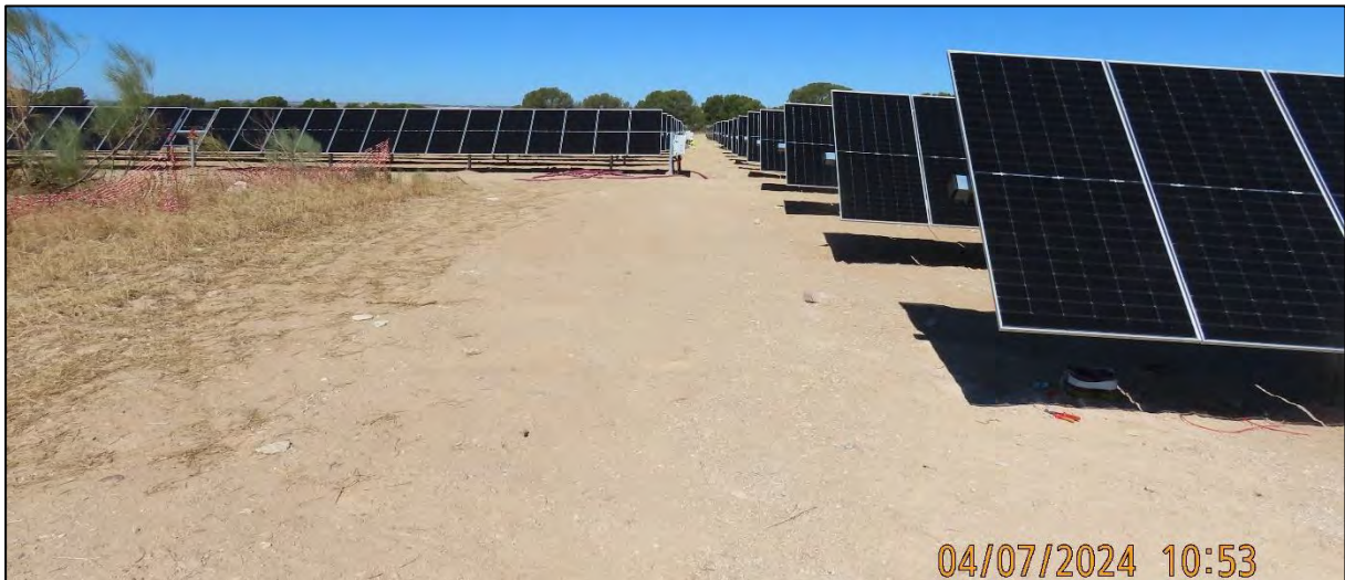
Ilustración 26. Acondicionamiento de los viales interiores.
