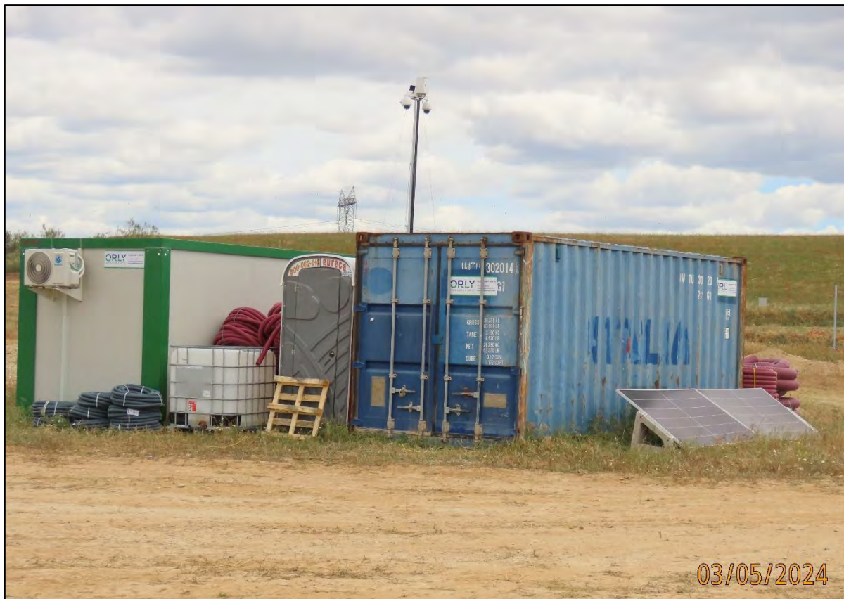
Ilustración 12. Zona de instalaciones auxiliares.
