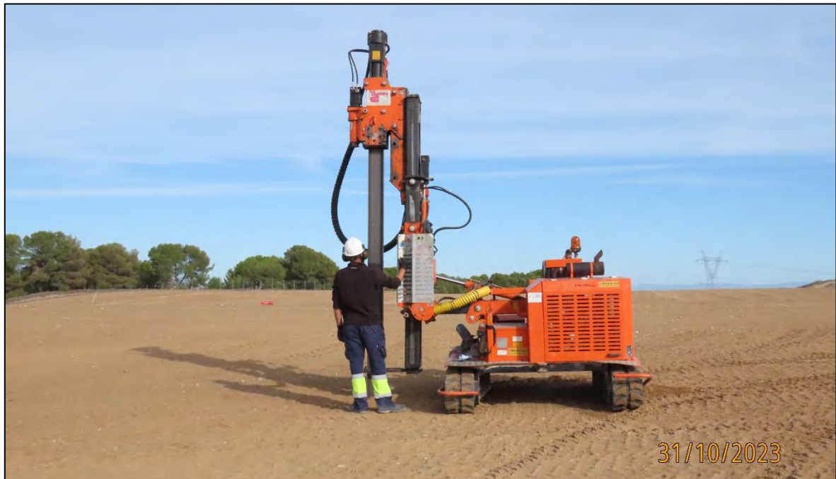
Ilustración 7. Pruebas de hincado.
