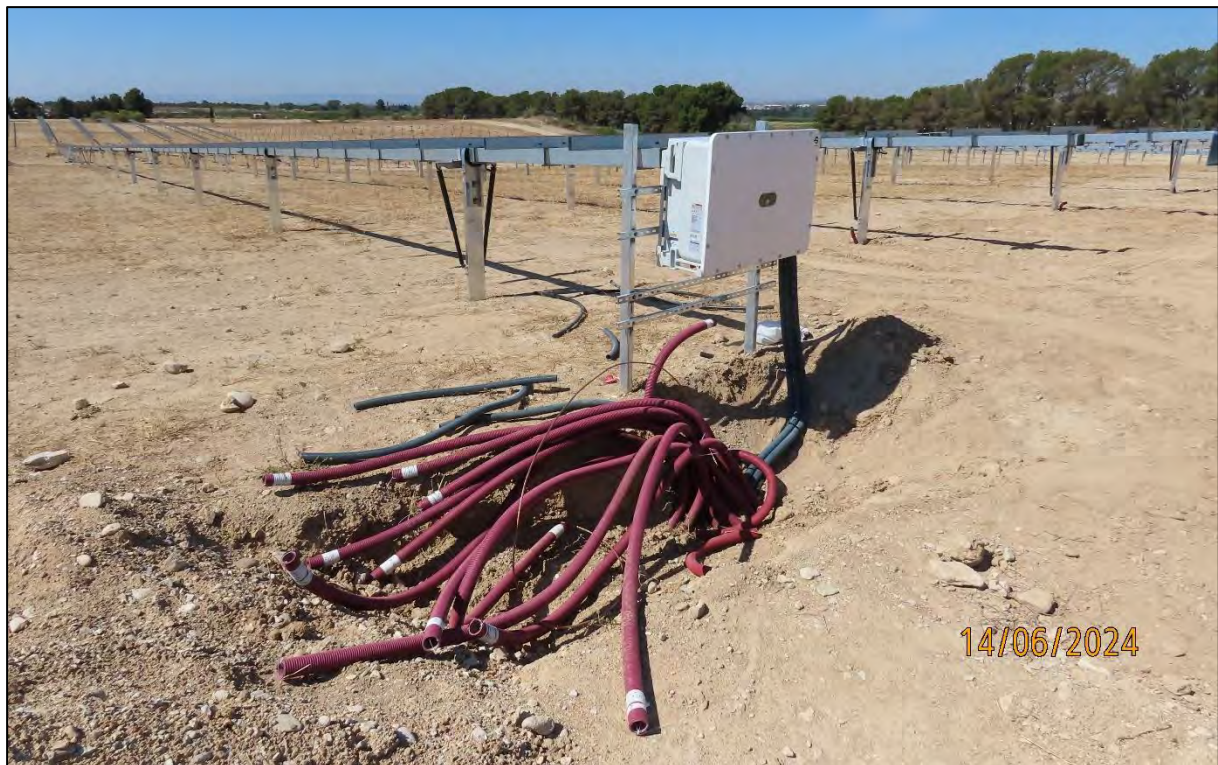
Ilustración 21. Colocación de tuberías de cableado y tapado de zanjas.
