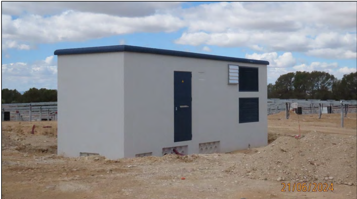
Ilustración 23. Instalación del centro de seccionamiento.
