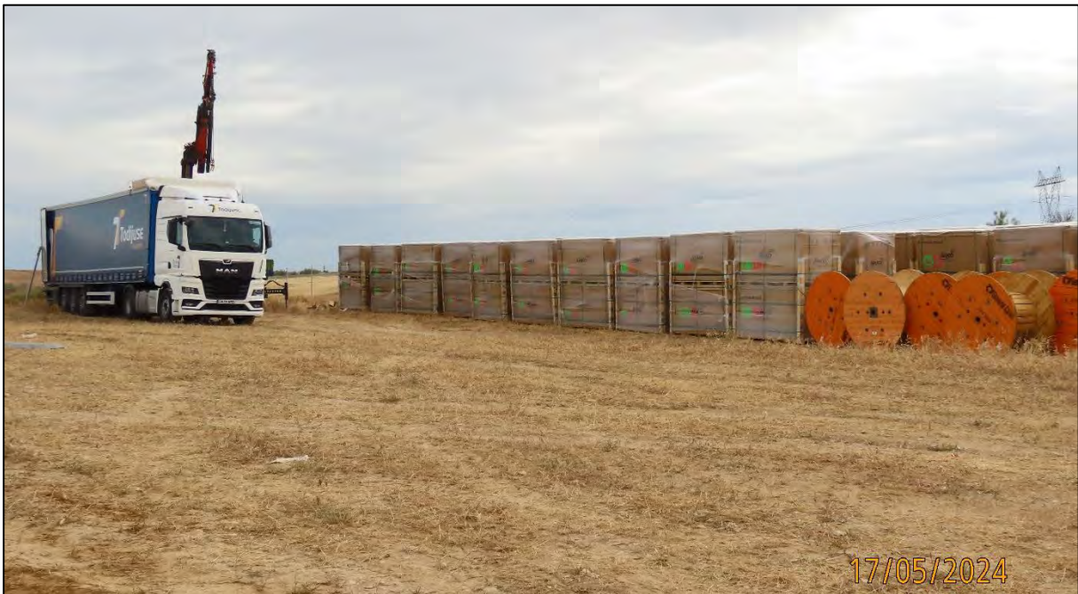
Ilustración 9. Recepción y acopio de materiales.
