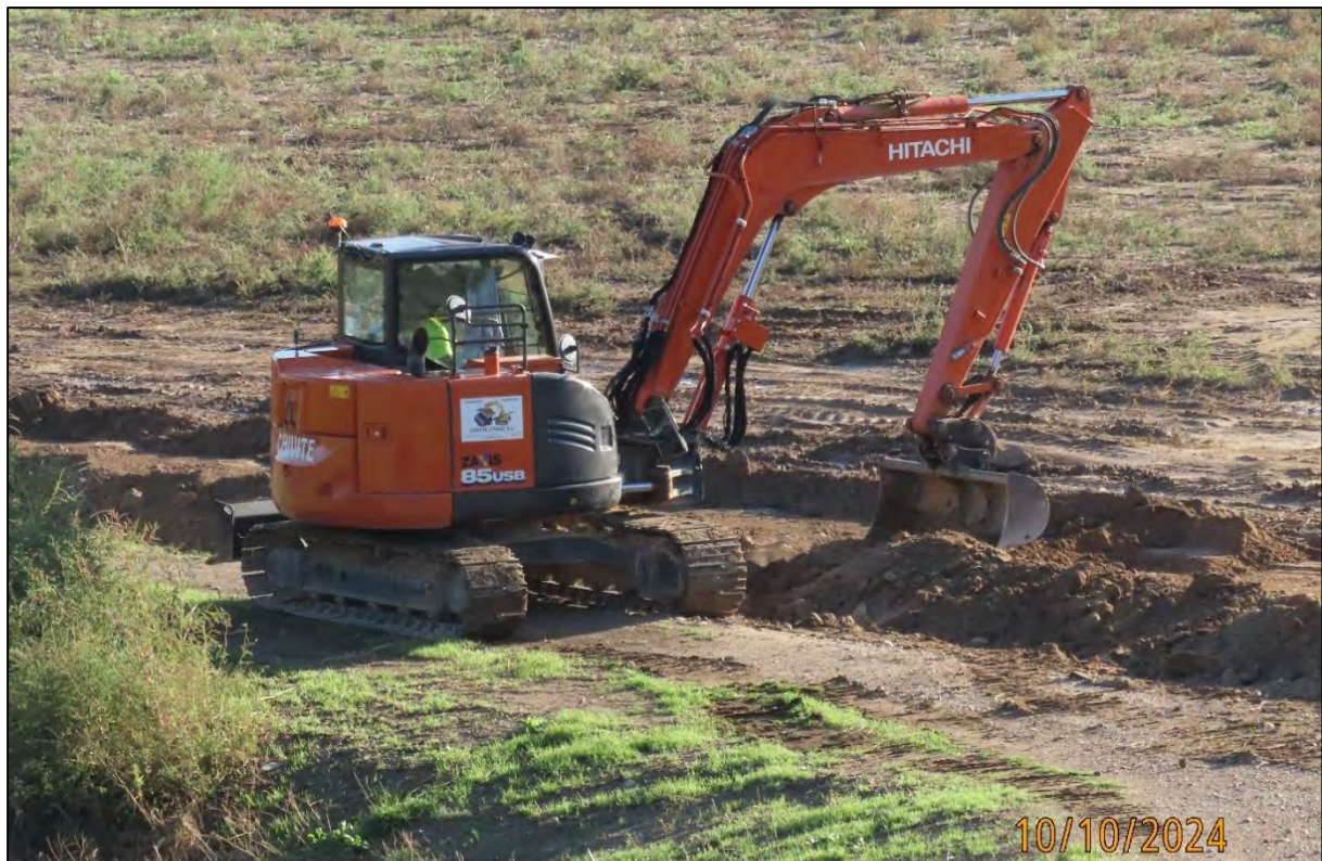
Ilustración 39. Tapado de la zanja que alberga la LSMT.
