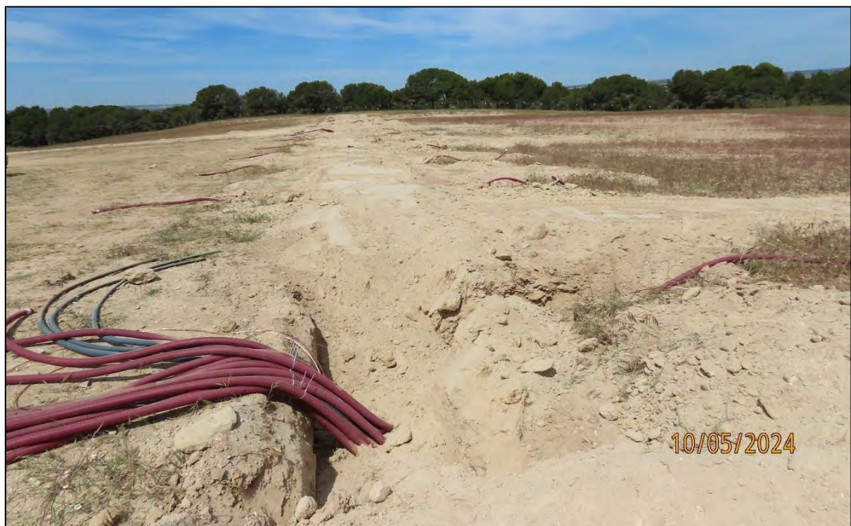
Ilustración 15. Colocación de cableado y tapado de zanjas.
