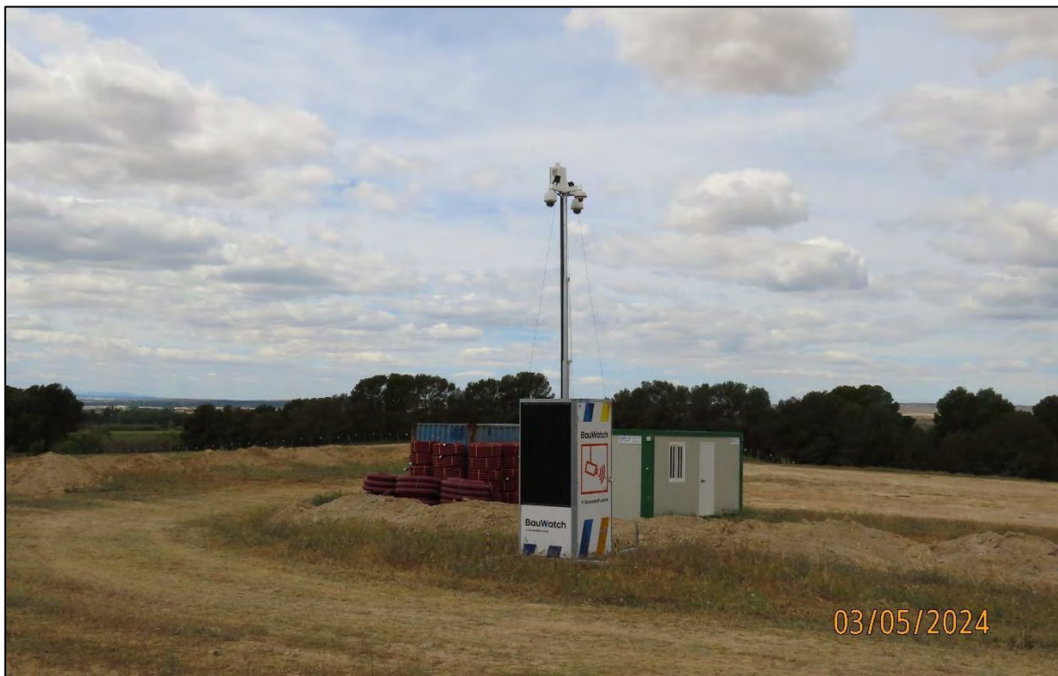
Ilustración 11. Instalación del sistema de videovigilancia.
