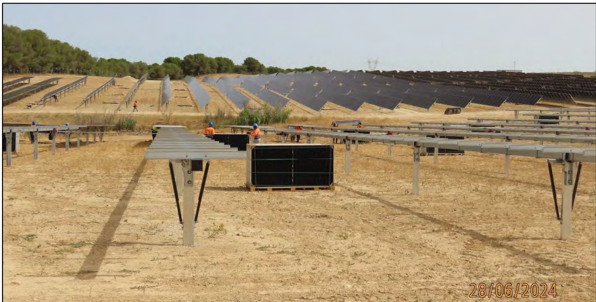
Ilustración 24. Instalación de paneles fotovoltaicos.
