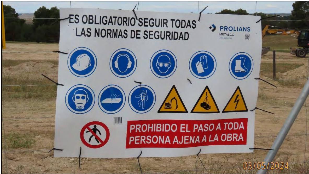
Ilustración 10. Colocación de la señalización de obra.
