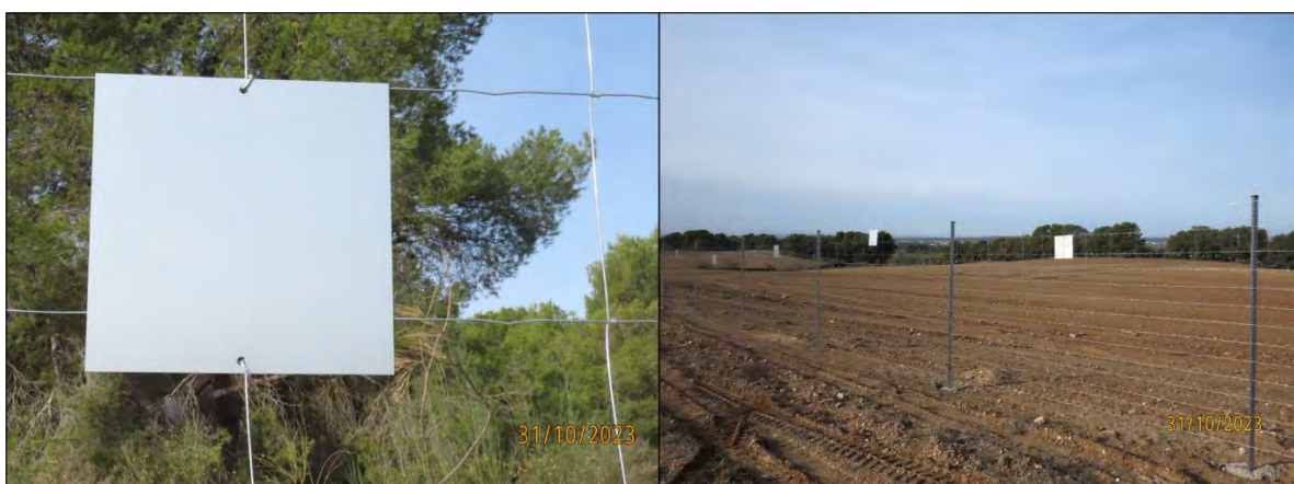
Ilustración 5. Ejecución del vallado perimetral e instalación de las placas que lo visibilizan ante la fauna.
