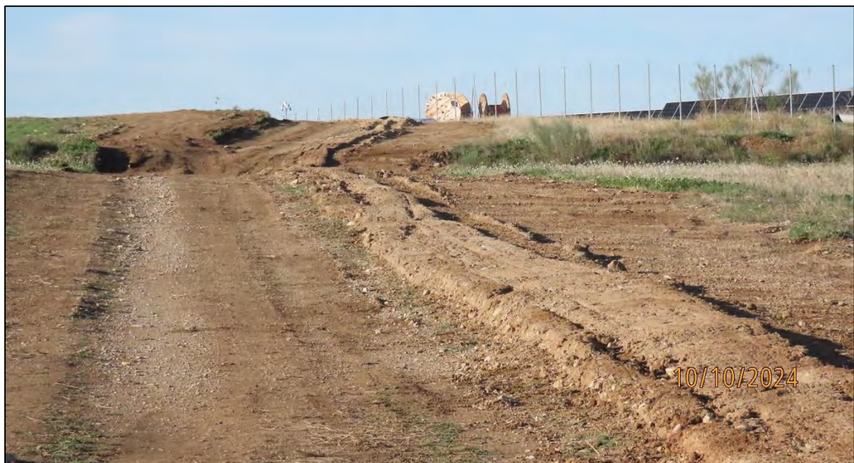
Ilustración 40. Zanja que alberga la LSMT tapada.
