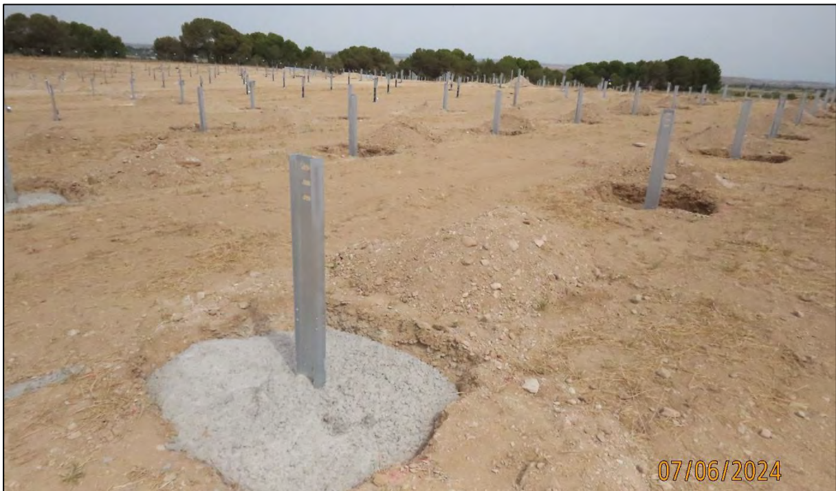
Ilustración 20. Cimentación de las zapatas de las hincas.
