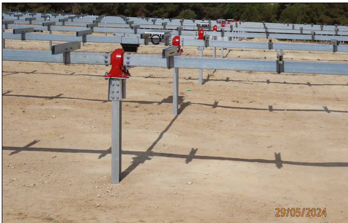
Ilustración 17. Instalación de las estructuras de los seguidores.
