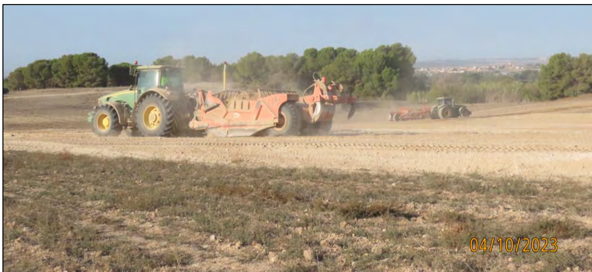
Ilustración 3. Preparación del terreno con traíllas.
