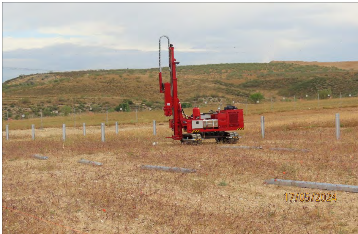
Ilustración 16. Trabajos de hincadora.
