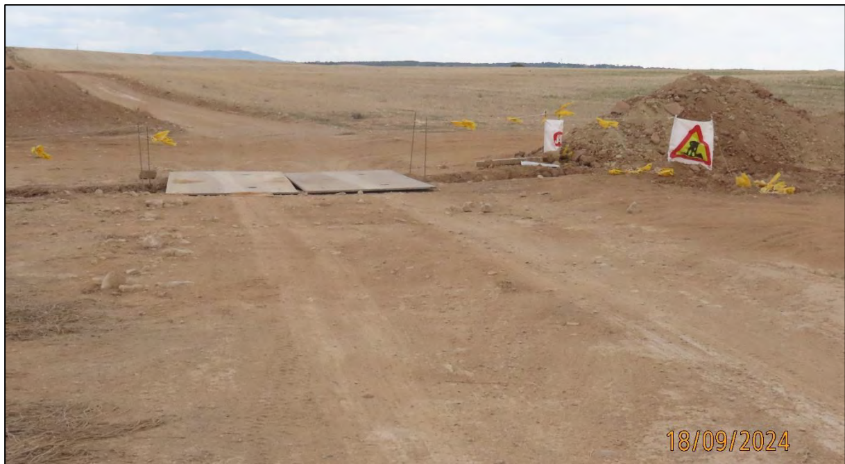
Ilustración 33. Señalización en camino atravesado por la obra, con reposición de camino mediante puente sobre la zanja.
