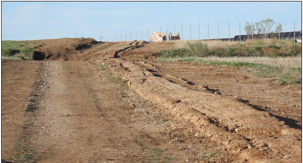
Ilustración 4. Zanja que alberga la LSMT tapada.
