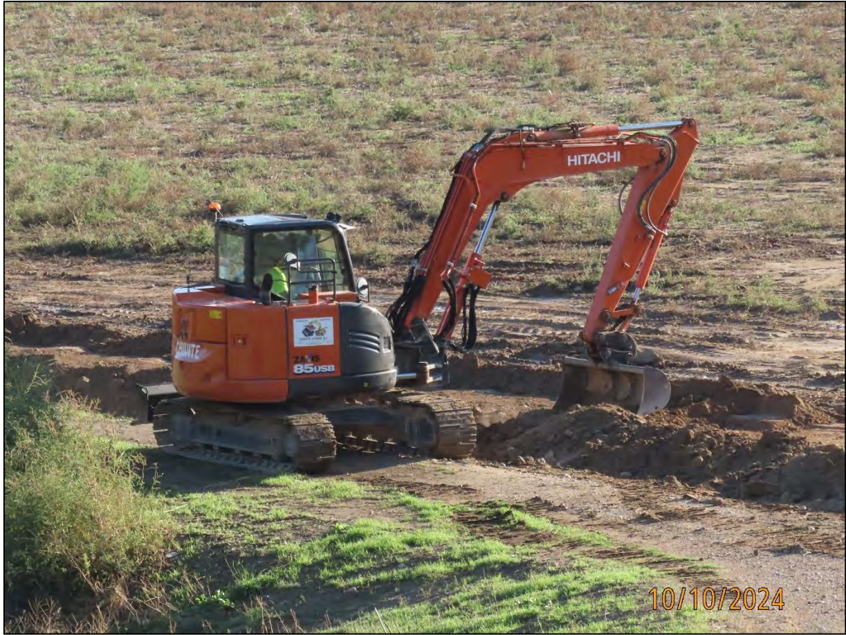
Ilustración 3. Tapado de la zanja que alberga la LSMT.
