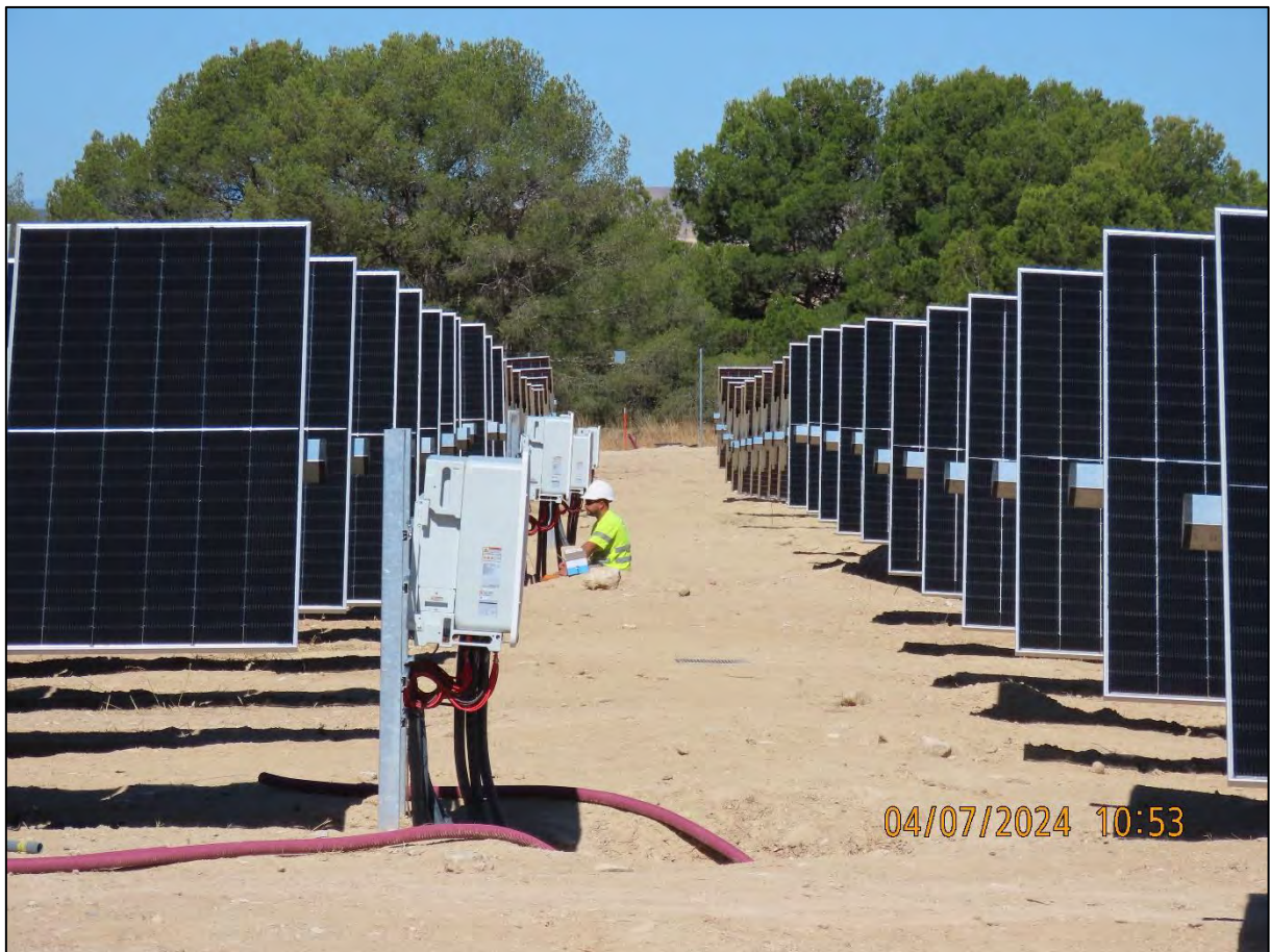
Ilustración 5. Instalación de cableado en el interior de las instalaciones.
