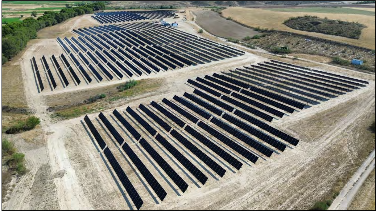
Ilustración 4. Finalización de la instalación de paneles solares (26/07/2024).
