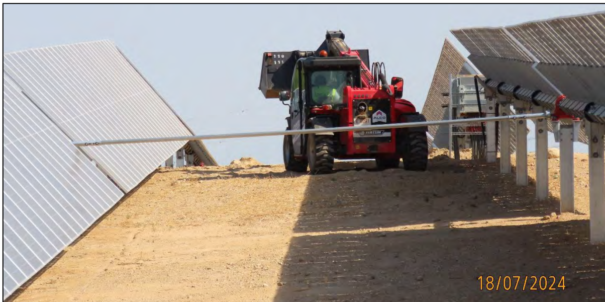
Ilustración 3. Recepción y acopio de materiales.
