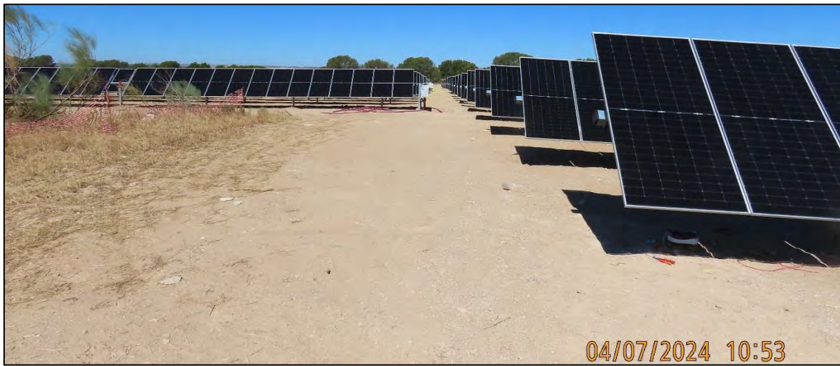
Ilustración 2. Acondicionamiento de los viales interiores.
