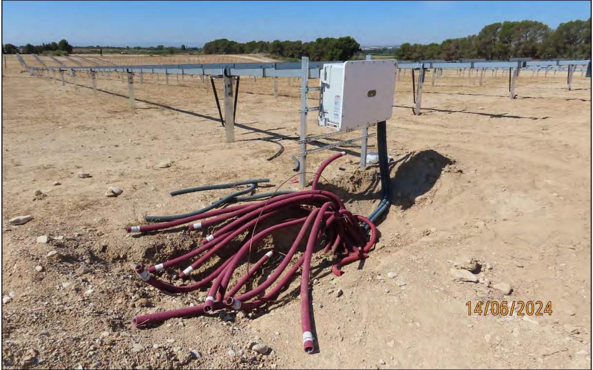
Ilustración 3. Colocación de tuberías de cableado y tapado de zanjas.
