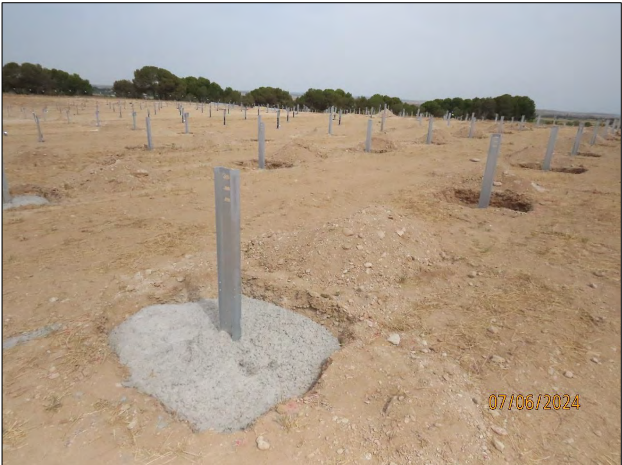
Ilustración 2. Cimentación de las zapatas de las hincas.
