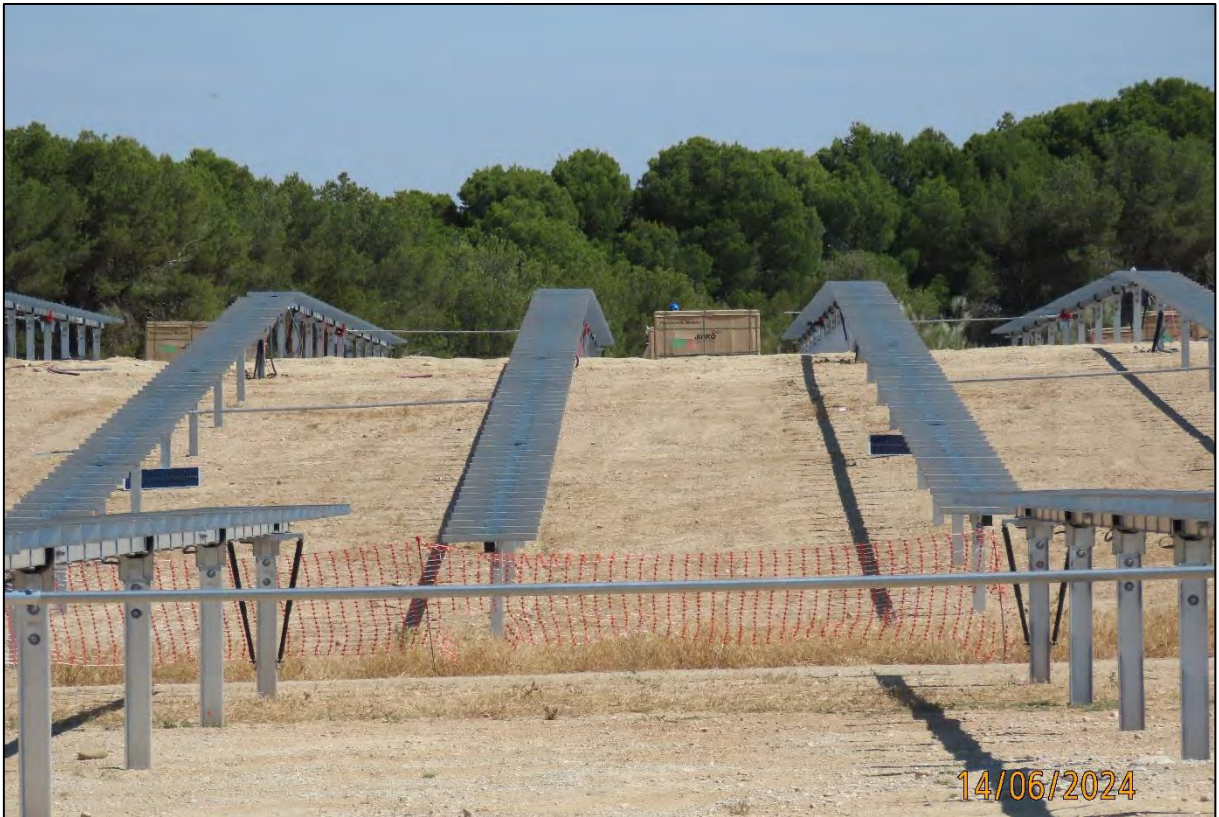
Ilustración 4. Finalización del montaje de las estructuras de los seguidores.
