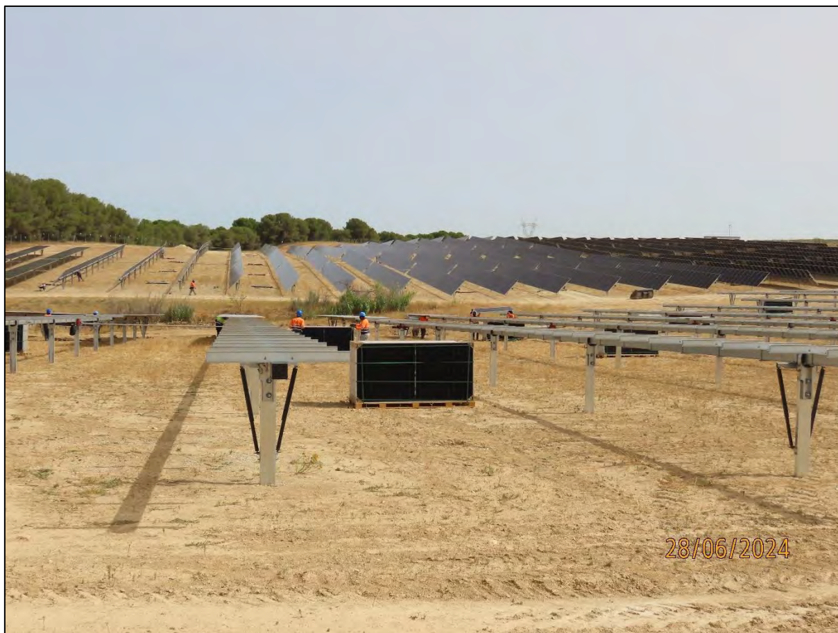
Ilustración 6. Instalación de paneles fotovoltaicos.
