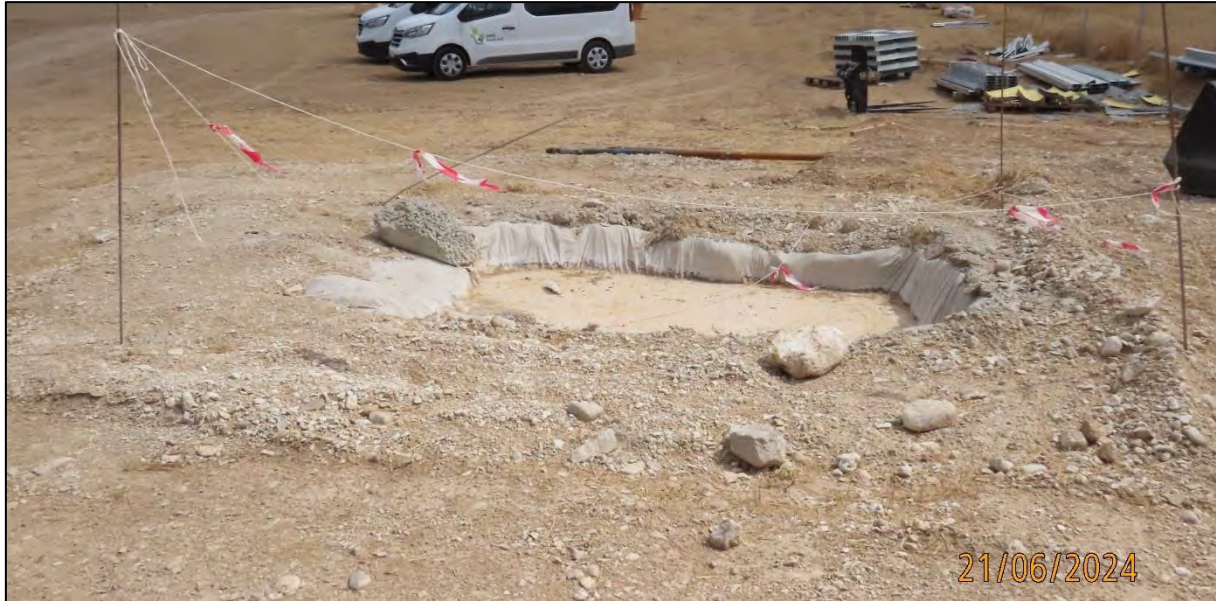
Ilustración 7. Zona impermeable destinada al lavado de las hormigoneras.
