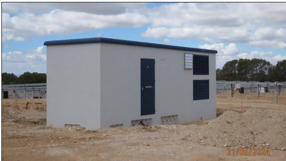
Ilustración 5. Instalación del centro de seccionamiento.
