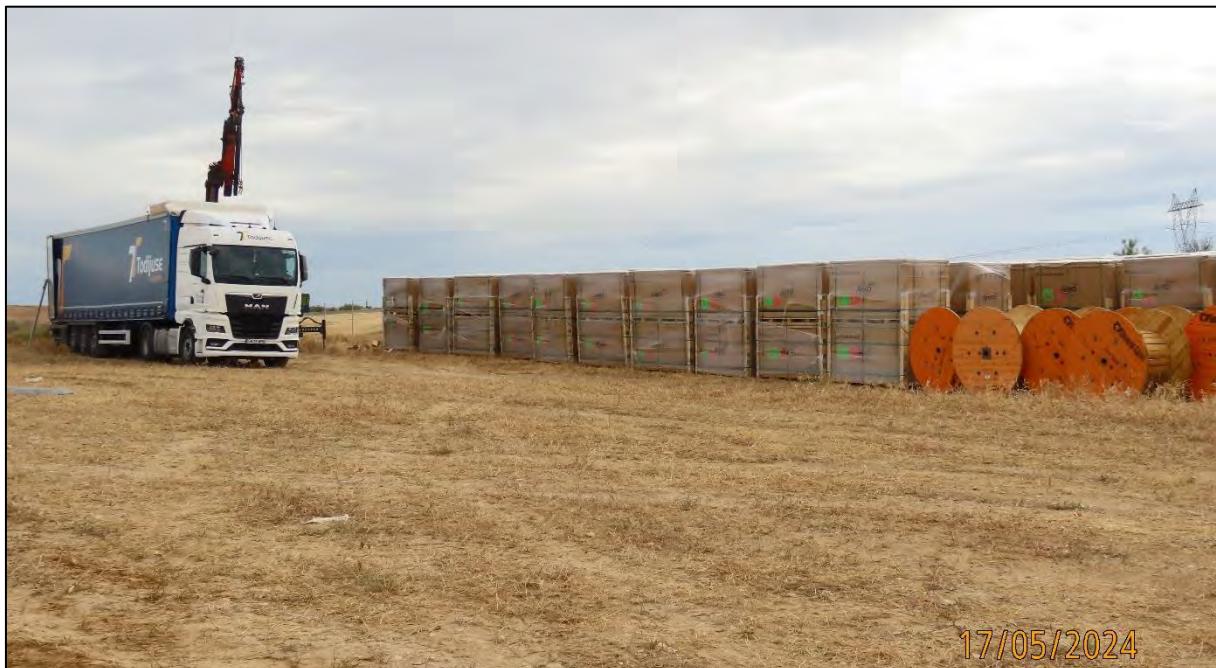
Ilustración 2. Recepción y acopio de materiales.
