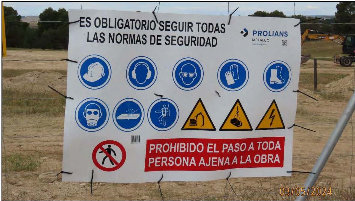
Ilustración 3. Colocación de la señalización de obra.
