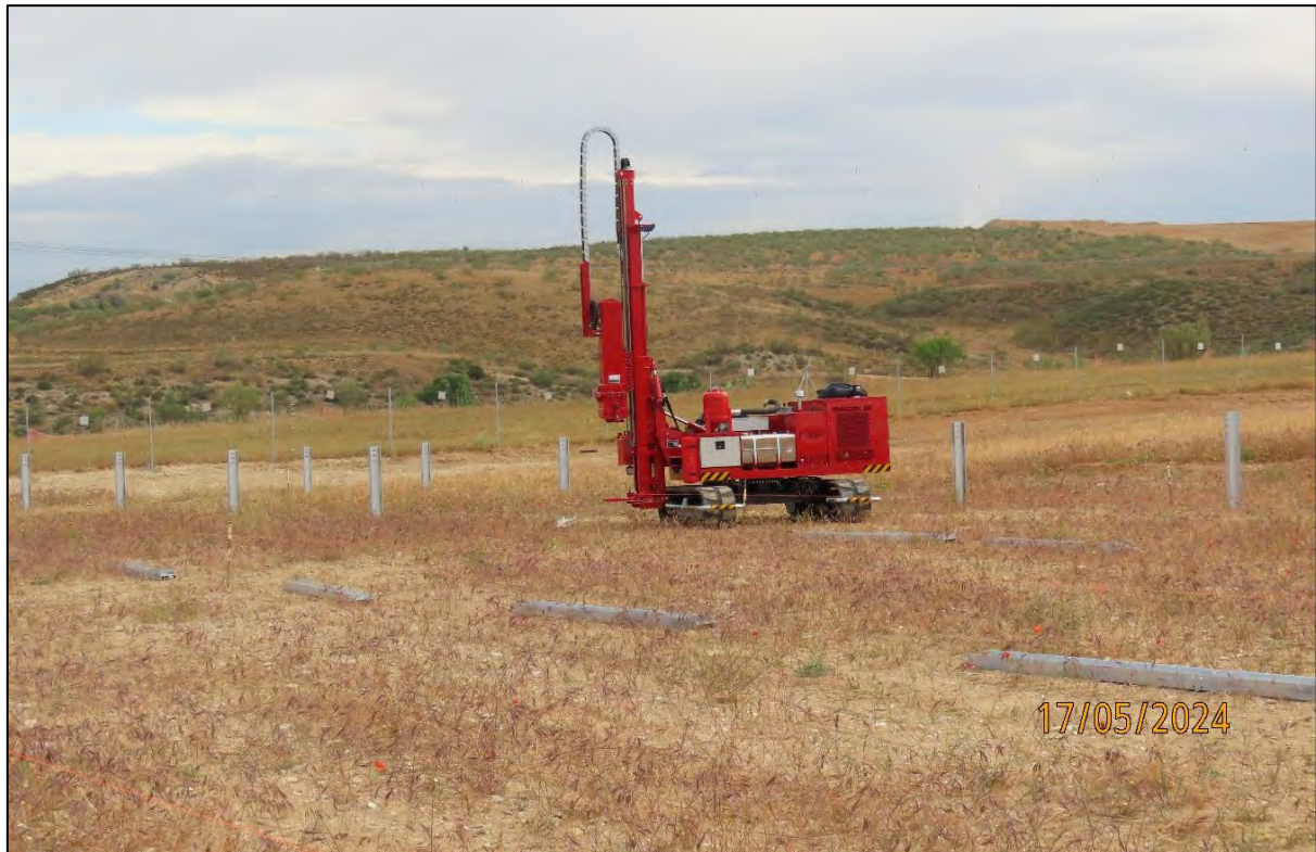
Ilustración 9. Trabajos de hincadora.
