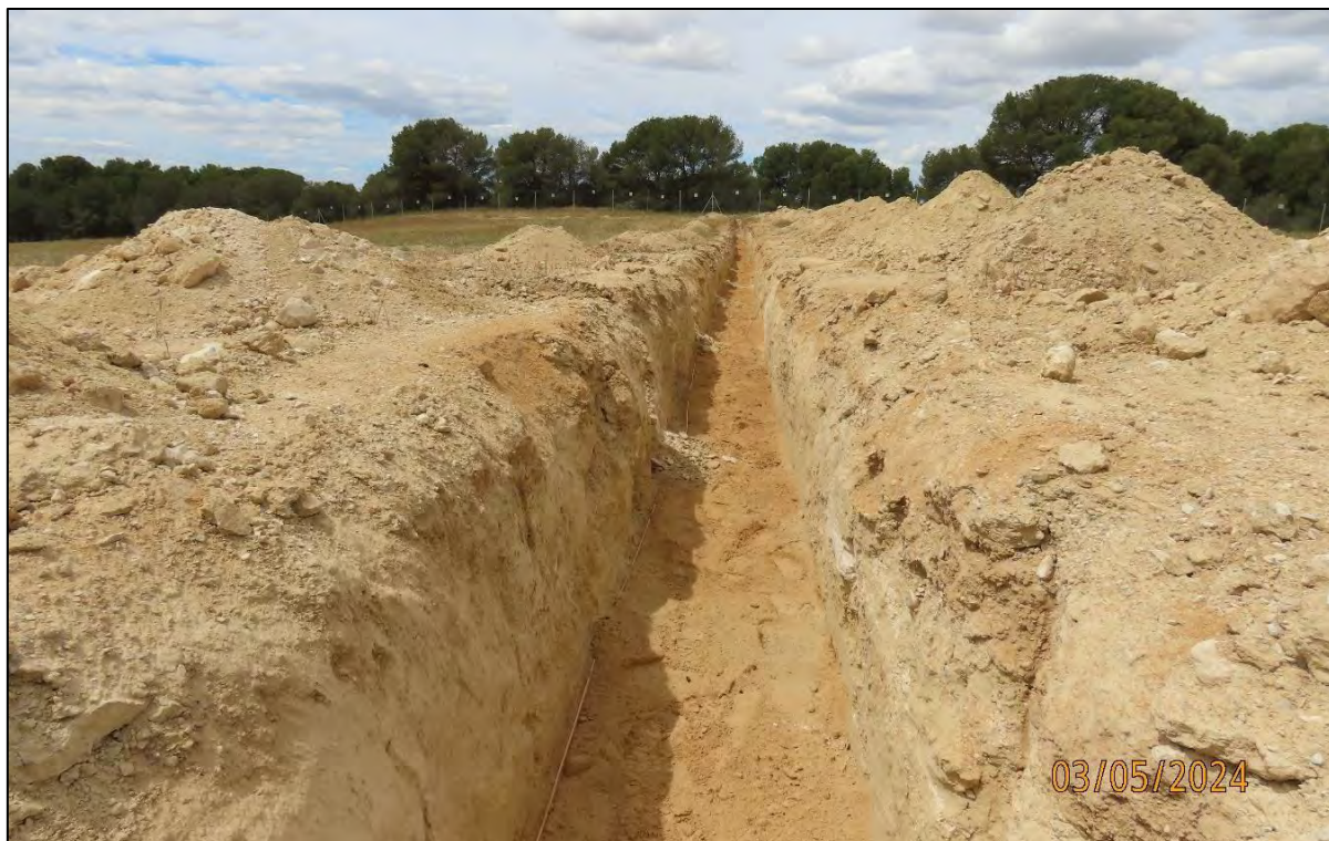
Ilustración 6. Apertura de zanjas y acopio de tierra vegetal.
