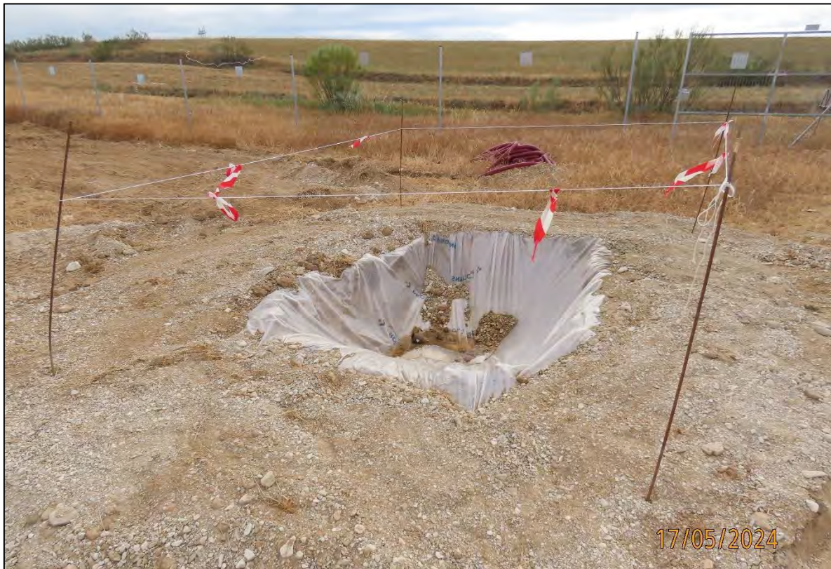
Ilustración 14. Habilitación de zona impermeable para el lavado de las cubas de hormigón.
