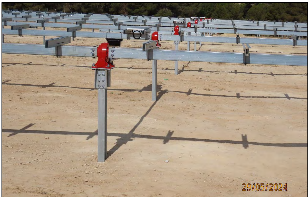
Ilustración 10. Instalación de las estructuras de los seguidores.
