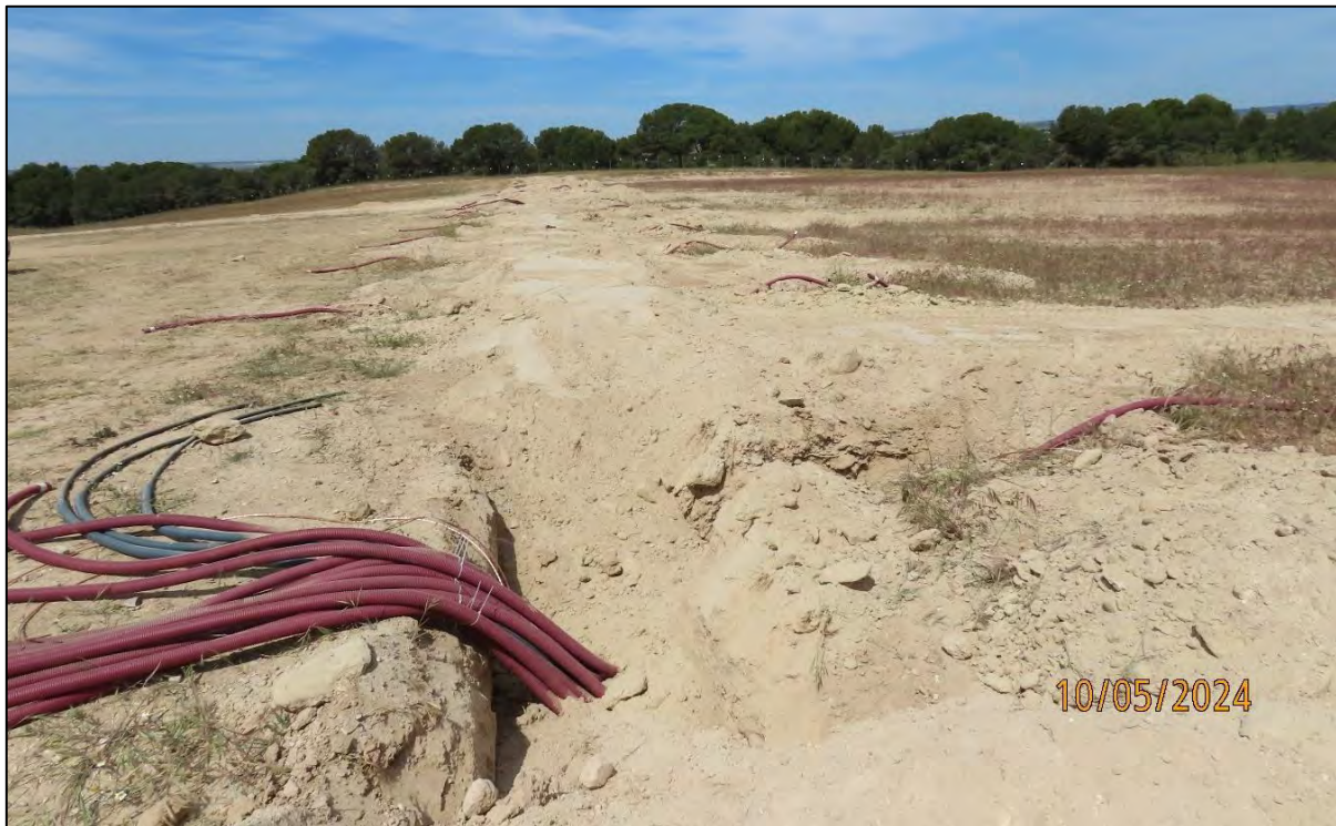
Ilustración 8. Colocación de cableado y tapado de zanjas.
