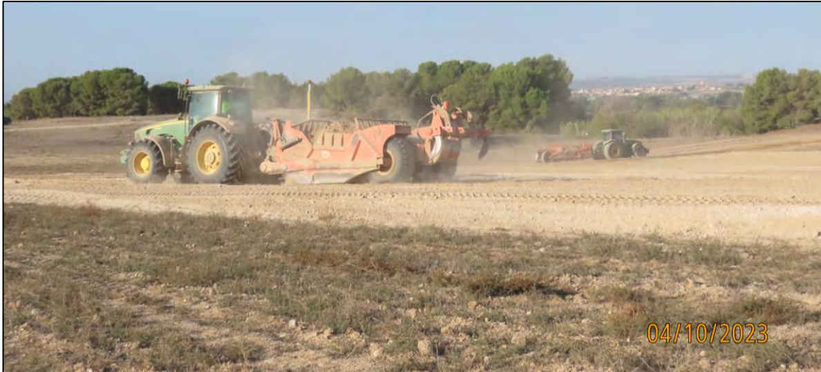
Ilustración 3. Movimiento de tierras y preparación del terreno con traíllas.
