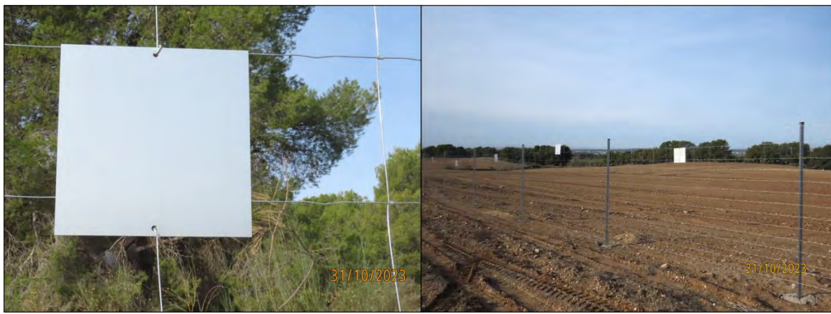
Ilustración 13. Ejecución del vallado perimetral y colocación de las placas que lo visibilizan ante la fauna.
