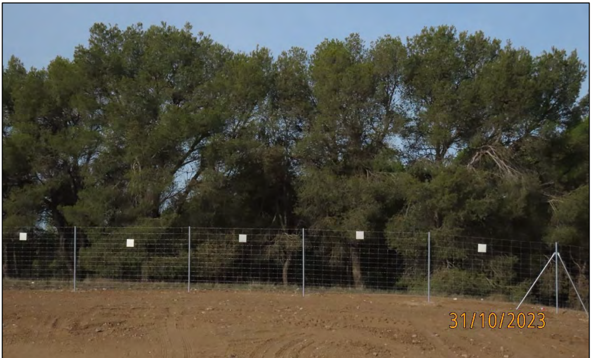
Ilustración 4. Instalación del vallado perimetral y de los elementos que lo visibilizan a la avifauna.
