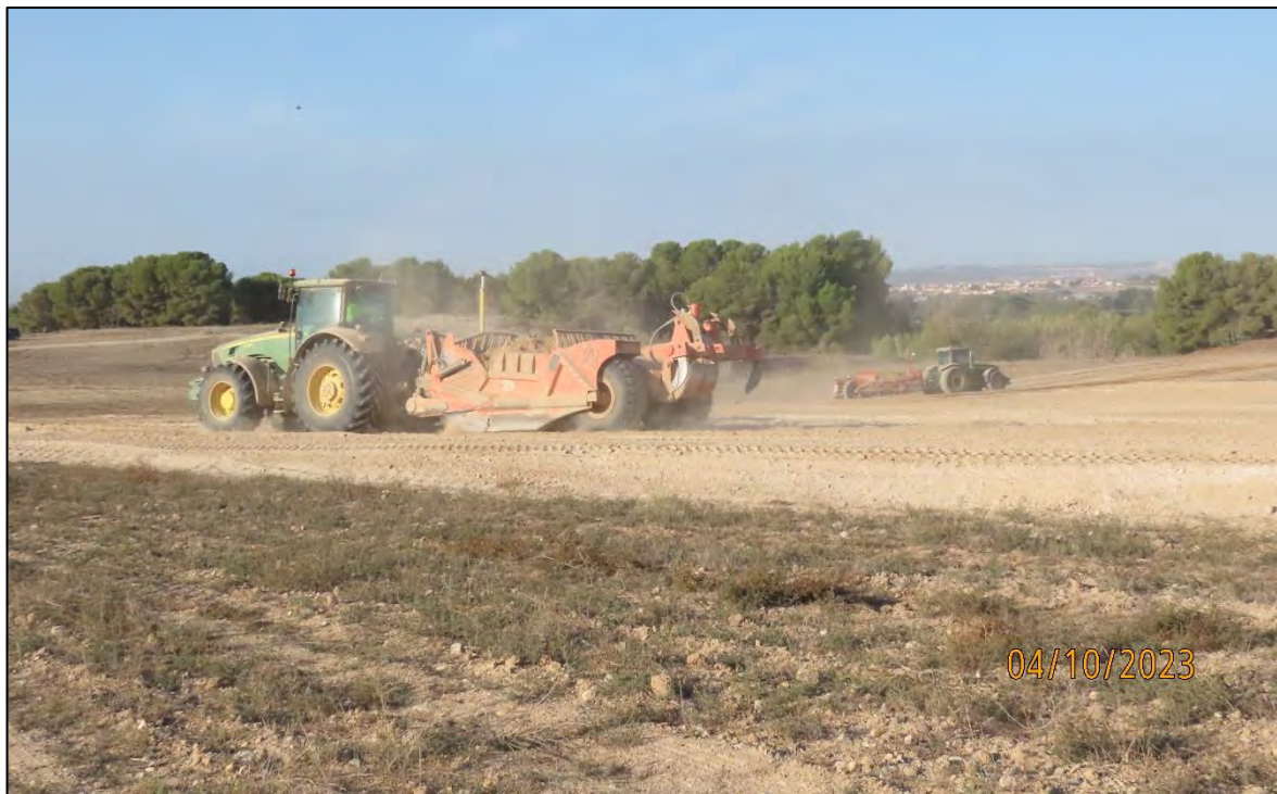
Ilustración 6. Preparación del terreno con traíllas.
