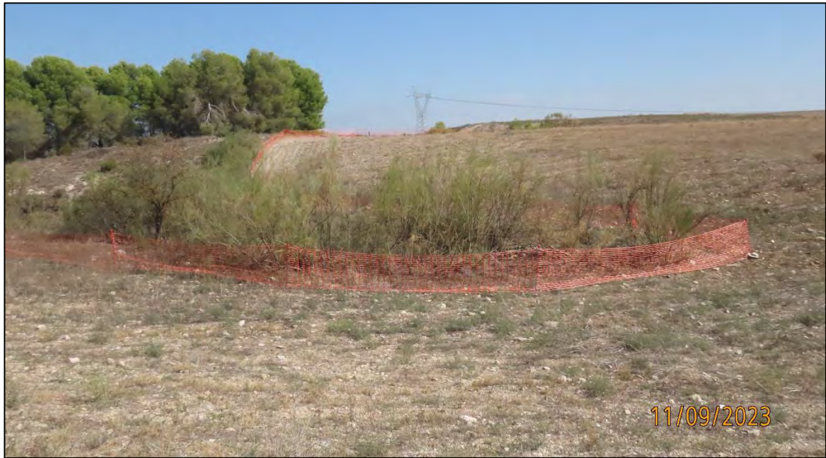
Ilustración 2. Balizamiento de las zonas de vegetación natural a preservar.
