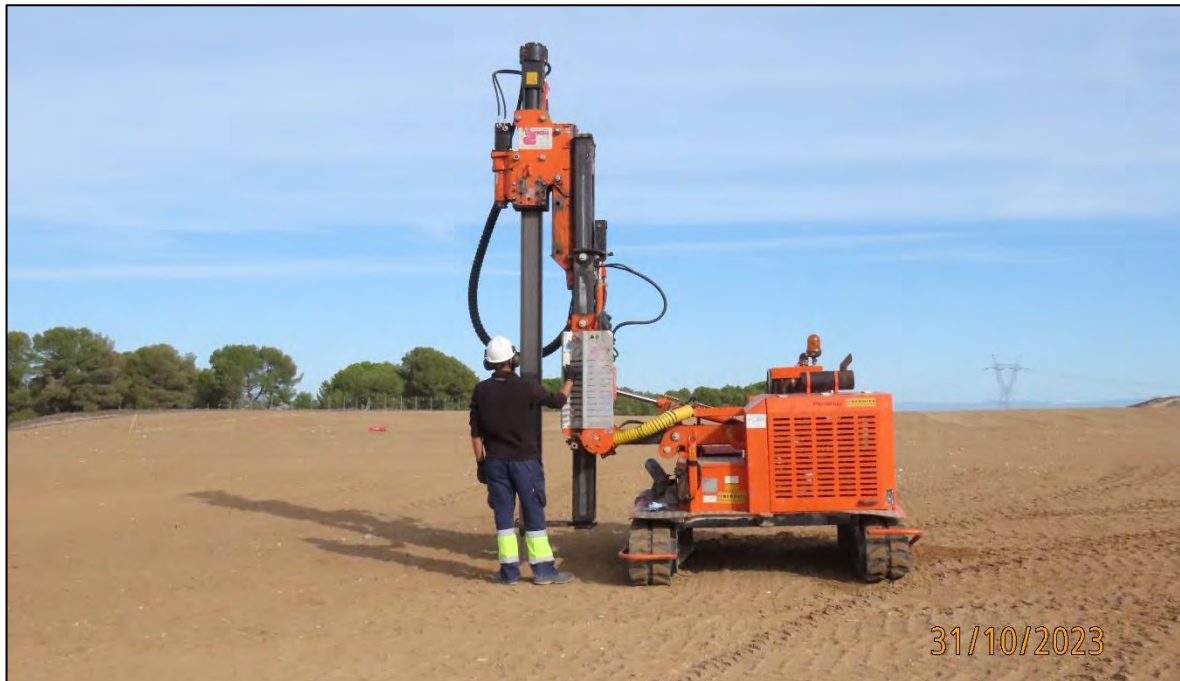
Ilustración 9. Pruebas de hincado con hincadora.
