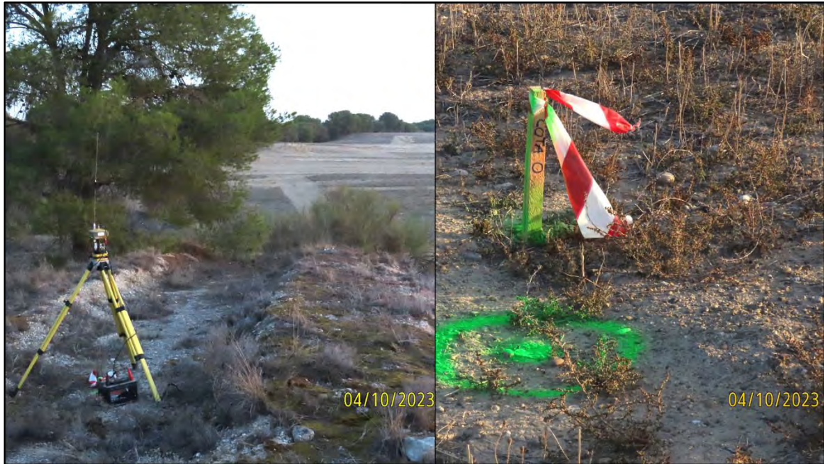
Ilustración 5. Sistema telemático de nivelado del terreno.
