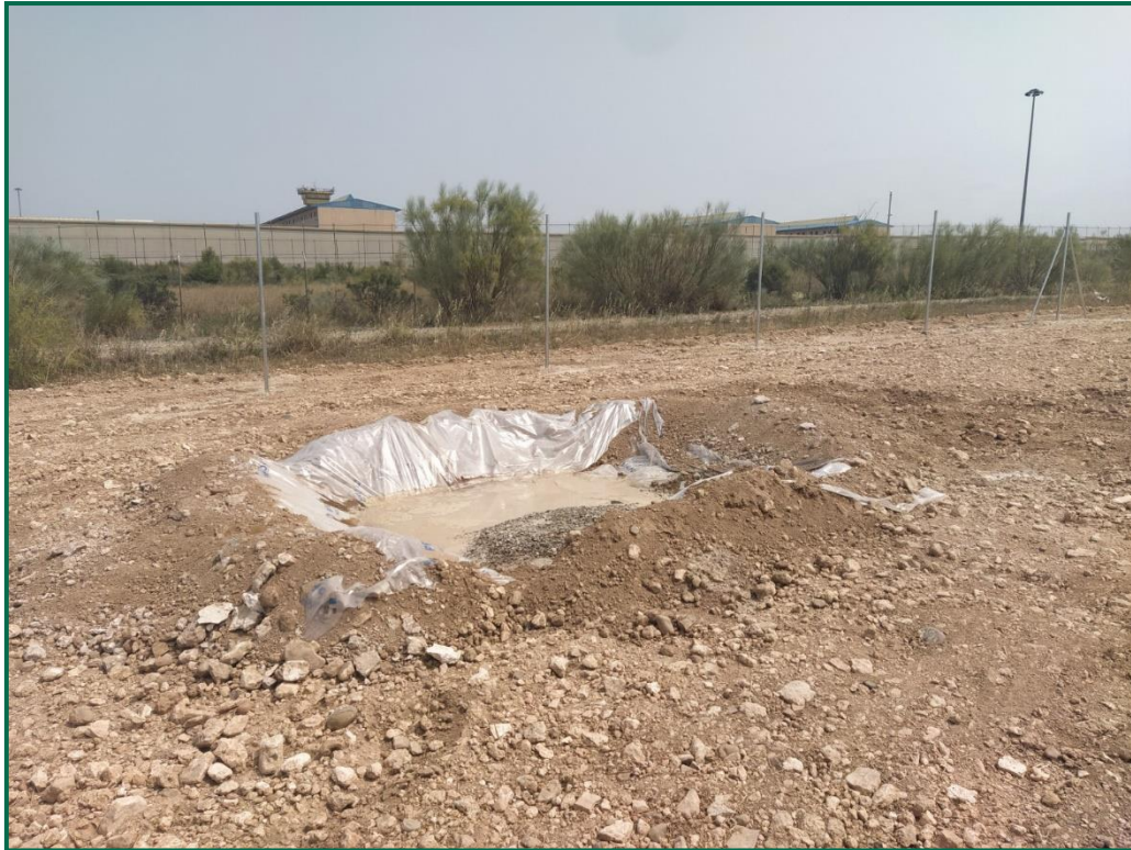
Fotografía 6. Zona para el lavado de canaletas.
