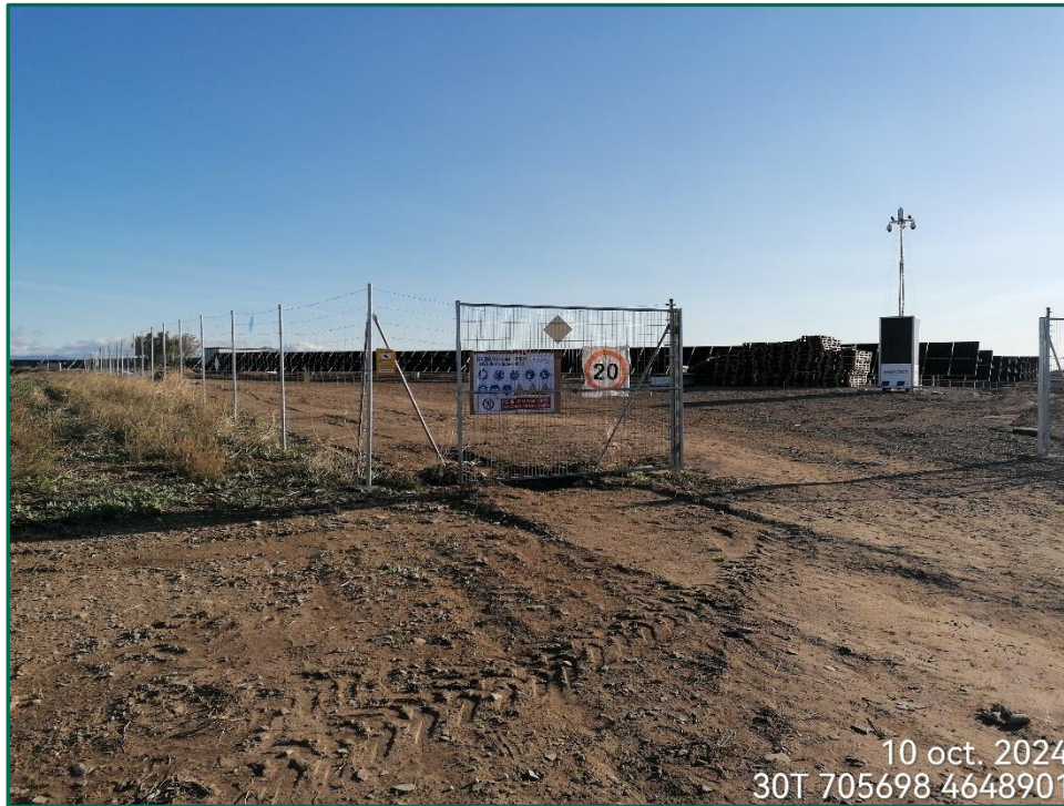
Fotografía 4. Vallado perimetral y puertas actualmente.
