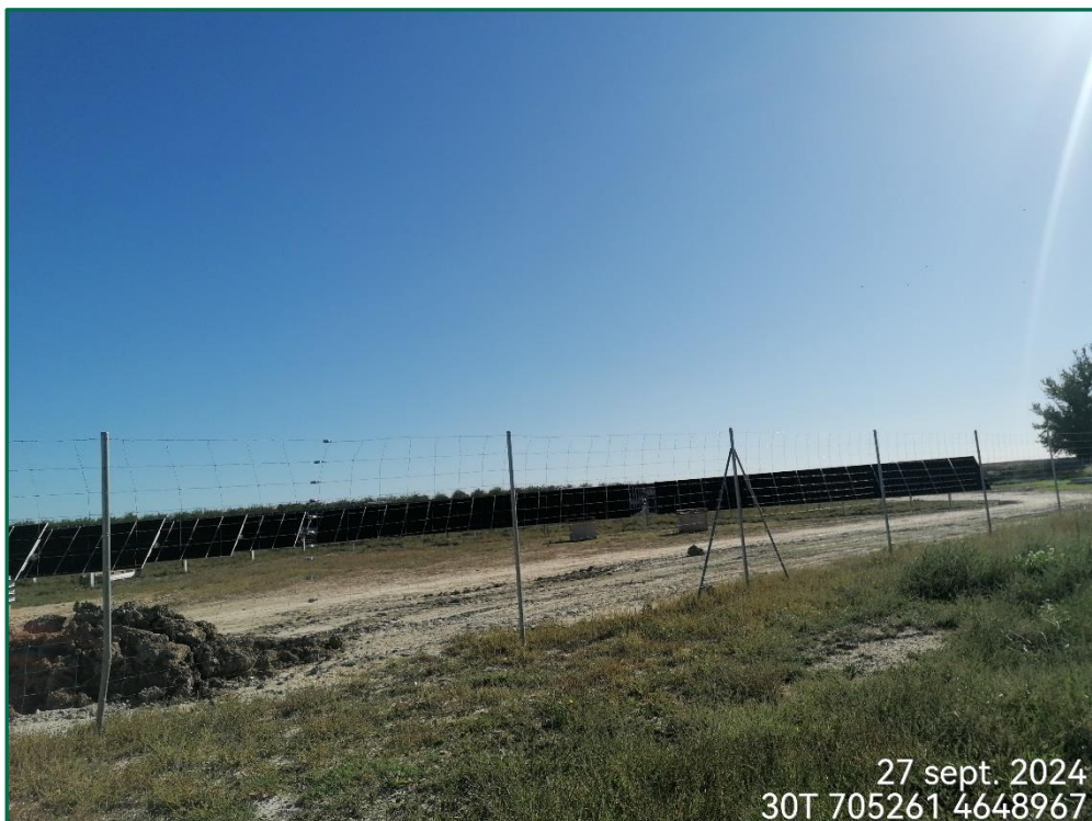
Fotografía 3. Vallado perimetral actualmente.
