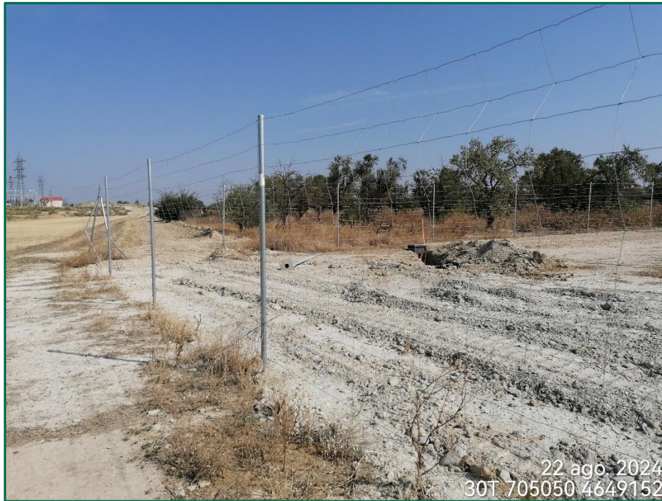
Fotografía 4. Vallado perimetral actualmente.
