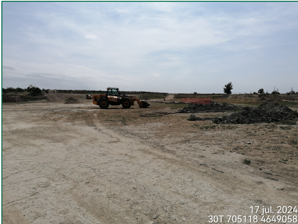
Fotografía 5. Superficie de la planta.
