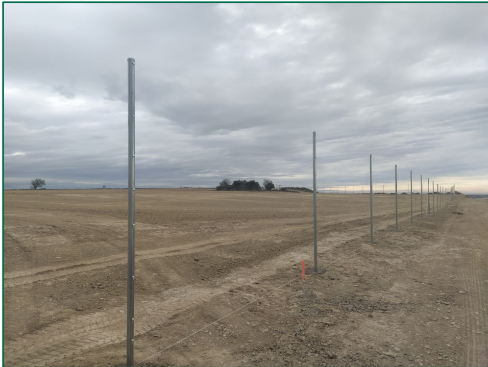
Fotografía 2. Postes de vallado y estacas de balizado (mes de noviembre).
