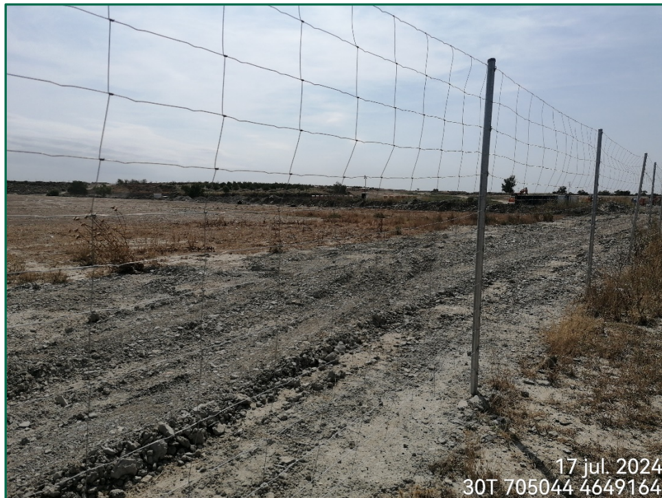
Fotografía 4. Vallado perimetral actualmente.
