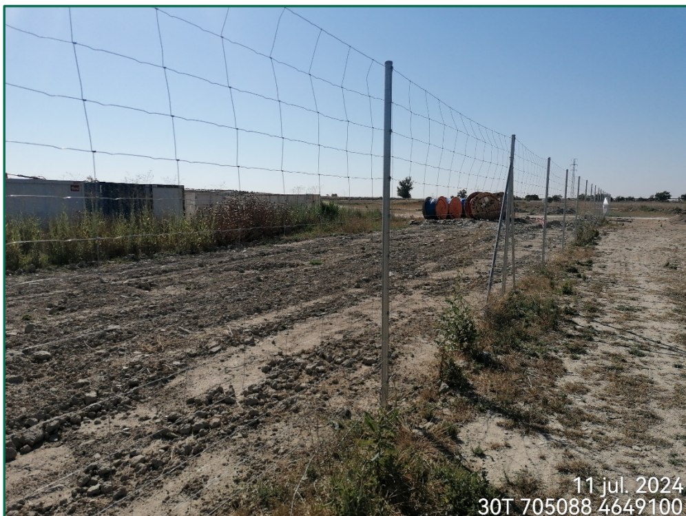
Fotografía 3. Vallado perimetral actualmente.
