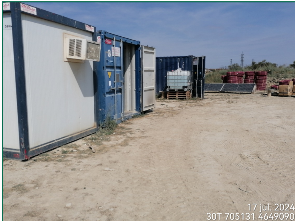
Fotografía 12. Contenedor donde se ubica el punto limpio de residuos peligrosos.
