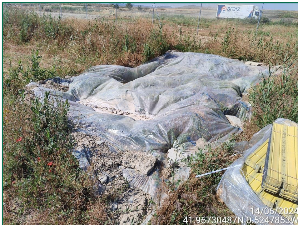
Fotografía 14. Balsa de lavado de hormigón.
