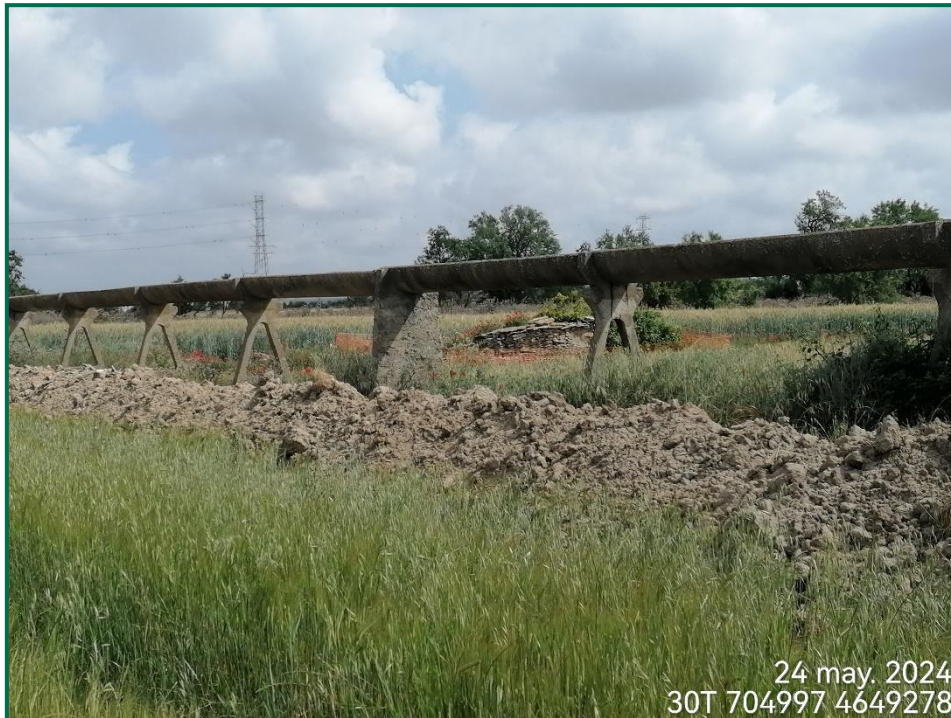
Fotografía 13. Caseta Grameros balizada.
