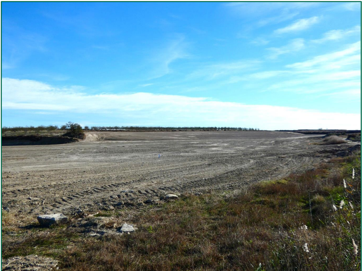
Fotografía 1. Jalonamiento previo (mes de noviembre).
