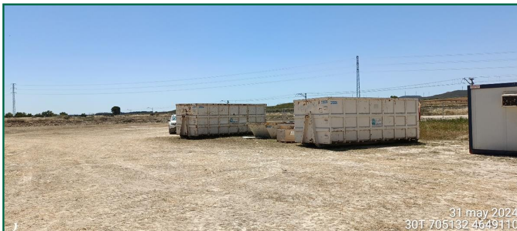
Fotografía 10. Conenedores para residuos inertes.
