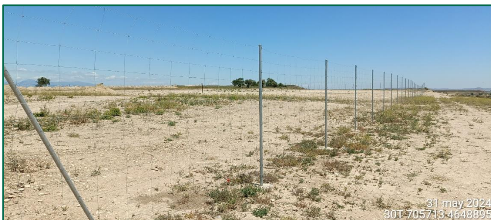
Fotografía 3. Vallado perimetral actualmente.
