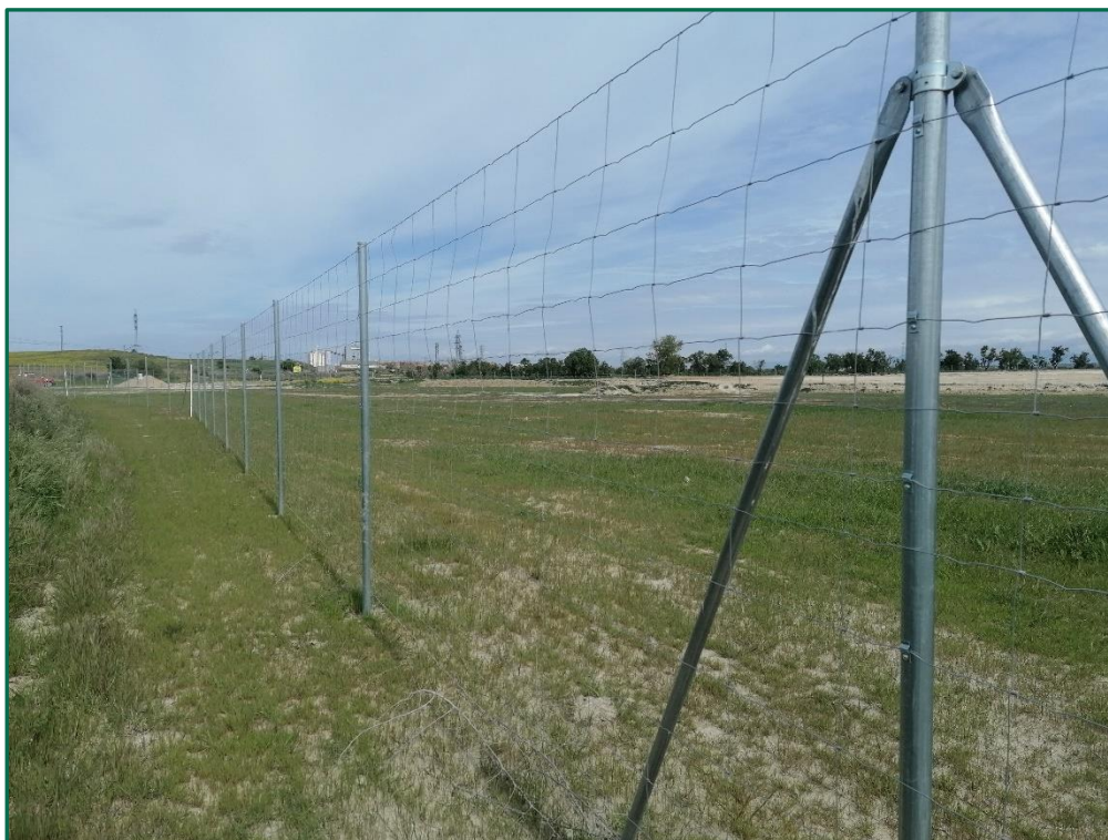
Fotografía 3. Vallado perimetral actualmente.
