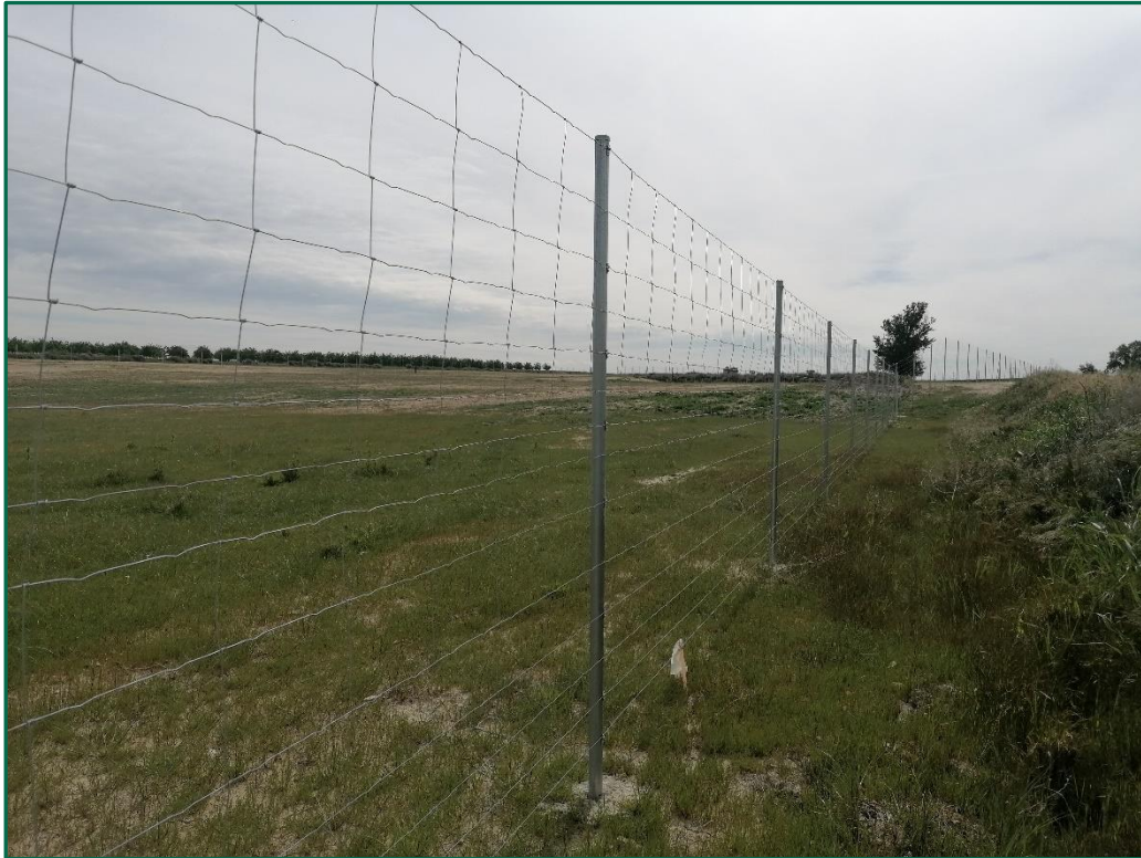
Fotografía 4. Vallado completado con malla cinegética.
