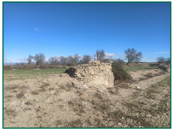
Fotografía 10. Caseta Grameros balizada.
