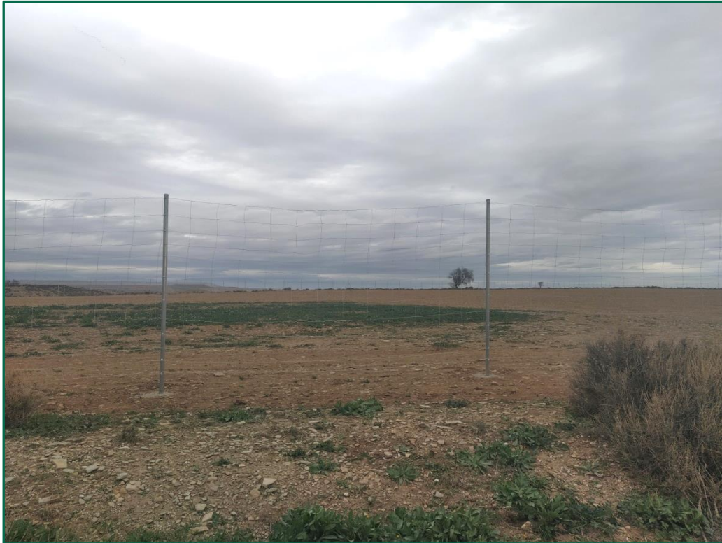
Fotografía 4. Malla cinegética en proceso de colocación.
