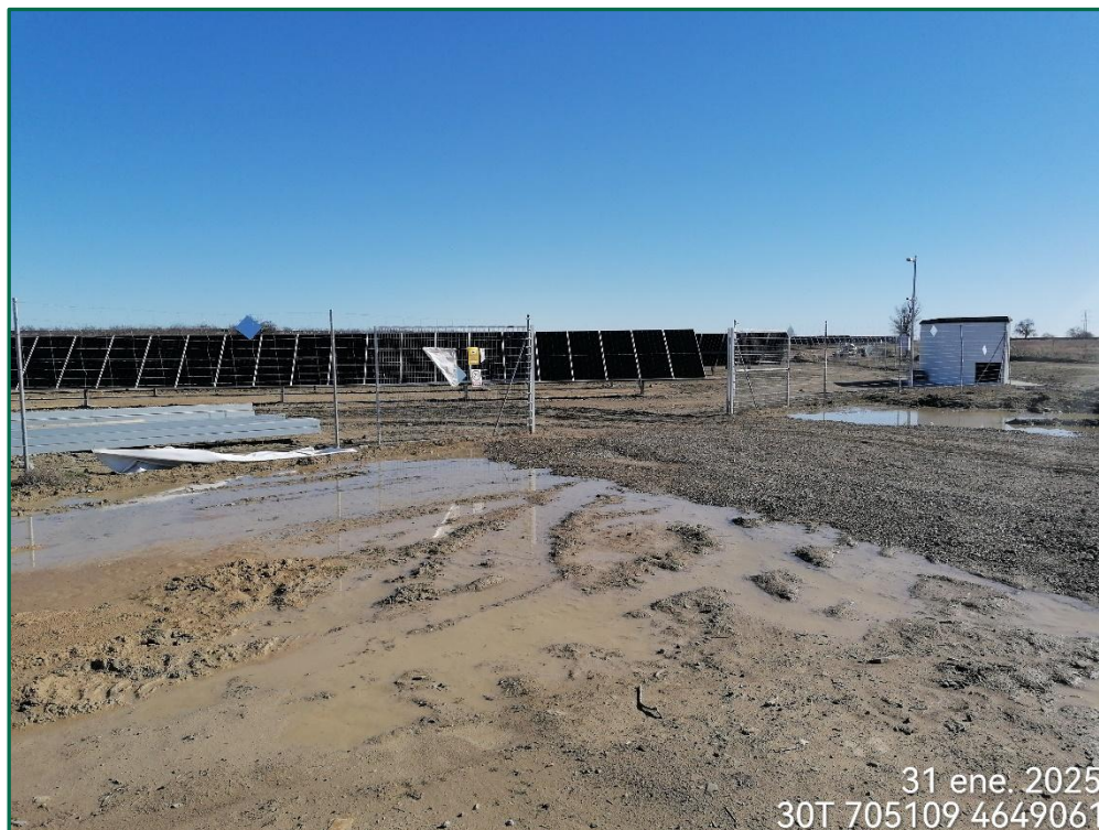
Fotografía 4. Vallado perimetral y puertas actualmente.
