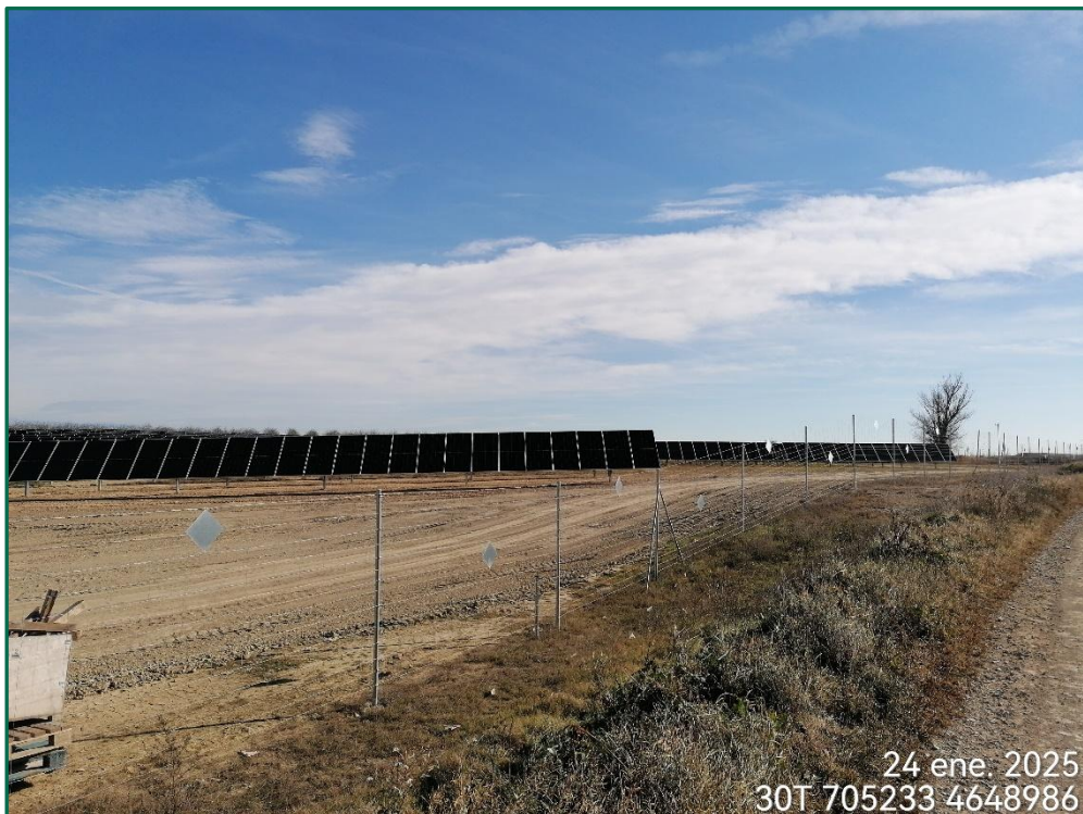
Fotografía 3. Vallado perimetral actualmente.
