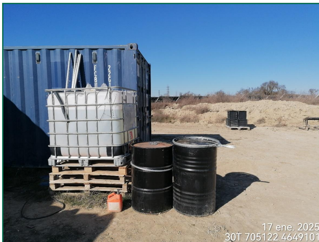
Fotografía 12. Bidones para residuos peligrosos antes de su retirada.
