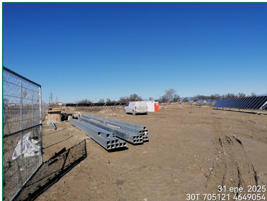
Fotografía 11. Zona donde se ubicaban los contenedores para residuos inertes.
