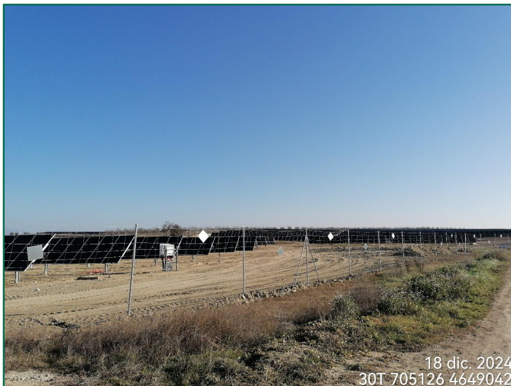
Fotografía 3. Vallado perimetral actualmente.
