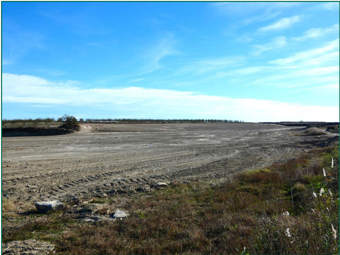
Fotografía 1. Jalonamiento previo (mes de noviembre).
