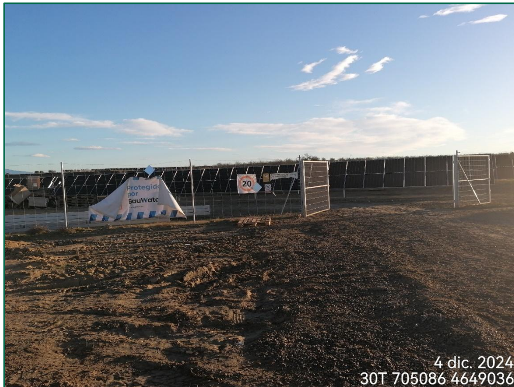
Fotografía 4. Vallado perimetral y puertas actualmente.
