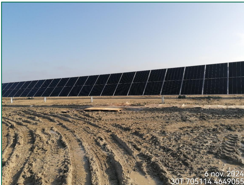
Fotografía 5. Superficie de la planta.
