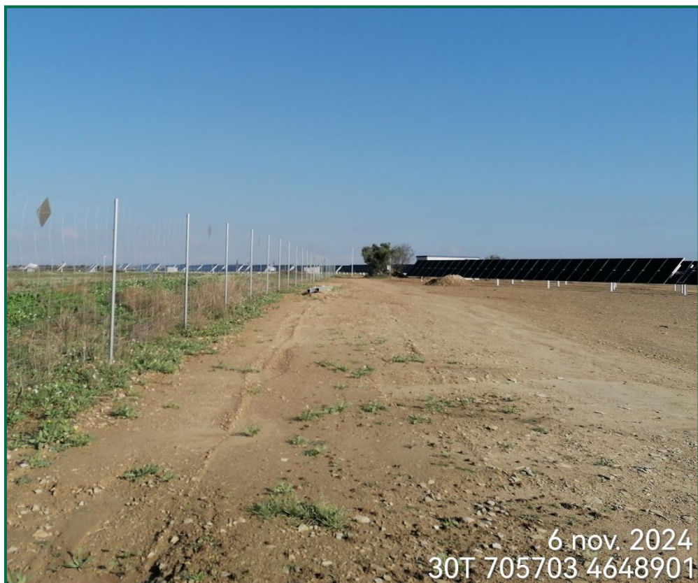
Fotografía 7. Vegetación en el interior, que no se altera.
