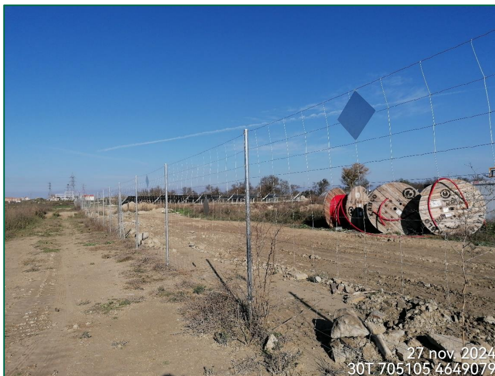
Fotografía 3. Vallado perimetral actualmente.
