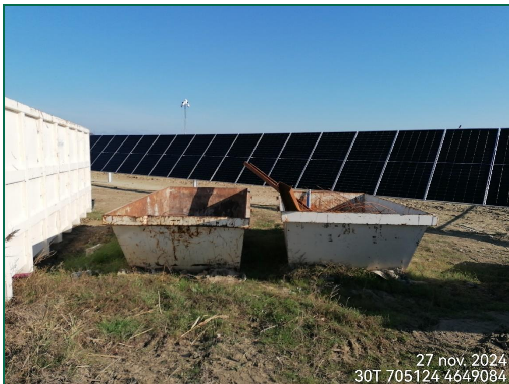
Fotografía 11. Contenedores para residuos inertes.
