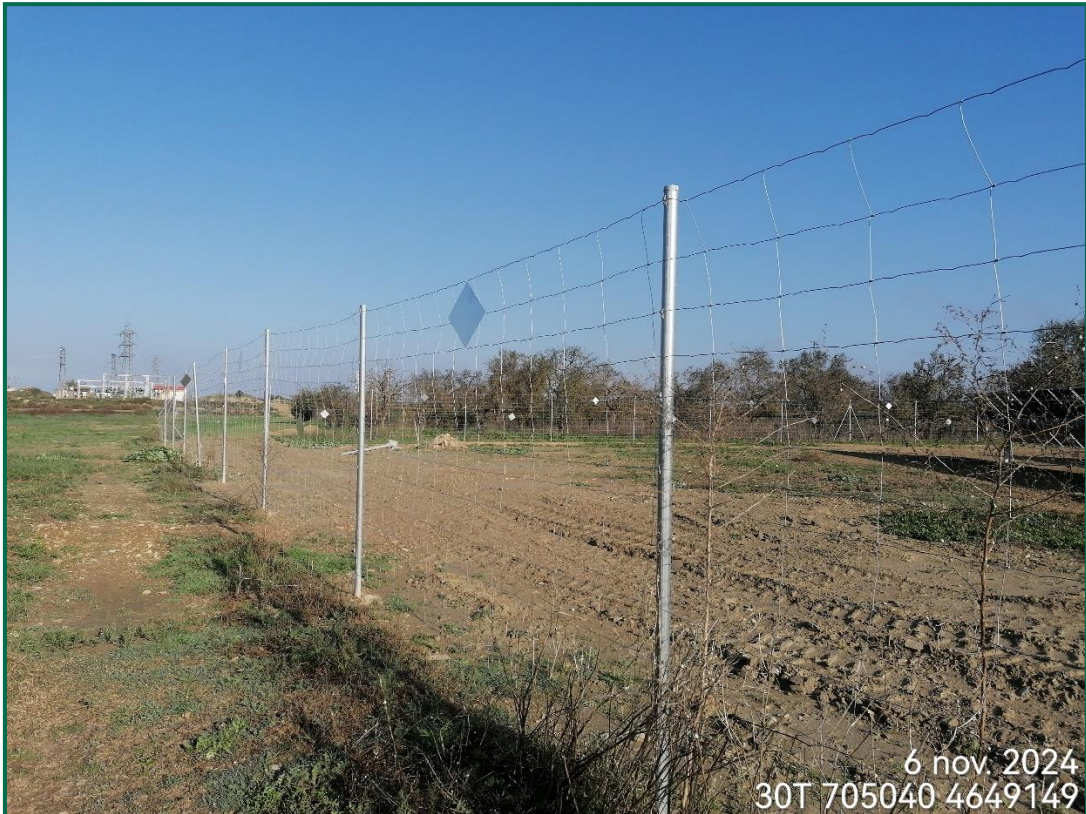
Fotografía 9. Placas anticollisión
