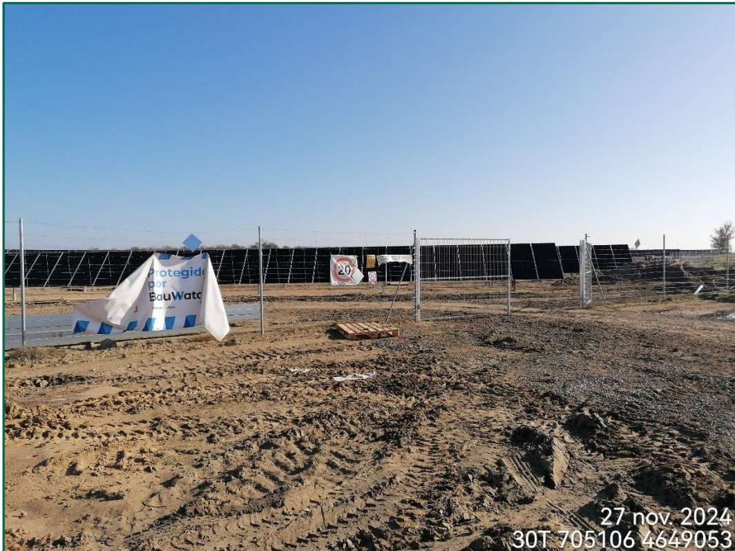
Fotografía 4. Vallado perimetral y puertas actualmente.
