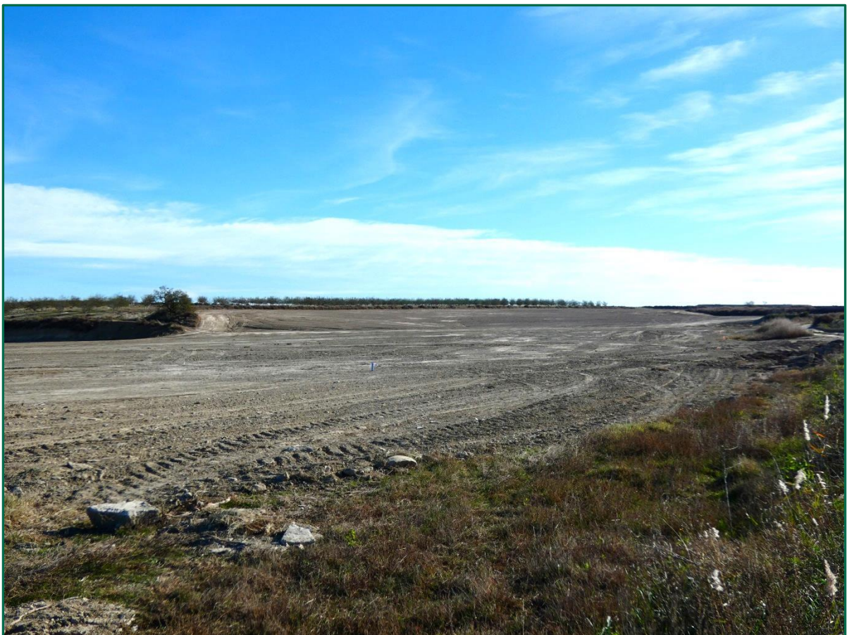
Fotografía 1. Jalonamiento previo (mes de noviembre).
