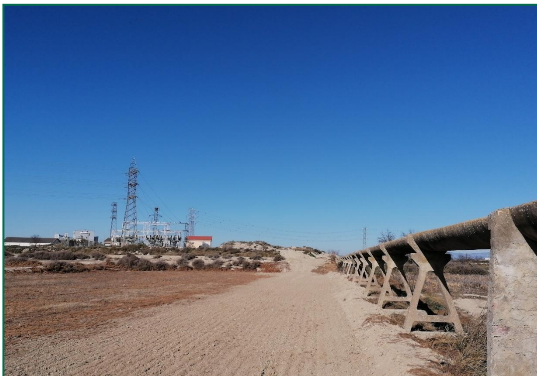
Fotografía 10. Zona de la línea soterrada.
