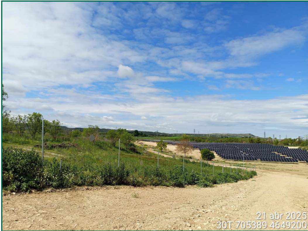
Fotografía 9. Vegetación fuera de la PFV que no se afecta.
