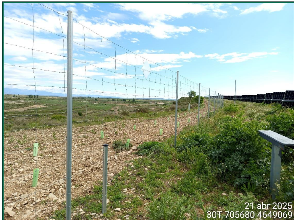
Fotografía 17. Placas anticolidión y pasos de fauna en el vallado perimetral.
