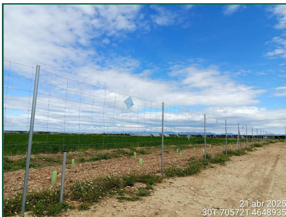
Fotografía 16. Placas anticollisión y pasos de fauna en el vallado perimetral.
