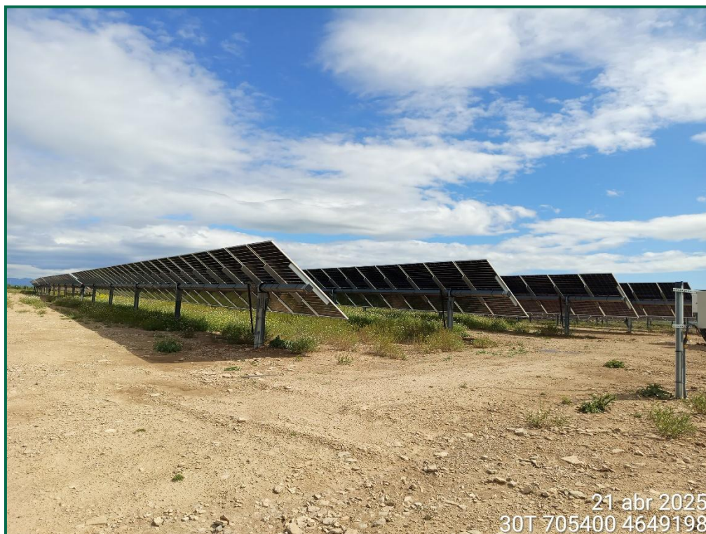
Fotografía 4. Superficie de la PFV.
