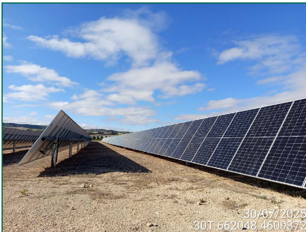
Fotografía 9. Zonas internas con vegetación seca entre seguidores
