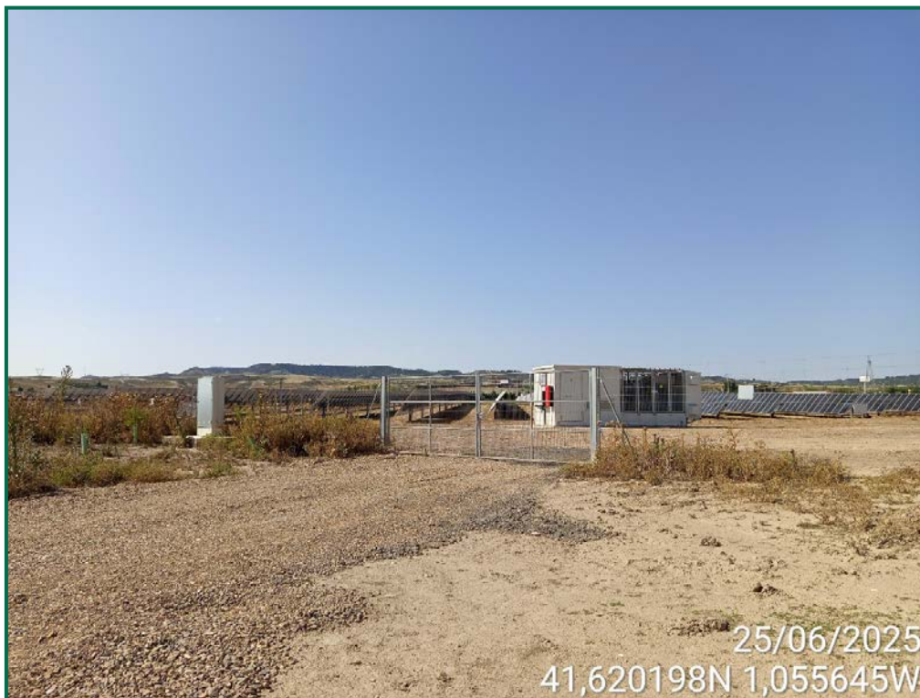
Fotografía 5. Entrada y viales modificados para mejorar la accesibilidad.
