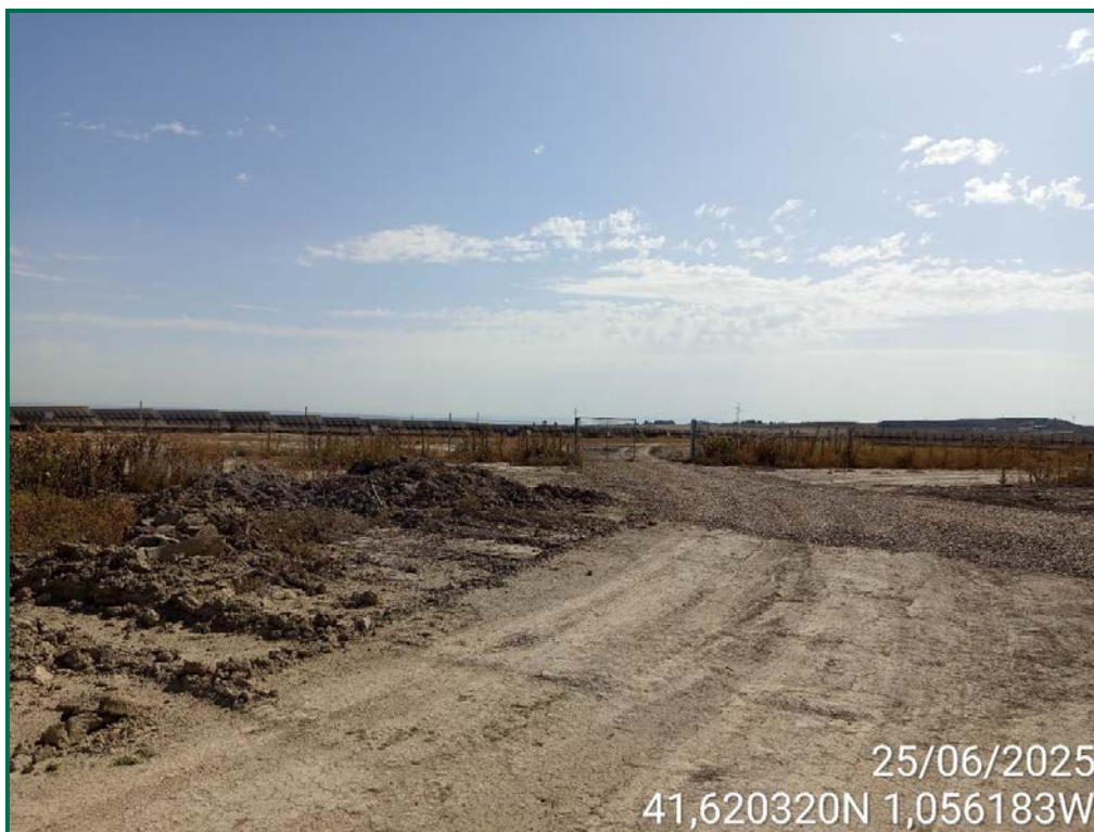
Fotografía 4. Entrada y viales modificados para mejorar la accesibilidad.
