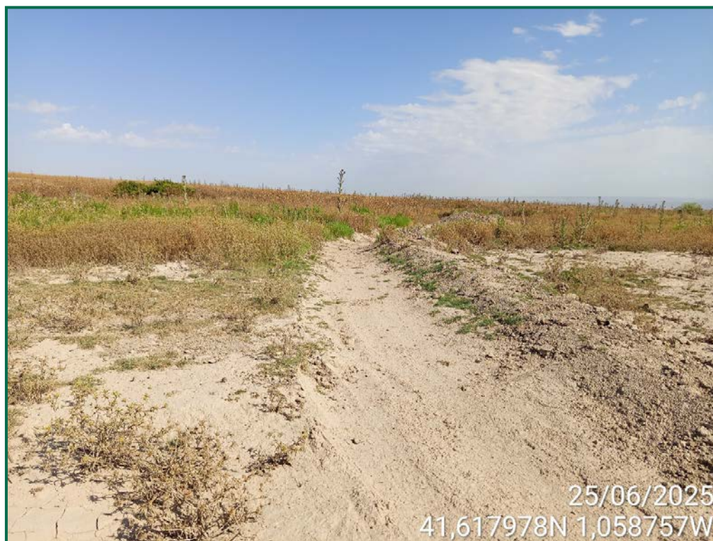
Fotografía 8. Zanja para la canalización del agua.
