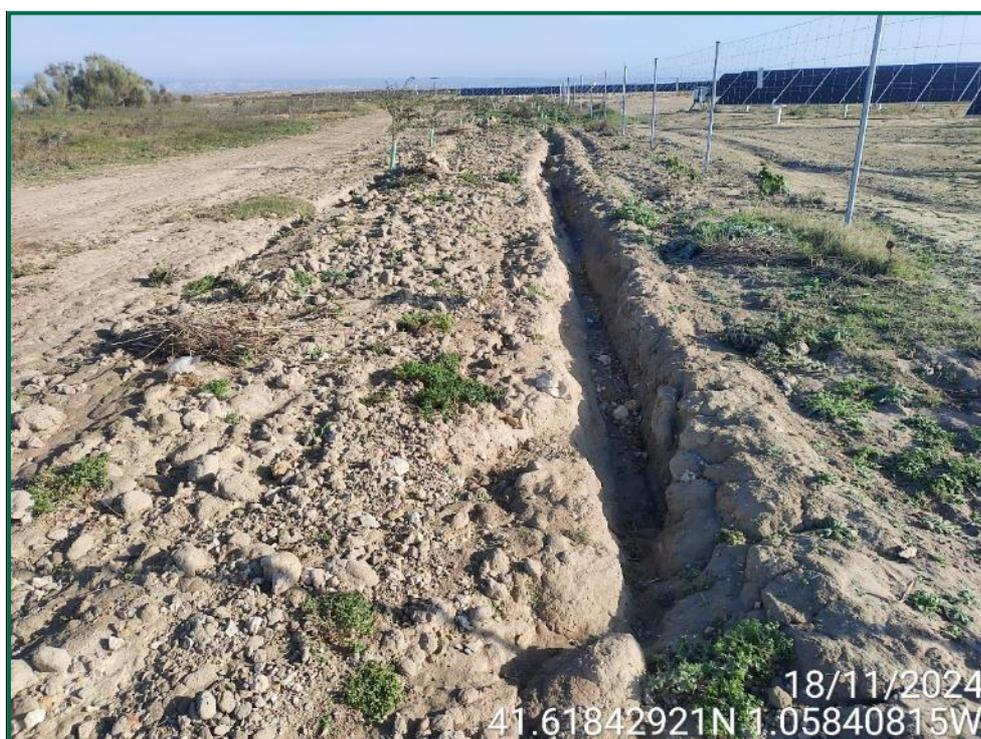
Fotografía 1. Perímetro del vallado con plantaciones y erosión por fuertes lluvias.
