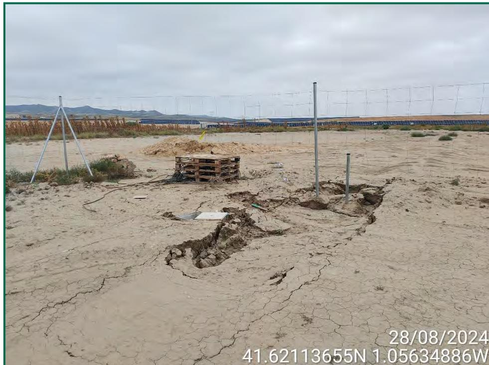
Fotografía 3. Zonas con erosión dentro de la planta fotovoltaica.
