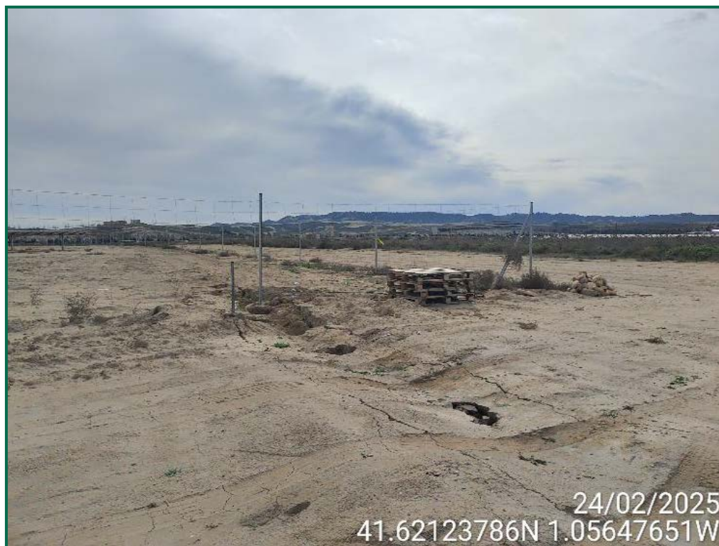
Fotografía 6. Zonas con erosión dentro de la planta fotovoltaica.
