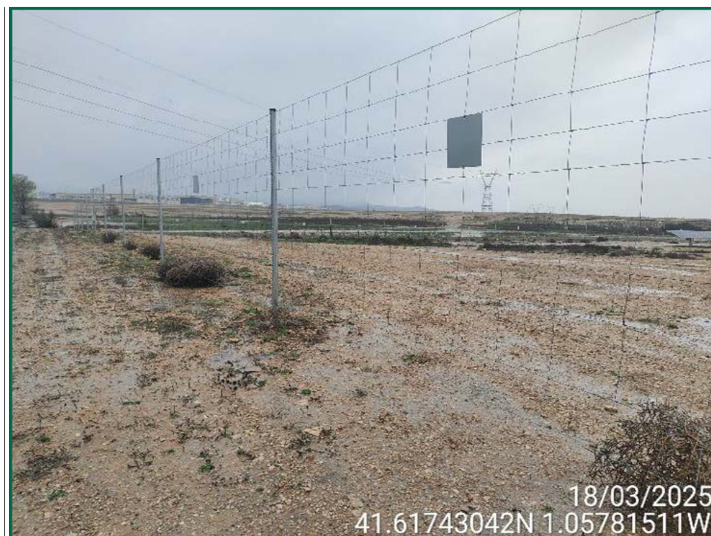
Fotografía 49. Placas anticollisión y vallado perimetral.
