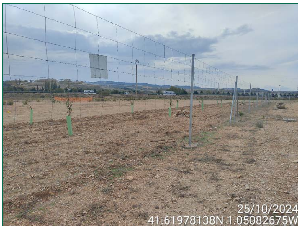
Fotografía 47. Placas anticollisión y vallado perimetral.
