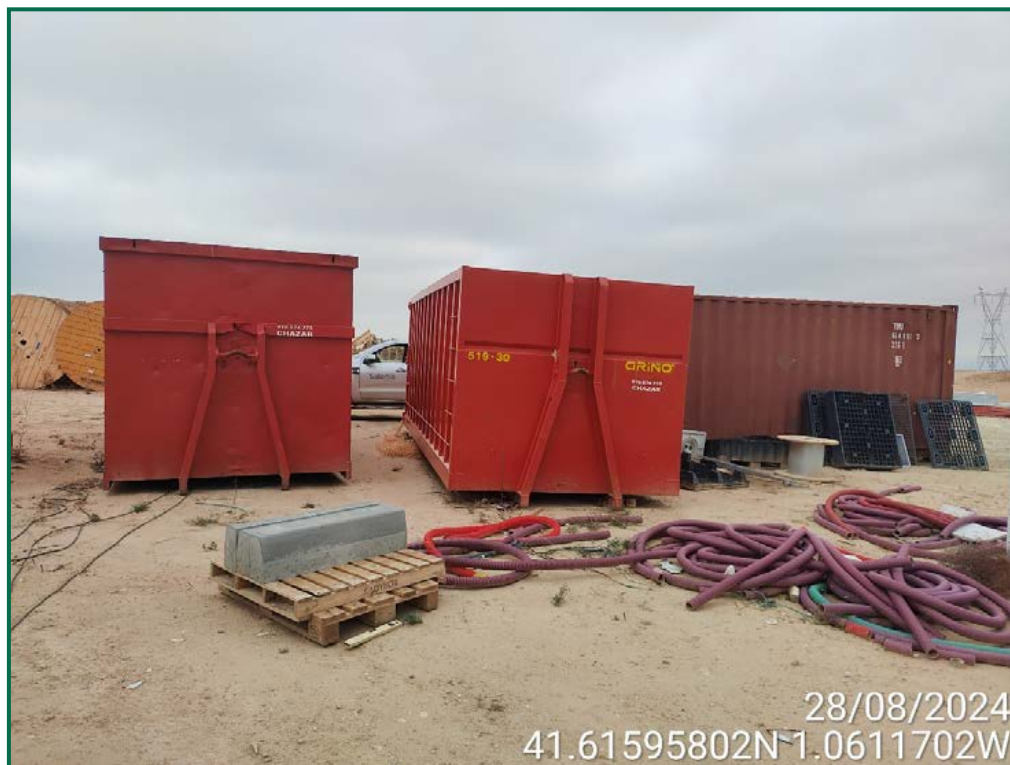
Fotografía 94. Contenedores de residuos y restos de materiales antes de ser retirados.
