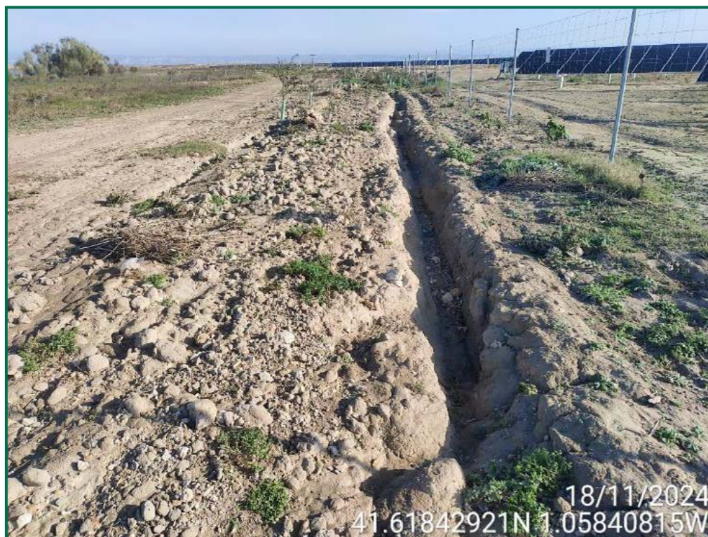
Fotografía 3. Perímetro del vallado con plantaciones y erosión por fuertes lluvias.
