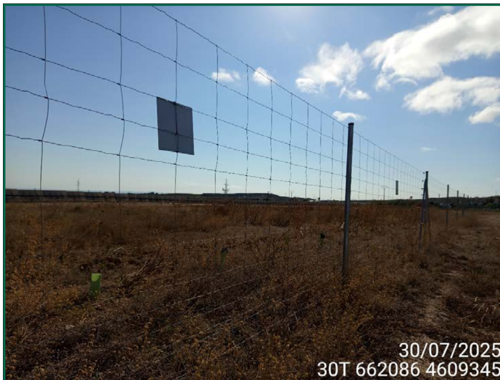
Fotografía 50. Placas anticolidión y vallado perimetral.
