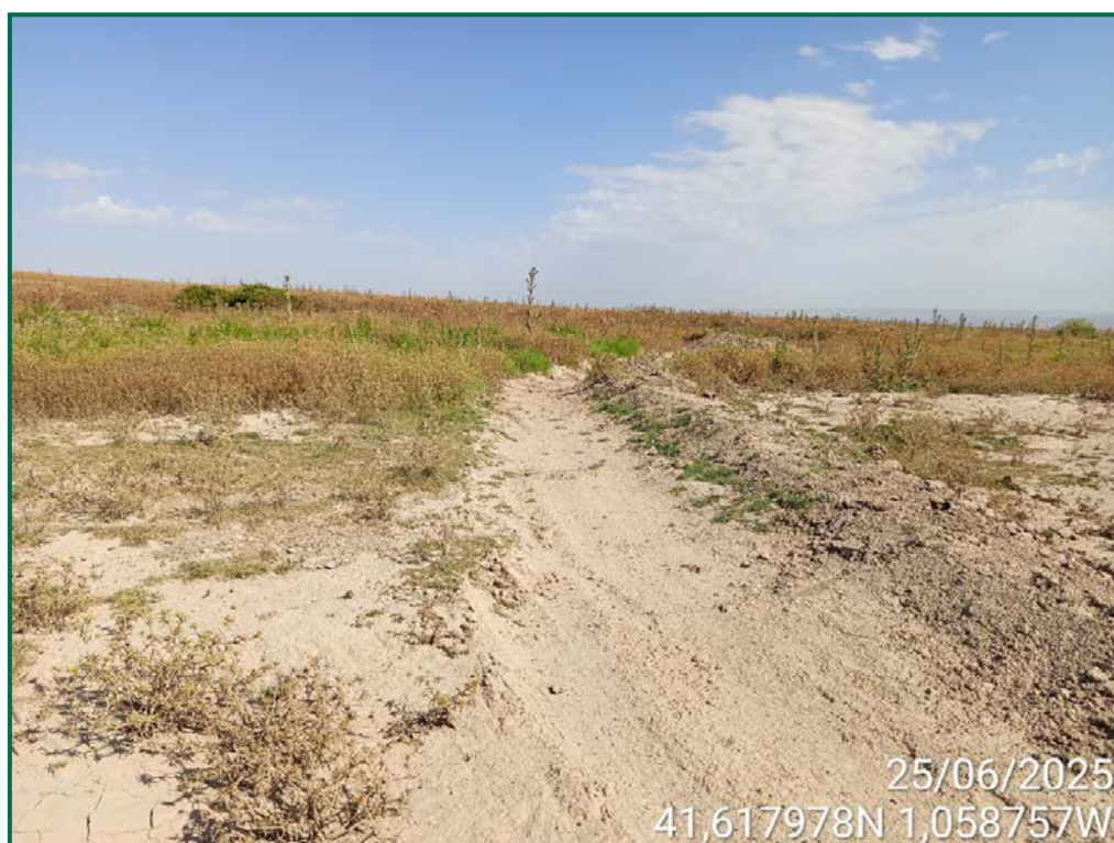
Fotografía 12. Zanja para la canalización del agua.
