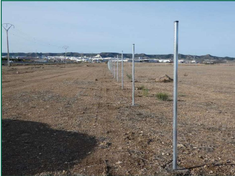
Fotografía 5. Colocación de postes para el vallado perimetral.
