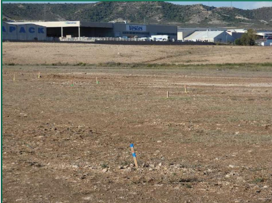
Fotografía 1. Jalonamiento previo mediante estacas.
