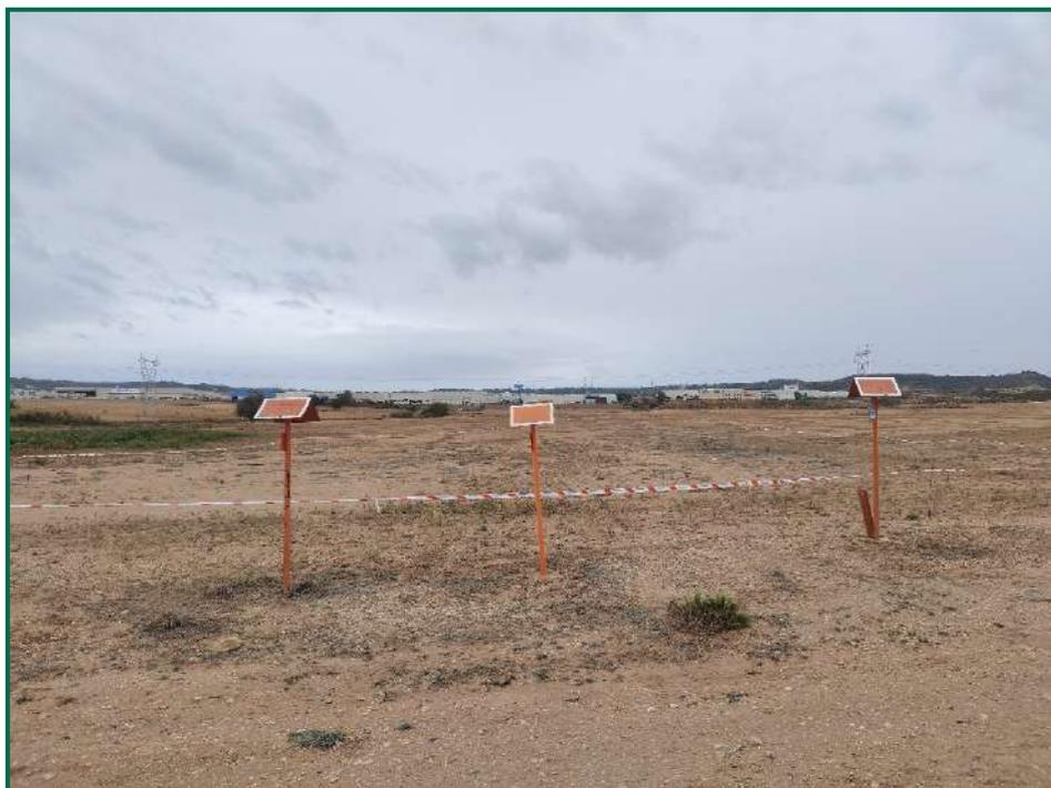
Fotografía 4. Balizamiento del gasoducto y oleoducto.
