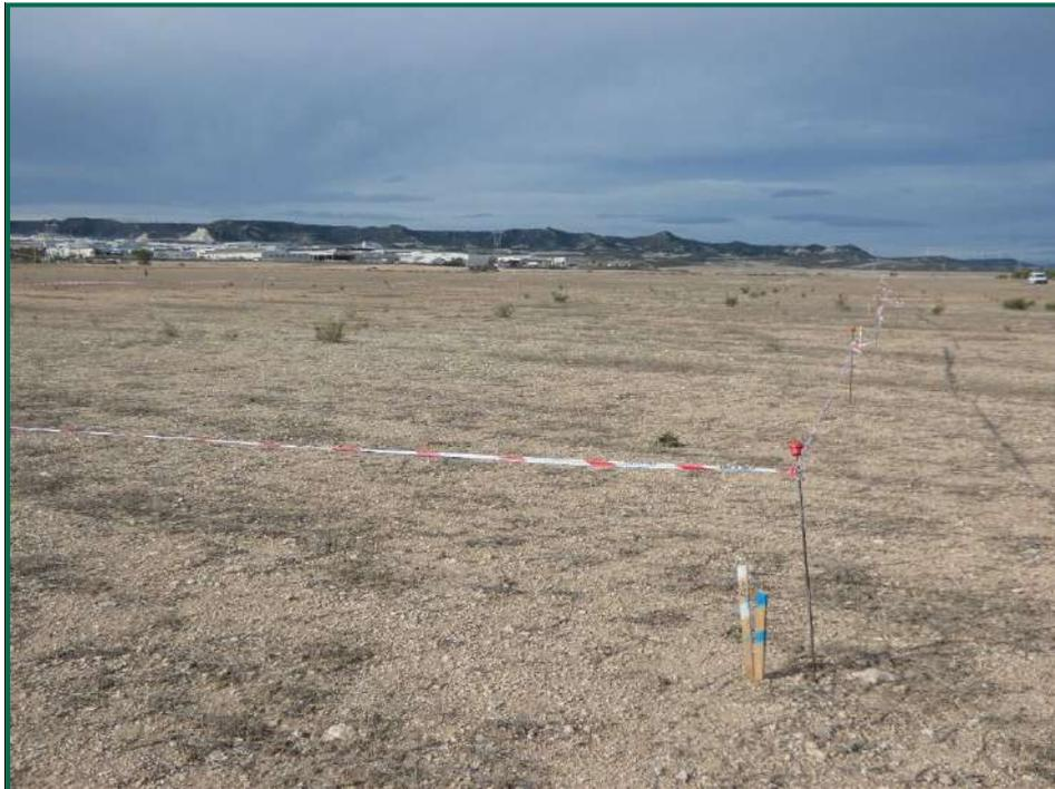
Fotografía 3. Balizamiento del gasoducto y oleoducto.
