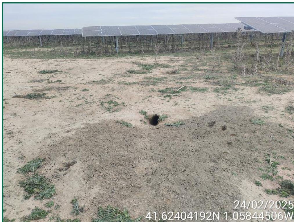
Fotografía 6. Madrigueras dentro de la planta fotovoltaica.
