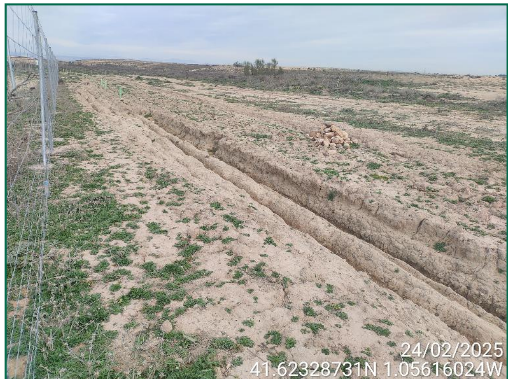
Fotografía 5. Erosión en la pantalla vegetal.
