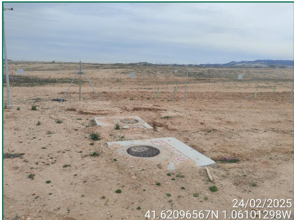
Fotografía 3. Zonas con erosión.
