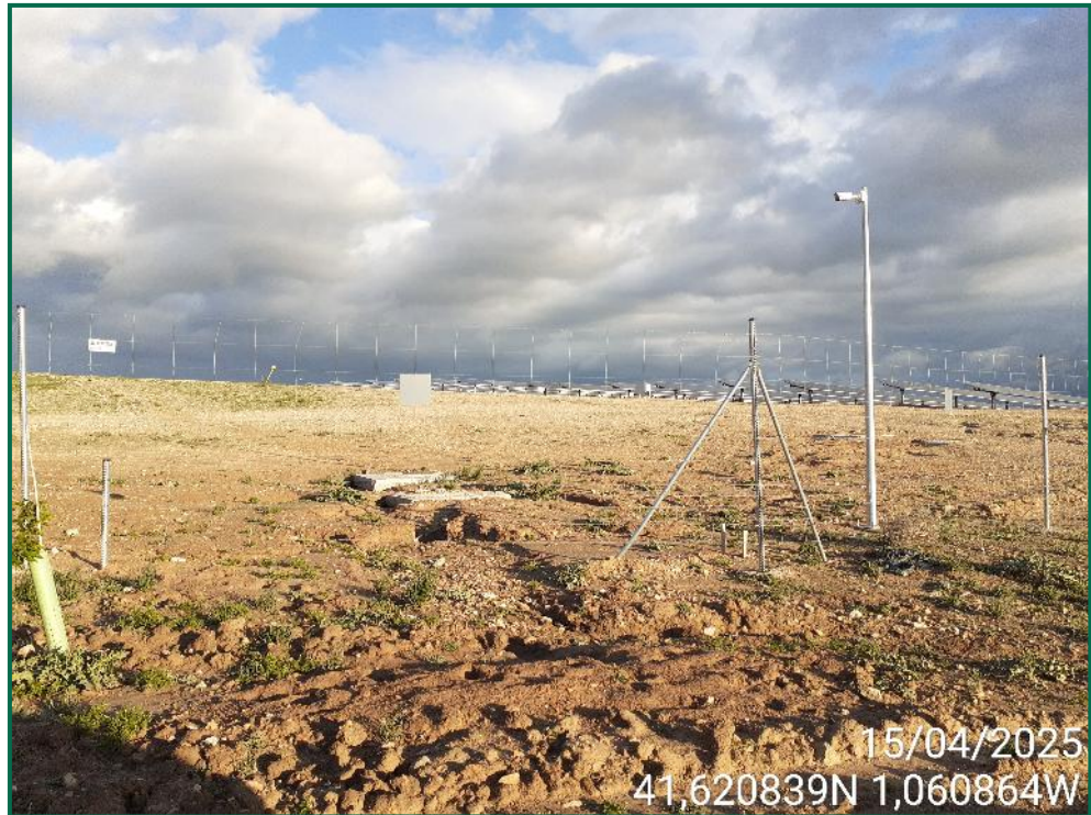
Fotografía 4. Zonas con erosión.
