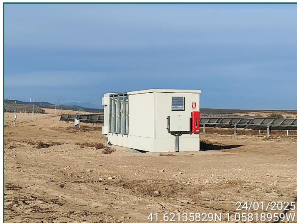
Fotografía 40. Extintor en la CT.
