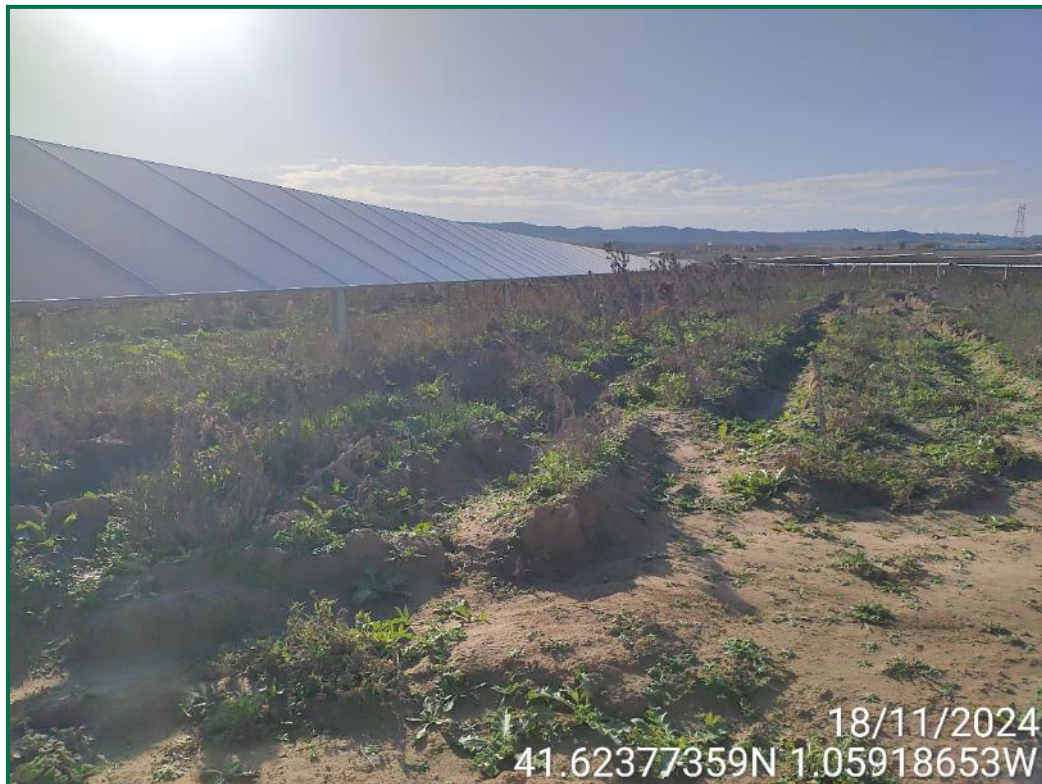
Fotografía 8. Zonas internas con vegetación entre seguidores
