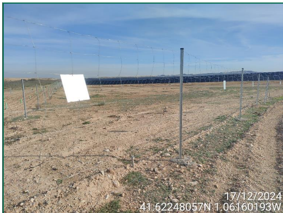
Fotografía 26. Placas anticollisión y vallado perimetral.
