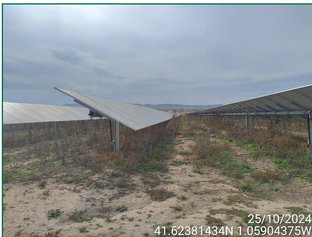
Fotografía 5. Zonas internas con vegetación entre seguidores
