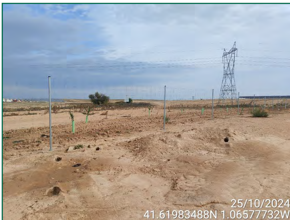
Fotografía 4. Madrigueras dentro de la planta fotovoltaica.
