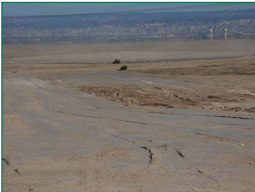
Fotografía 13. Allanado del terreno.
