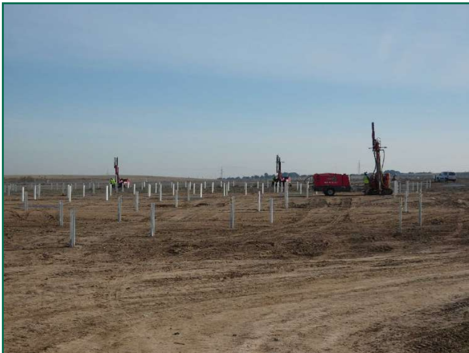
Fotografía 15. Hincas sobre el terreno.
