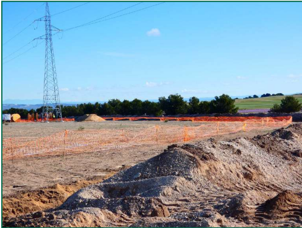
Fotografía 80. Balizado de zanjas.
