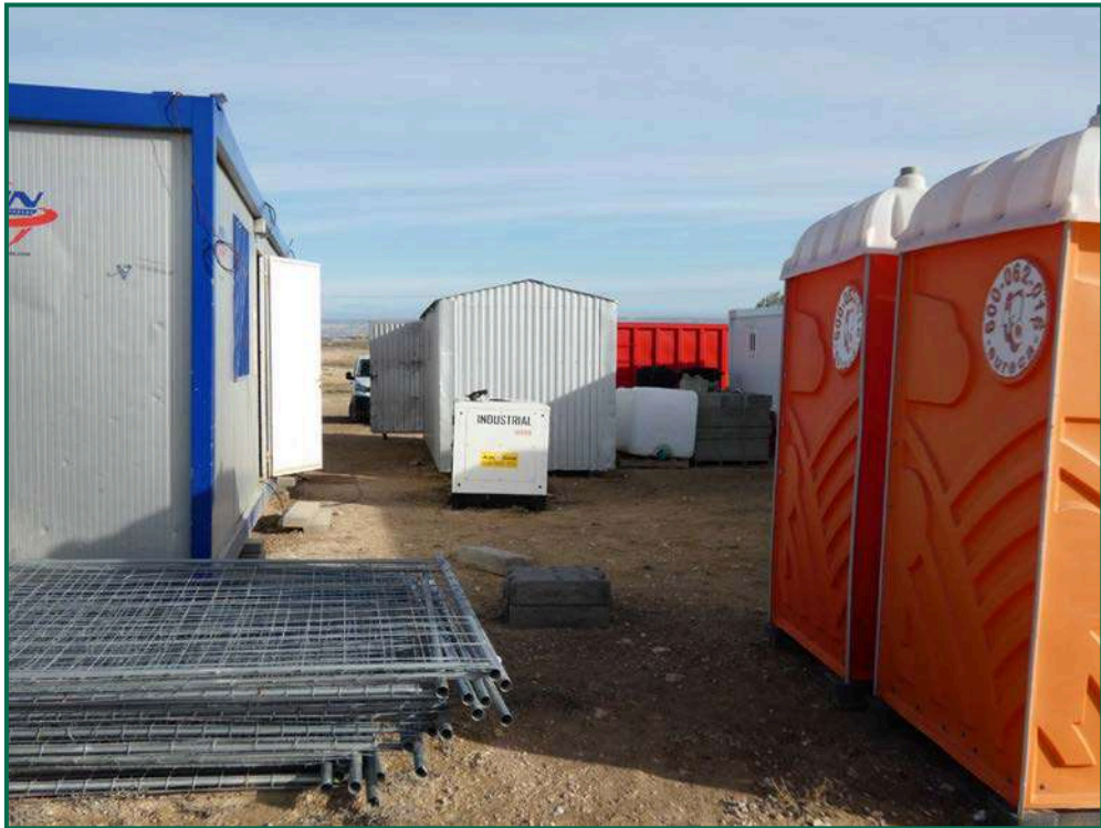
Fotografía 58. Baños portátiles y casetas de gestión.
