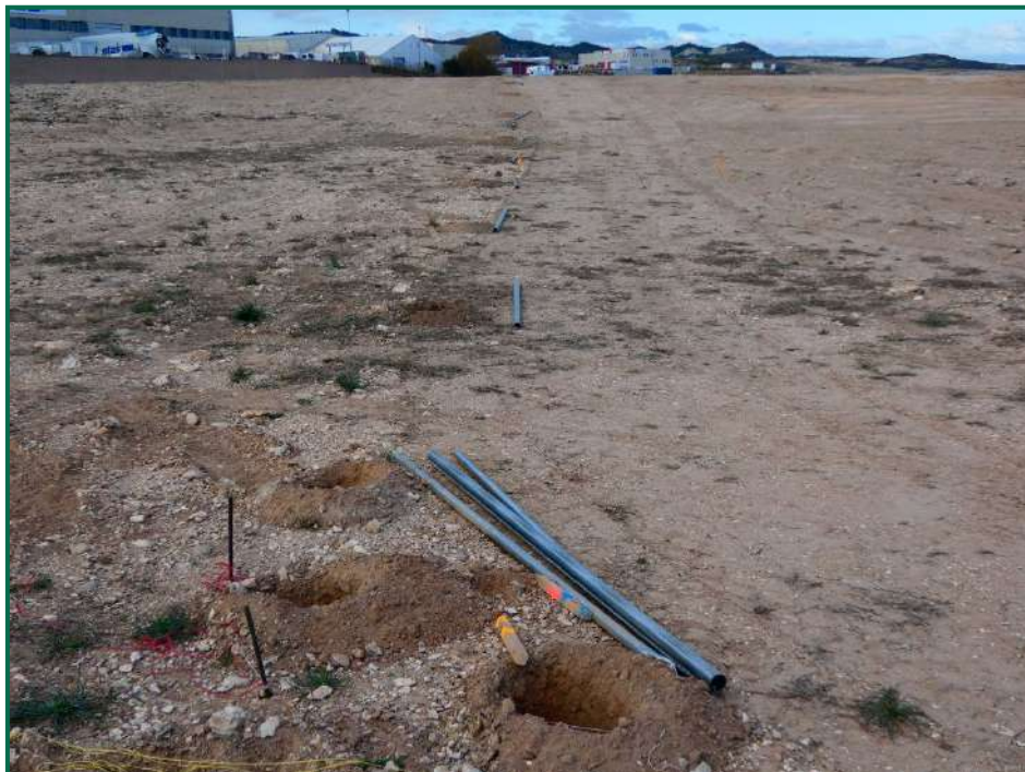
Fotografía 5. Colocación de postes para el vallado perimetral.
