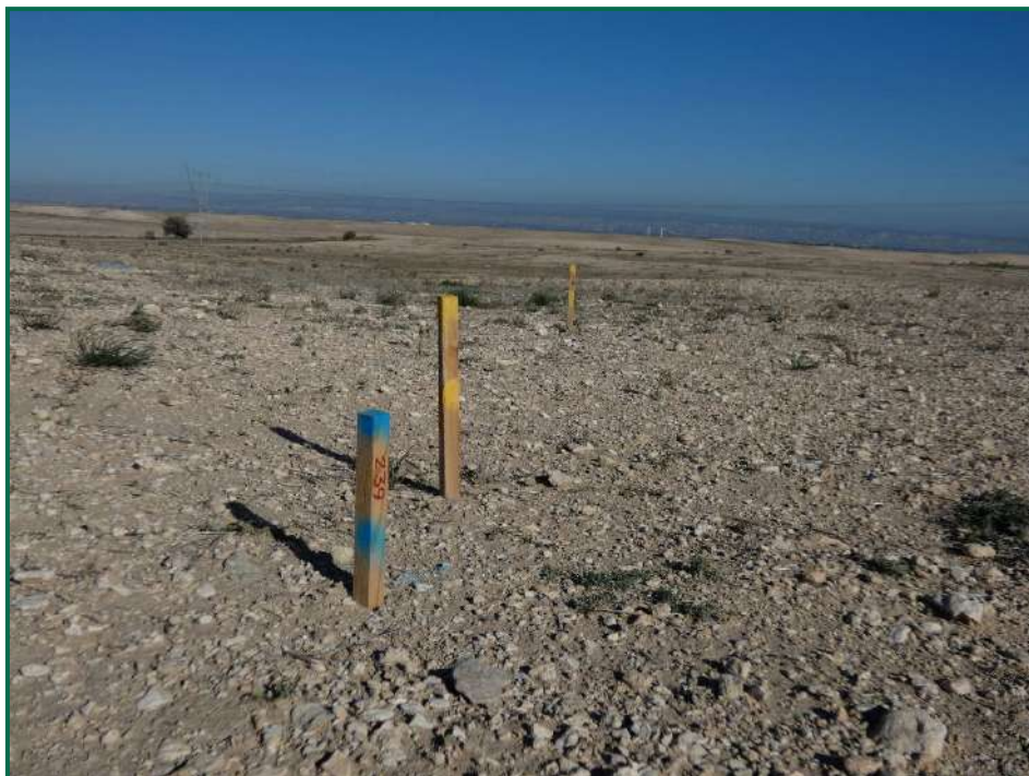
Fotografía 1. Jalonamiento previo mediante estacas.
