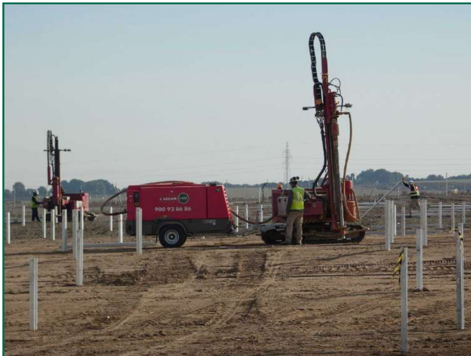
Fotografía 17. Hincas sobre el terreno.
