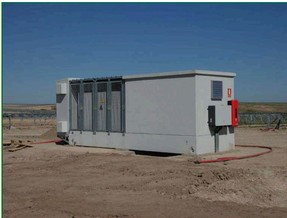
Fotografía 78. Extintor en la CT.
