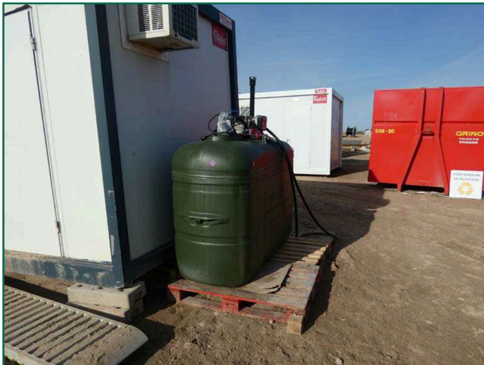
Fotografía 59. Depósito de combustible.
