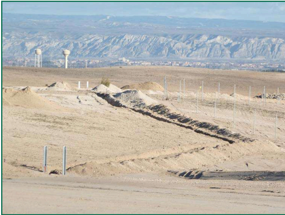
Fotografía 14. Zanjas y acopios de tierra.
