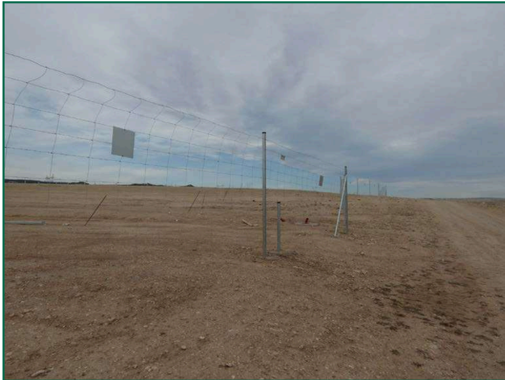
Fotografía 28. Placas anticolidión y vallado perimetral.
