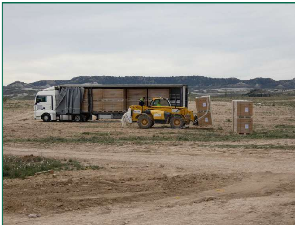
Fotografía 18. Recepción de módulos fotovoltaicos.
