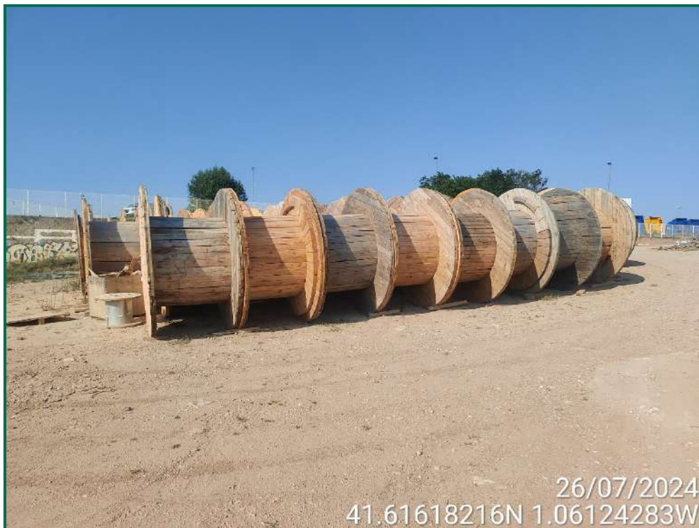
Fotografía 61. Restos de materiales.
