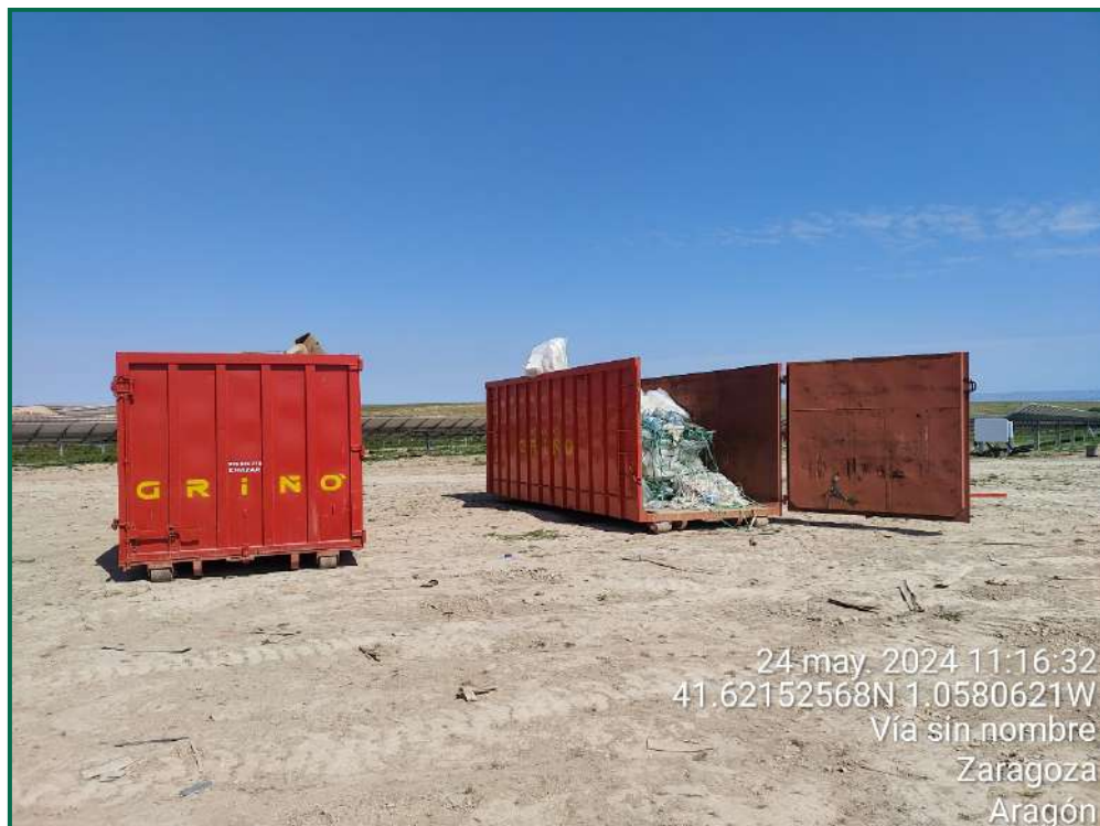
Fotografía 55. Contenedores de residuos sobre la superficie de la obra.
