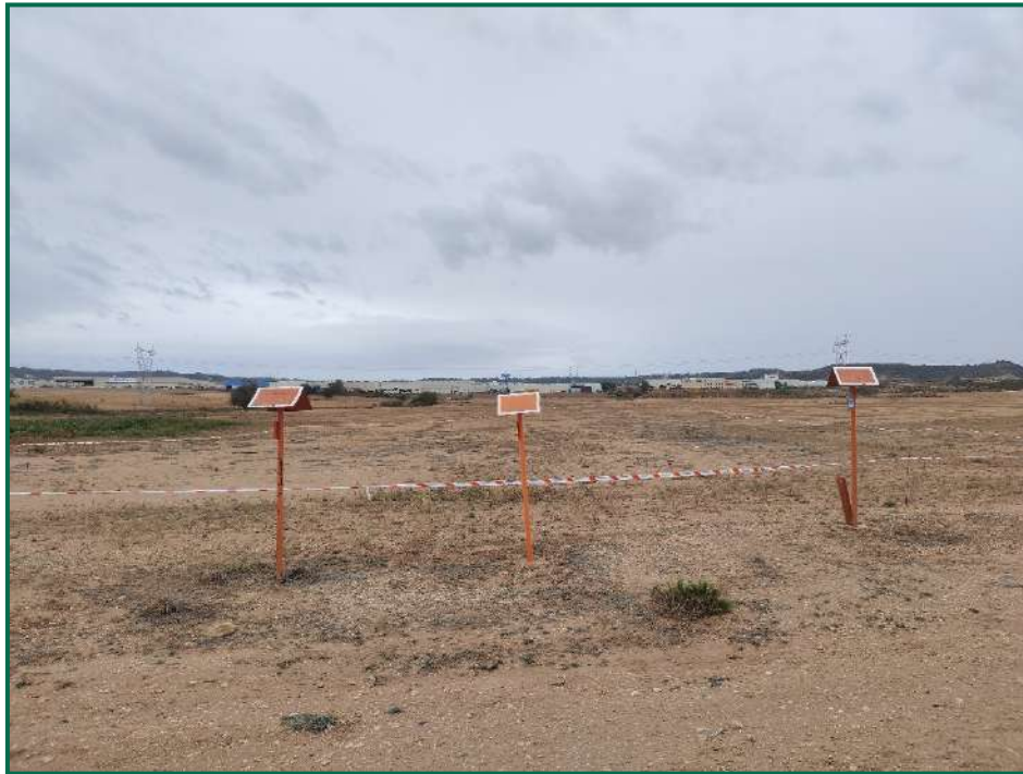
Fotografía 4. Balizamiento del gasoducto y oleoducto.
