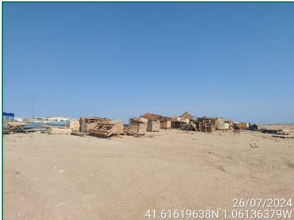
Fotografía 62. Restos de materiales.
