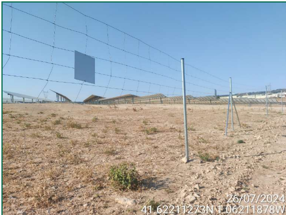
Fotografía 29. Placas anticolidión y vallado perimetral.
