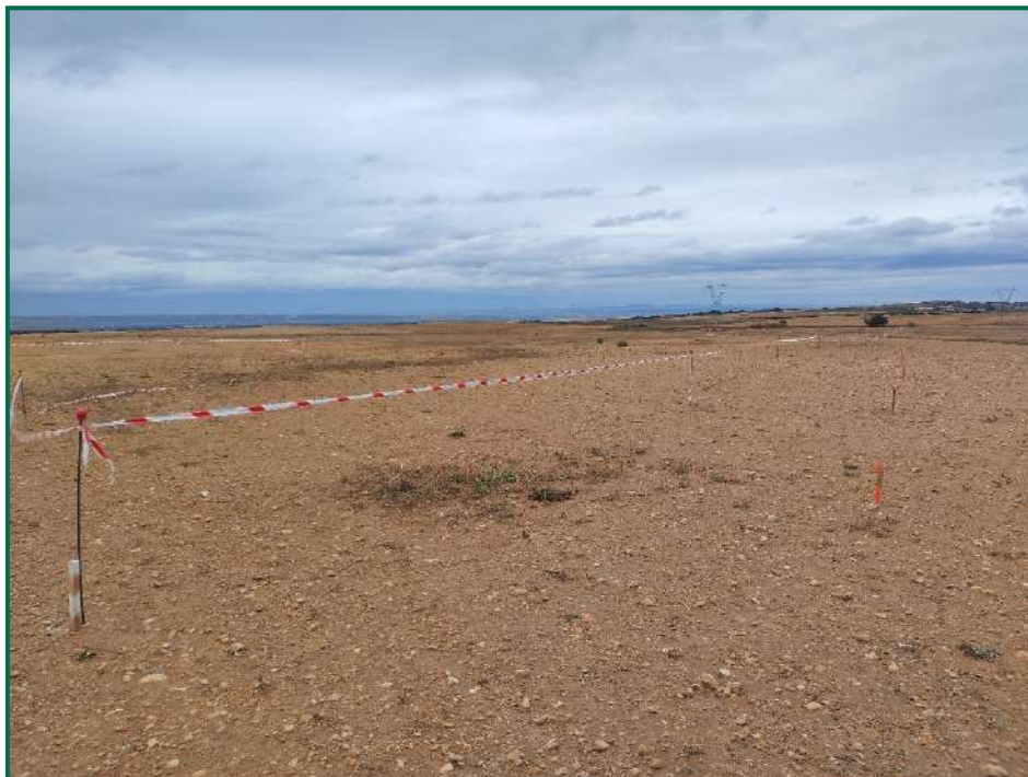
Fotografía 3. Balizamiento del gasoducto y oleoducto.
