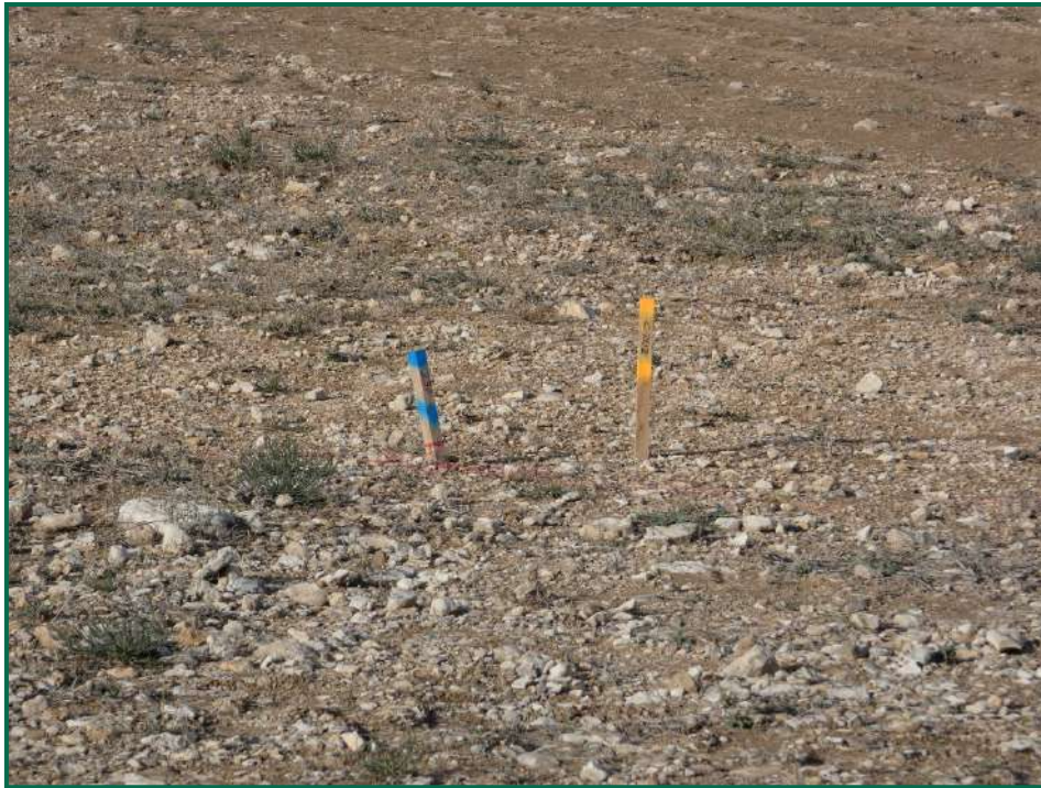
Fotografía 2. Jalonamiento previo mediante estacas.
