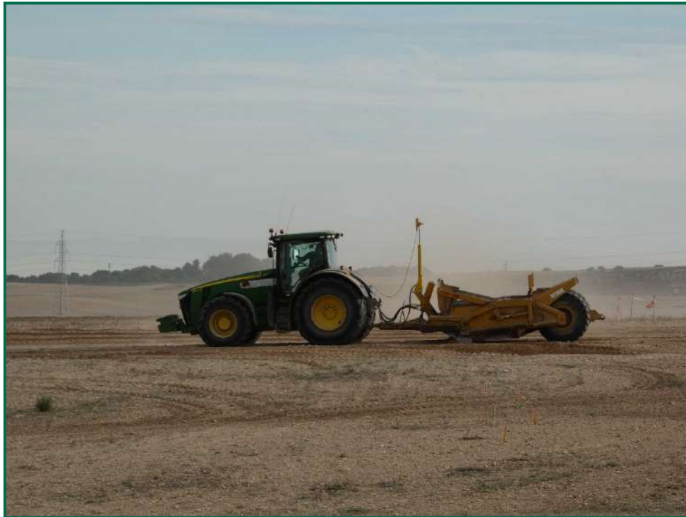
Fotografía 12. Allanado del terreno.
