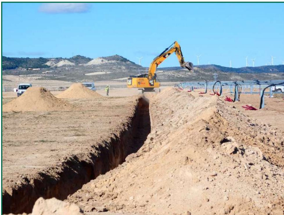
Fotografía 79. Realización de zanjas.
