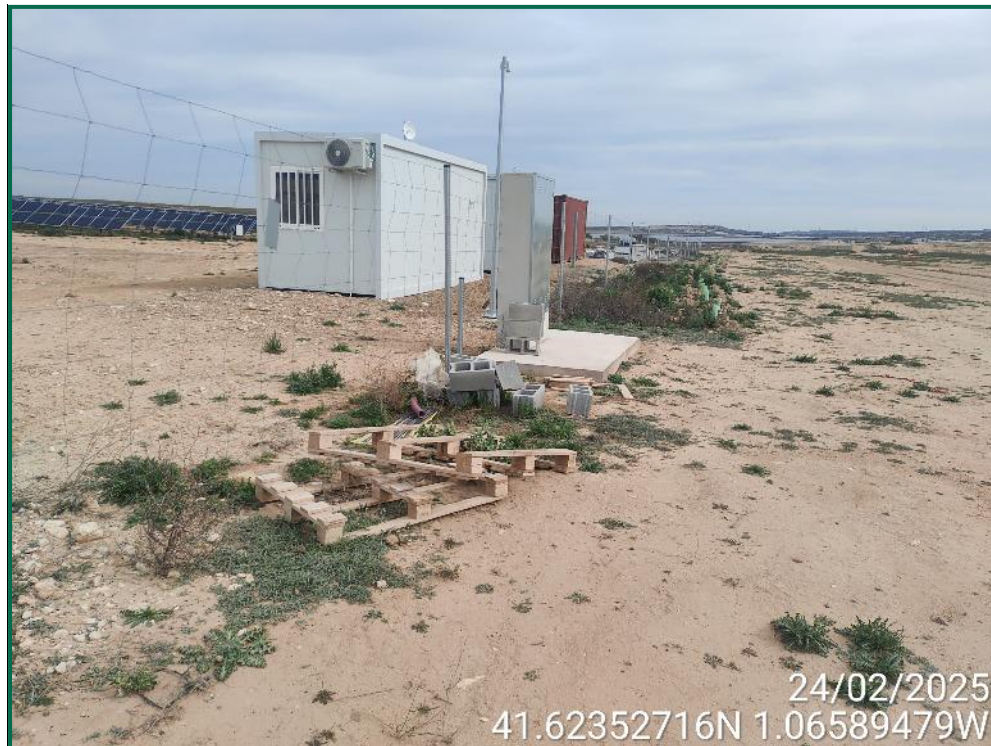
Fotografía 36. Restos de residuos fuera del vallado.
