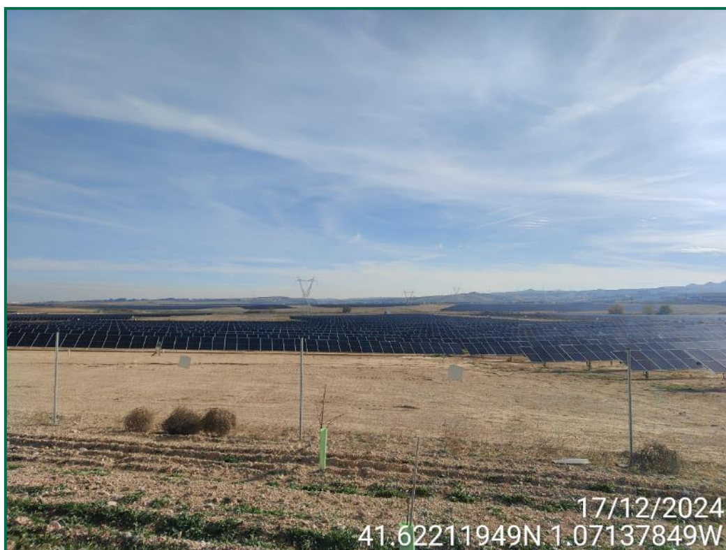
Fotografía 7. Superficie de la planta fotovoltaica con vegetación natural.
