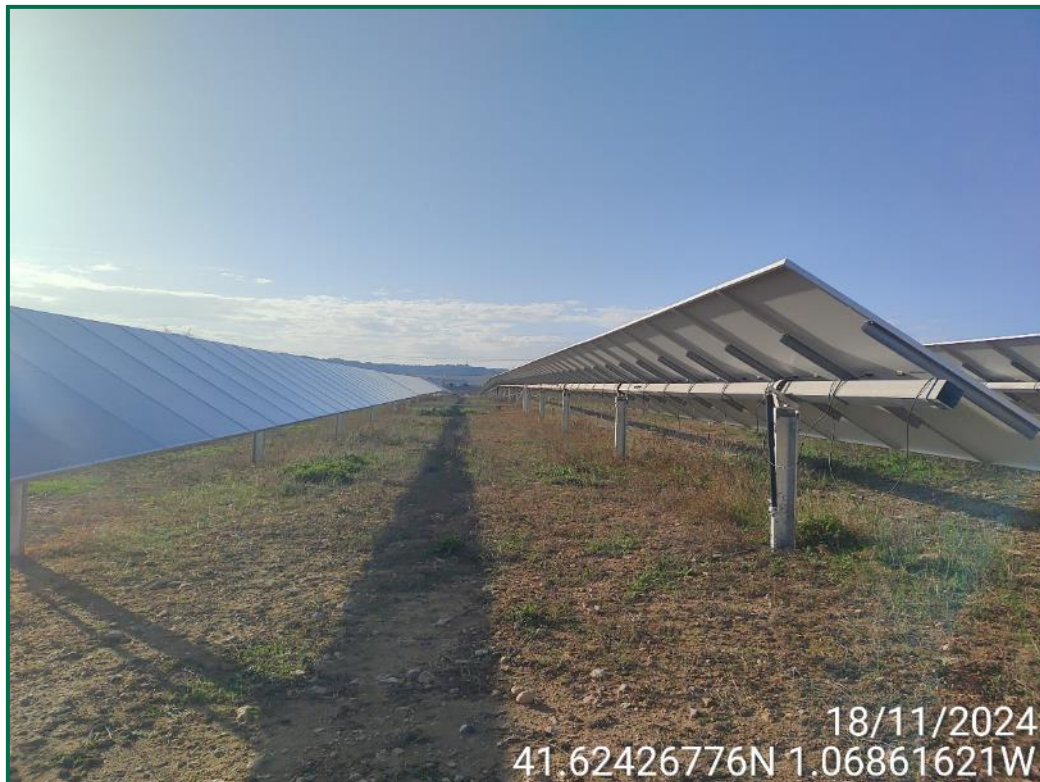
Fotografía 6. Zonas internas con vegetación entre seguidores
