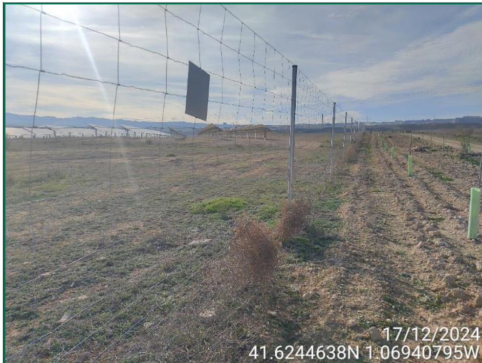
Fotografía 24. Placas anticollisión y vallado perimetral.
