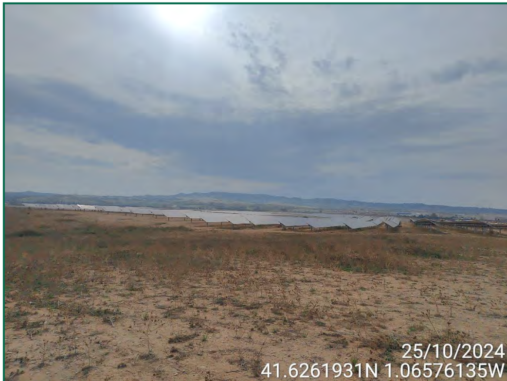
Fotografía 4. Superficie de la planta fotovoltaica con vegetación natural.
