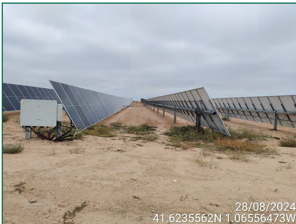
Fotografía 3. Zonas internas con vegetación entre seguidores
