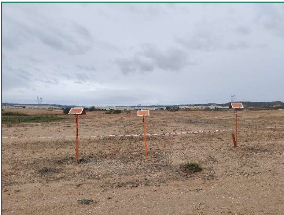
Fotografía 5. Balizamiento del gasoducto y oleoducto.
