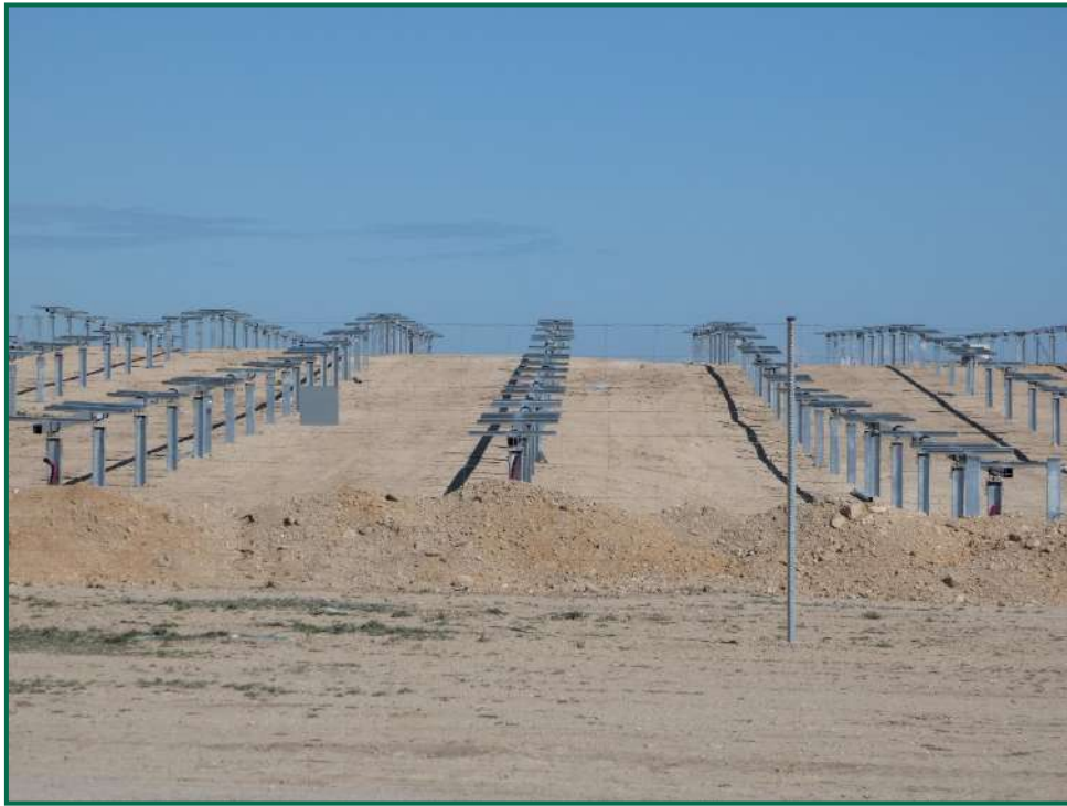
Fotografía 19. Hincas sobre el terreno.
