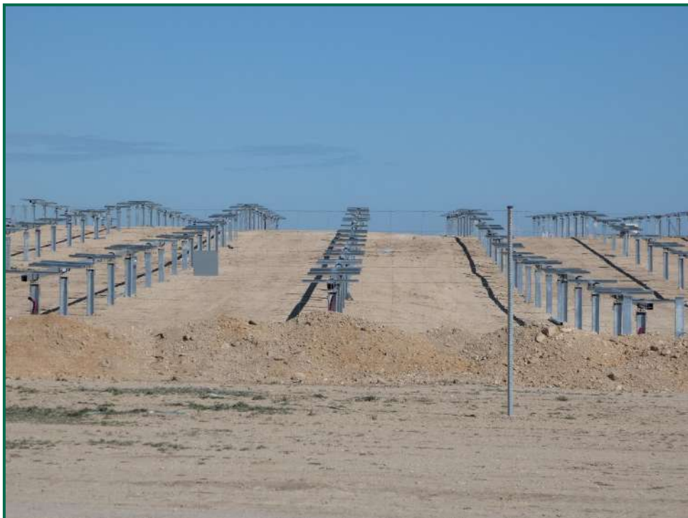
Fotografía 18. Hincas sobre el terreno.
