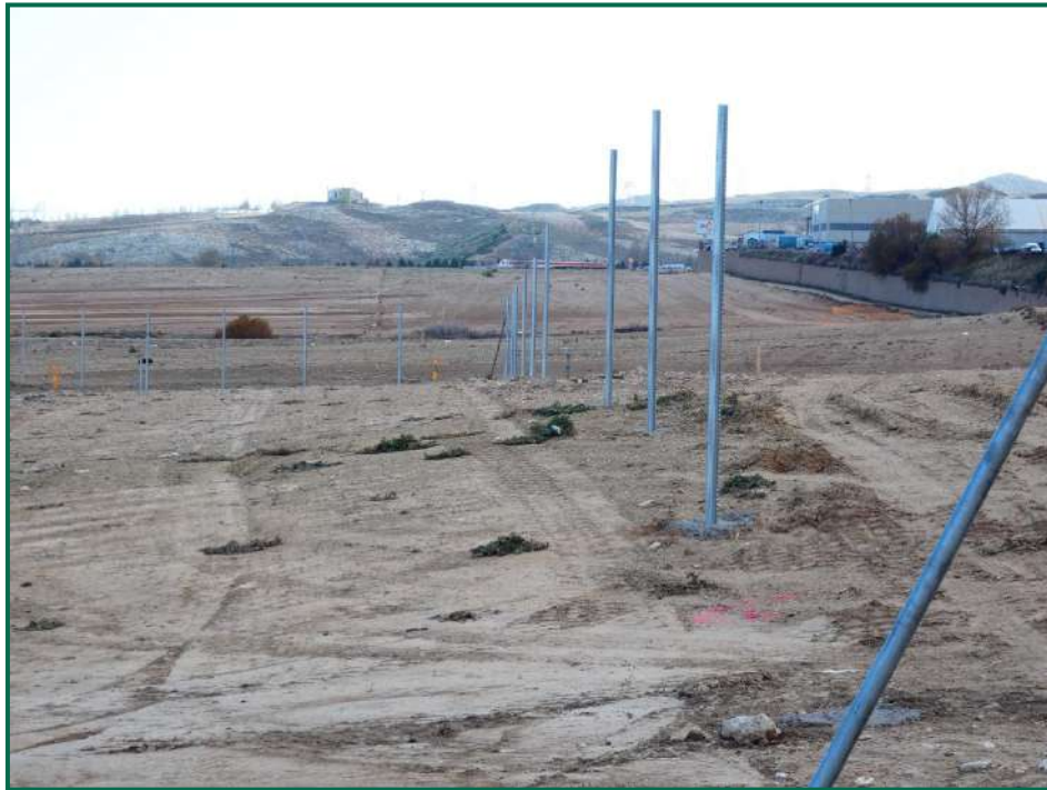
Fotografía 6. Colocación de postes para el vallado perimetral.
