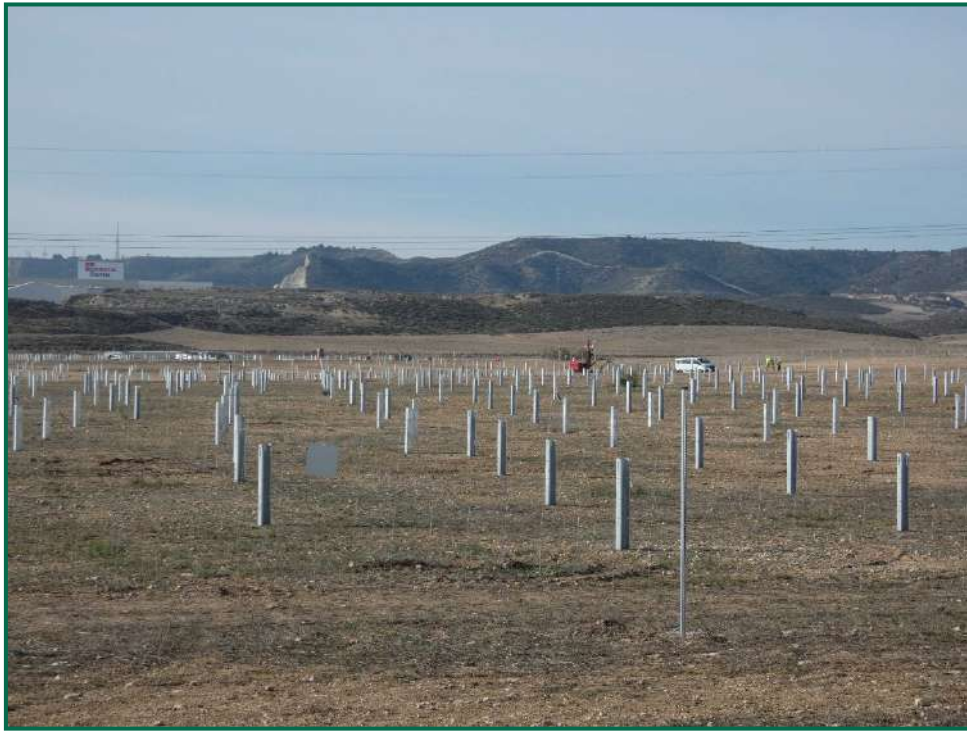
Fotografía 17. Hincas sobre el terreno.
