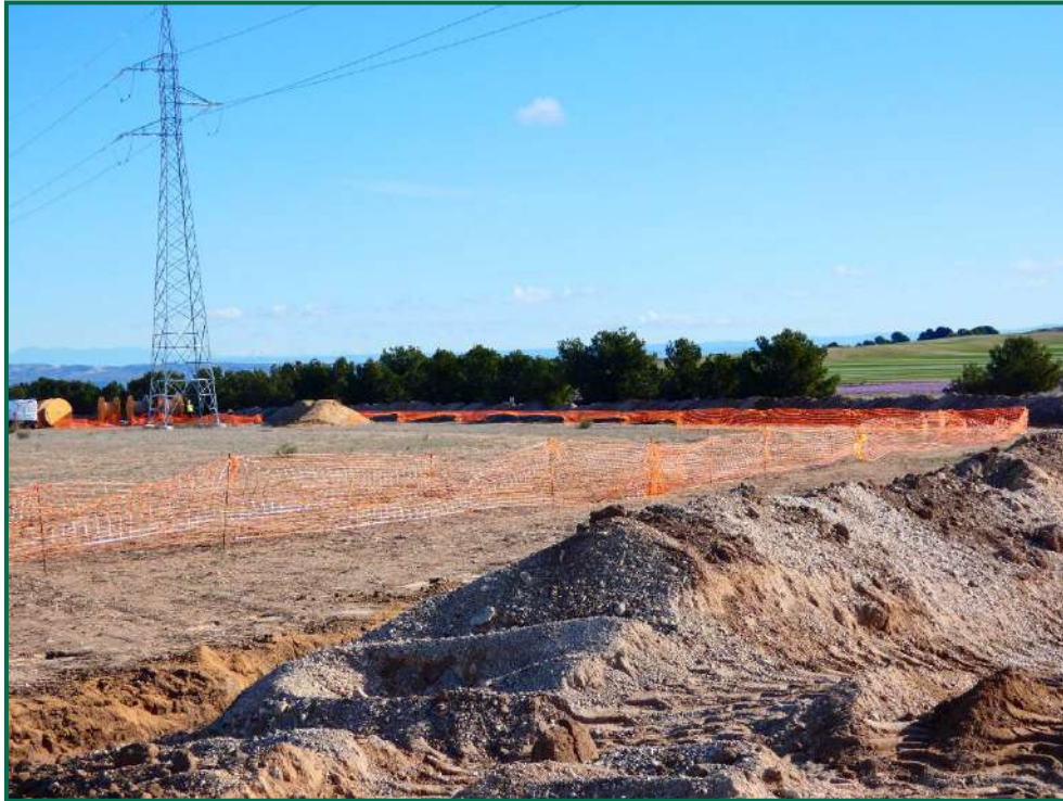
Fotografía 84. Balizado de zanjas.
