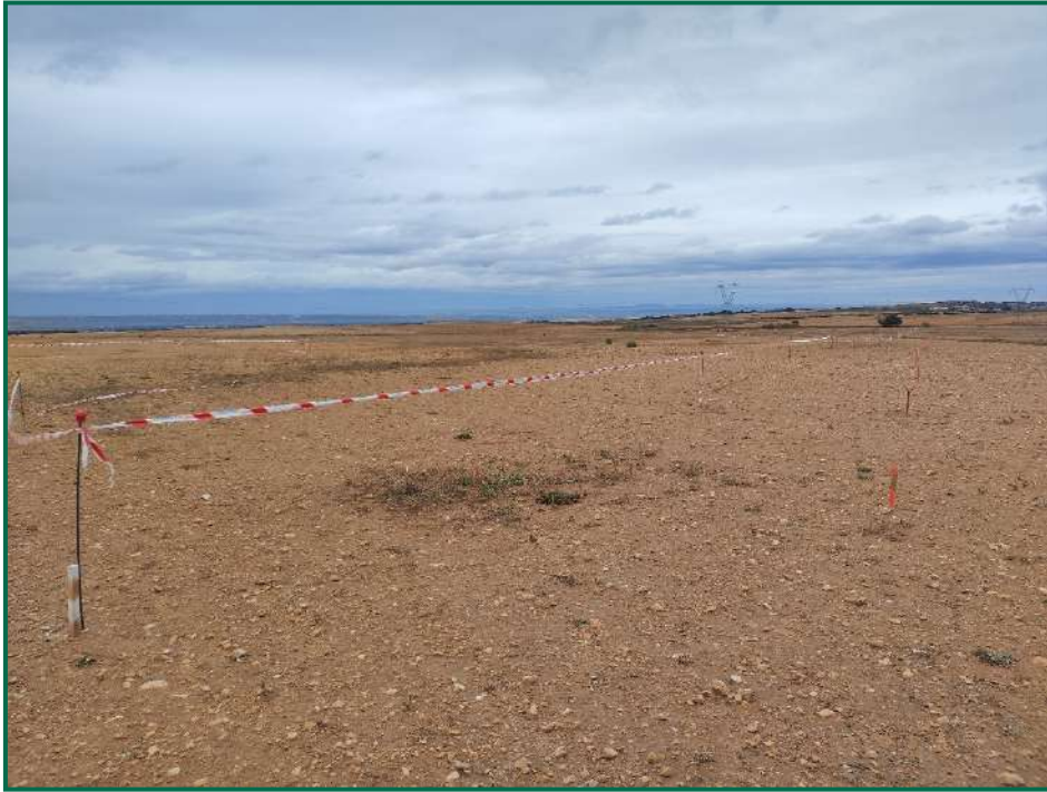
Fotografía 4. Balizamiento del gasoducto y oleoducto.
