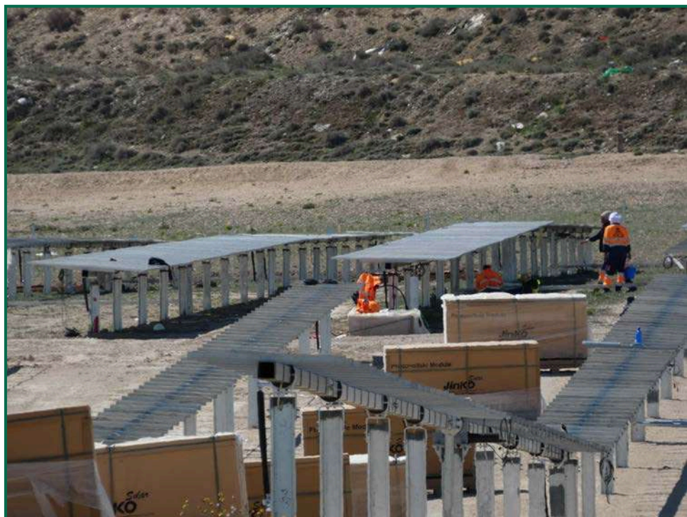
Fotografía 20. Colocación de módulos fotovoltaicos.
