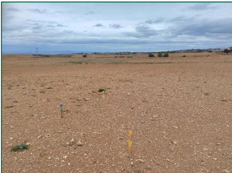
Fotografía 1. Jalonamiento previo mediante estacas.
