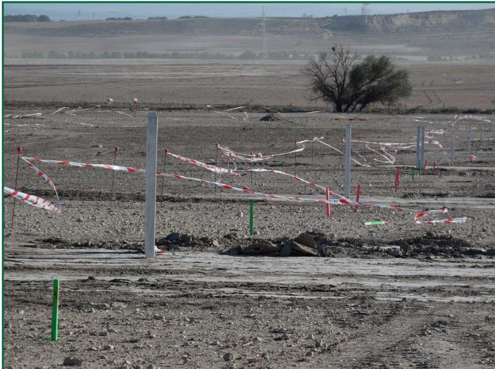
Fotografía 1. Balizamiento del oleoducto y de los postes de los inversores.
