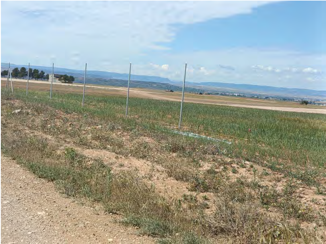
Hincado y vallado Castillo 2:
