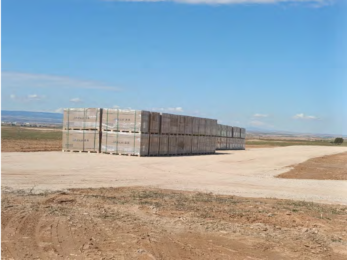
Acopio de placas solares:
