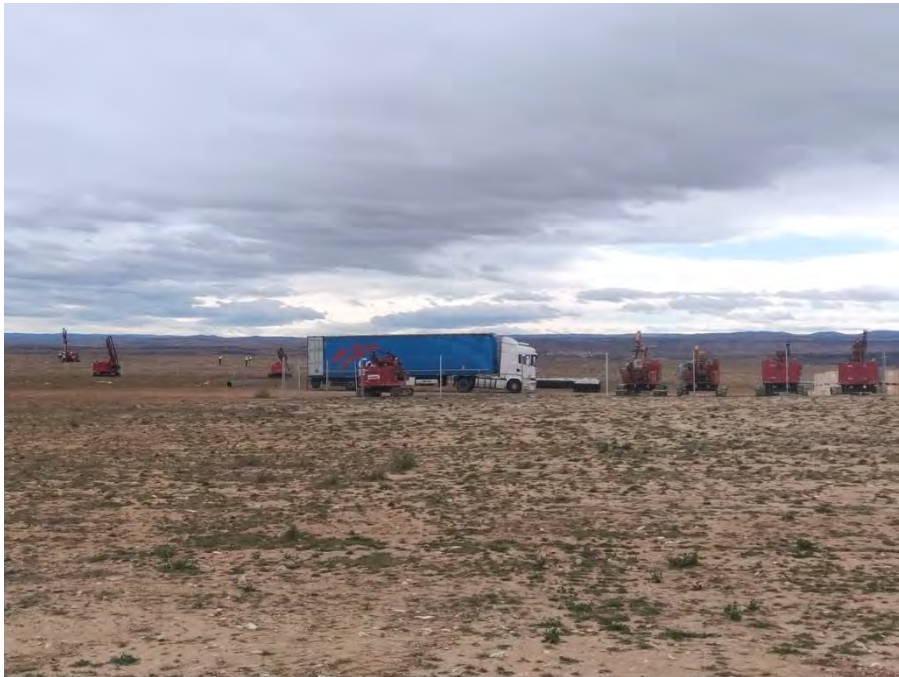
Fotografía 2. Zona de acopios.
