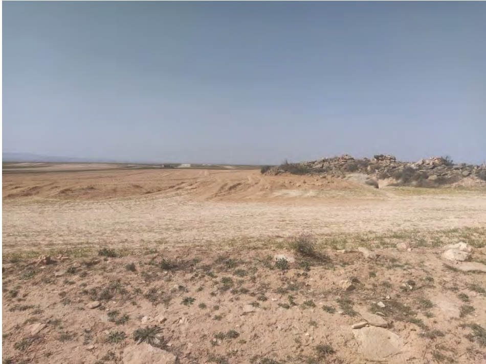
Fotografía 21. Movimiento de tierra Castillo 1
