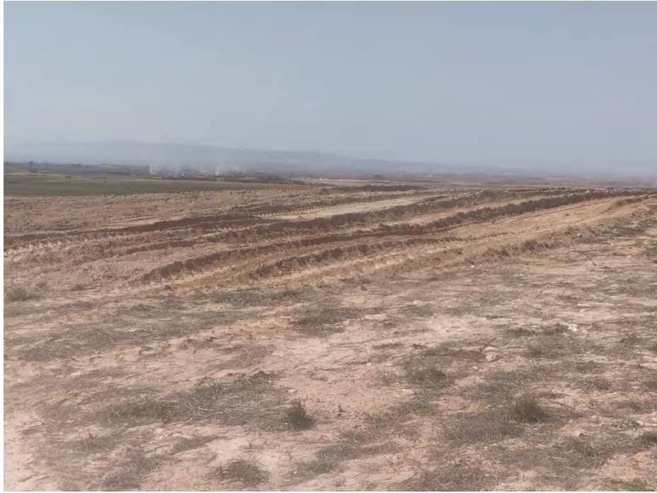
Fotografía 17. Movimiento de tierra Castillo 1
