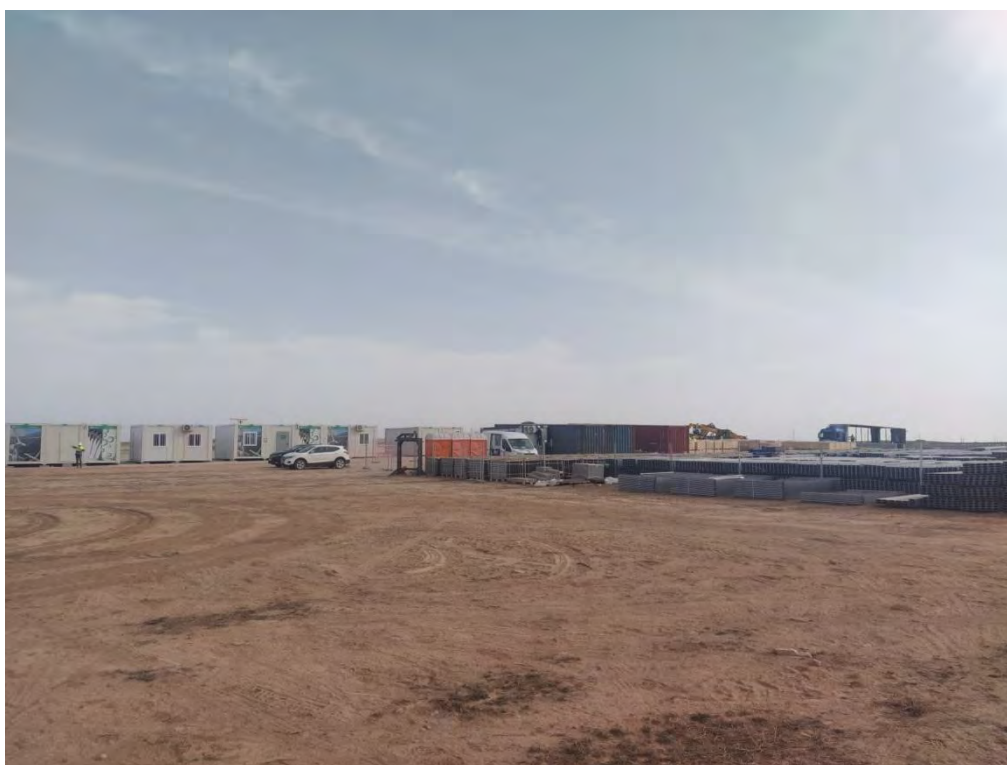
Fotografía 12. Zona de acopio y casetas.
