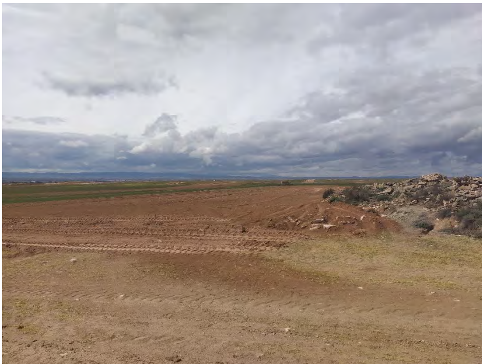
Fotografía 8. Movimiento de tierra Castillo 1.
