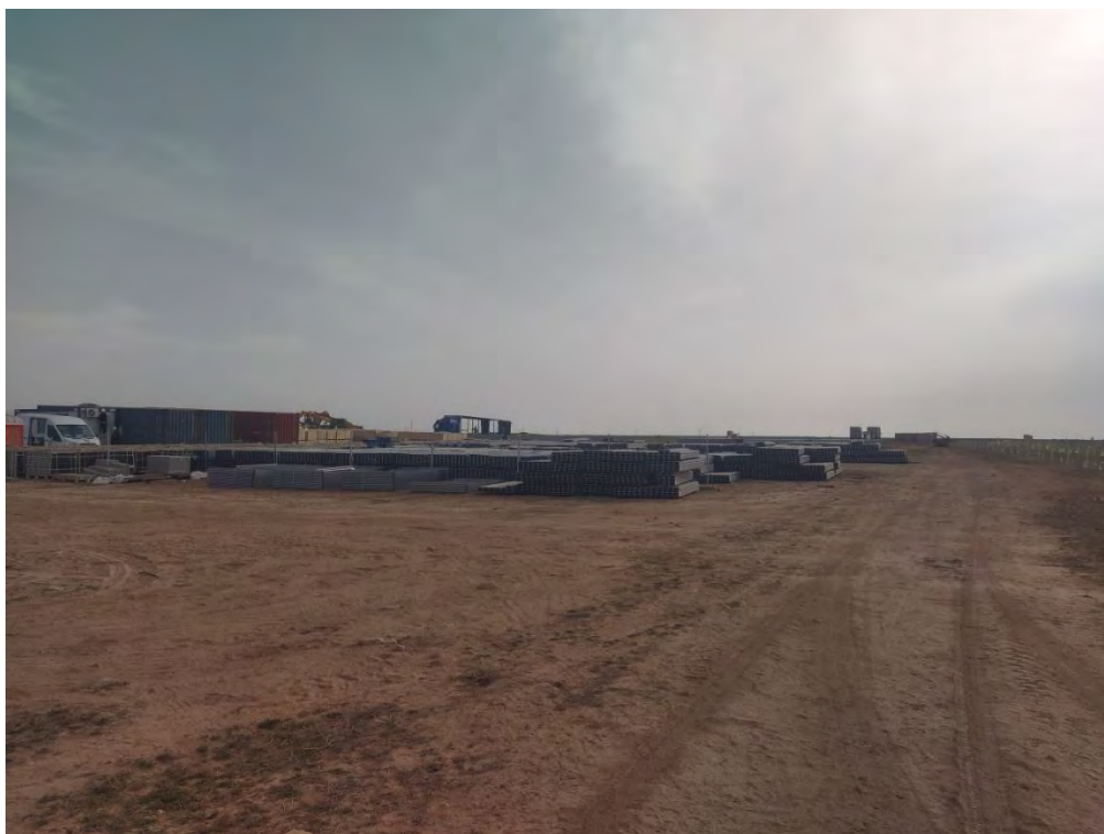
Fotografía 11. Zona de acopio.
