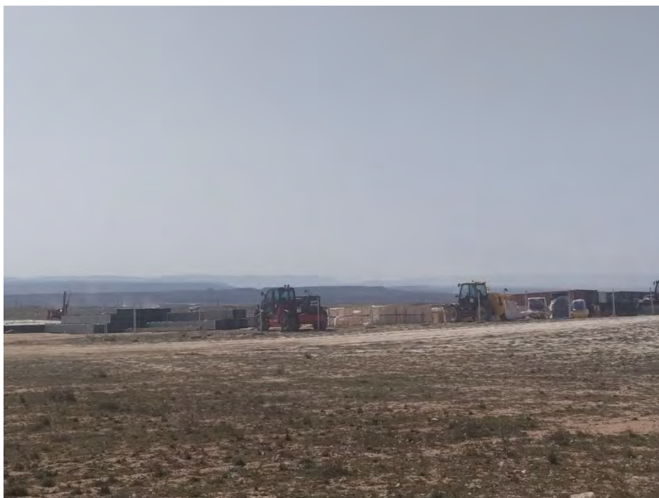
Fotografía 25. Zona de acopios.
