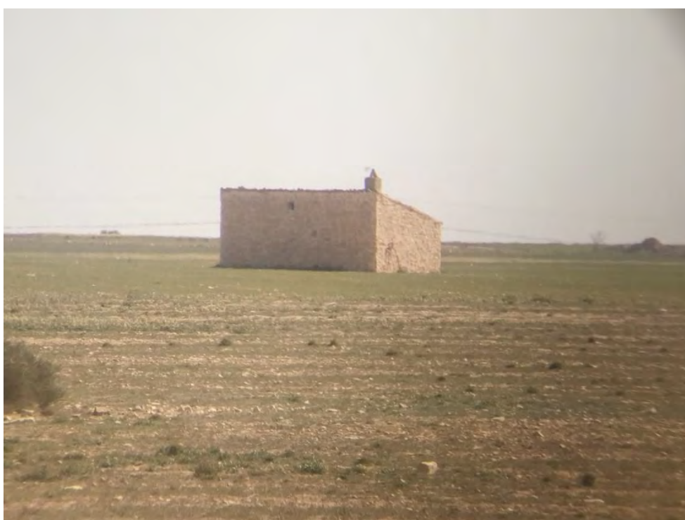
Fotografía 30. Caseta con balizado provisional, deteriorado (Caseta El Bochar)
