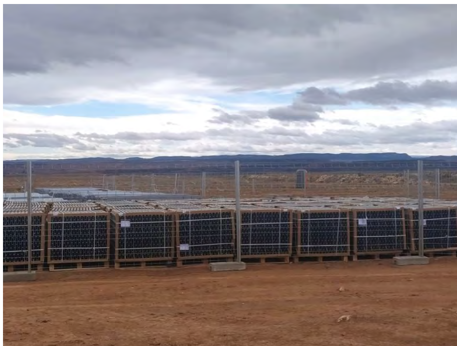
Fotografía 5. almacén de placas solares.
