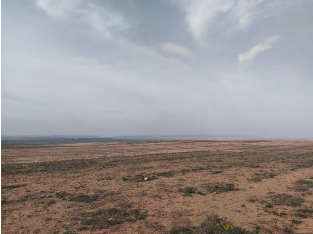
Fotografía 1. Movimiento de tierra Castillo 1
