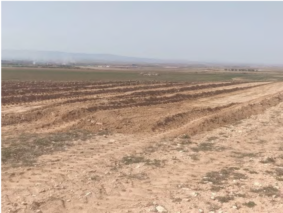
Fotografía 18. Movimiento de tierra Castillo 1
