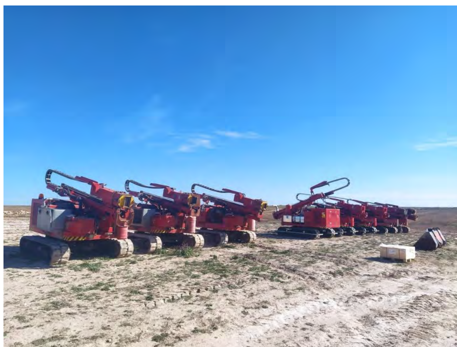
Fotografía 16. Hincadoras, todavía sin utilizar.
