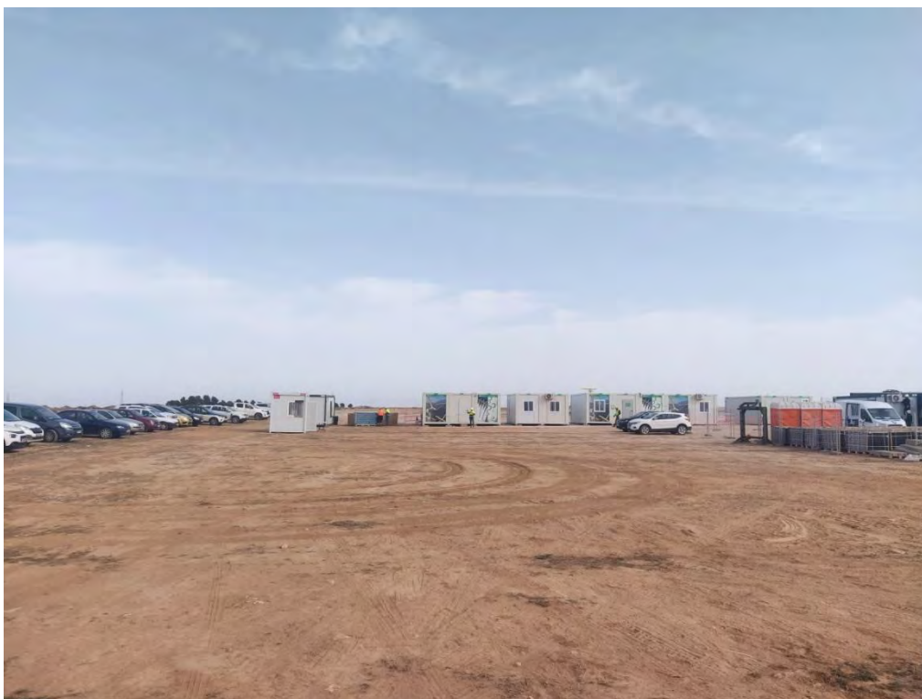
Fotografía 13. Zona de acopio y casetas.
