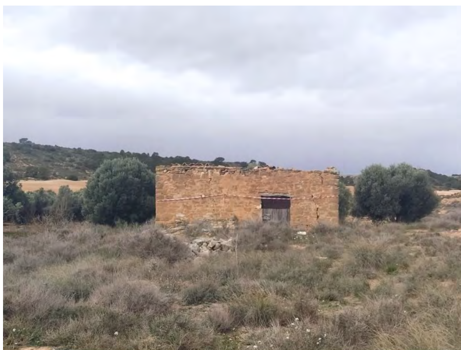
Fotografía 14. Caseta con balizado provisional (Caseta de Val Martinez)
