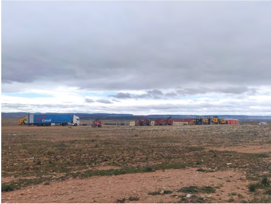
Fotografía 1. Zona de acopios. Descarga de material y maquinaria.
