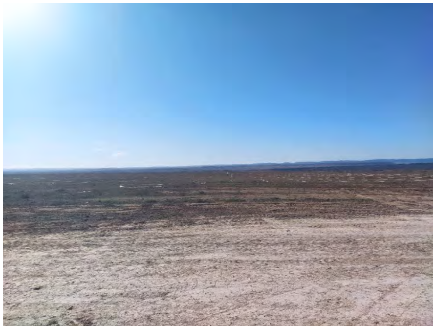
Fotografía 12. Hincas sobre el terreno para su posterior colocación.
