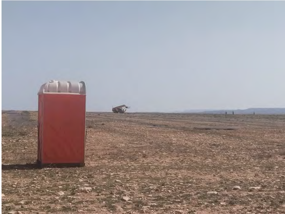
Fotografía 11. Baño químico en zona de obra
