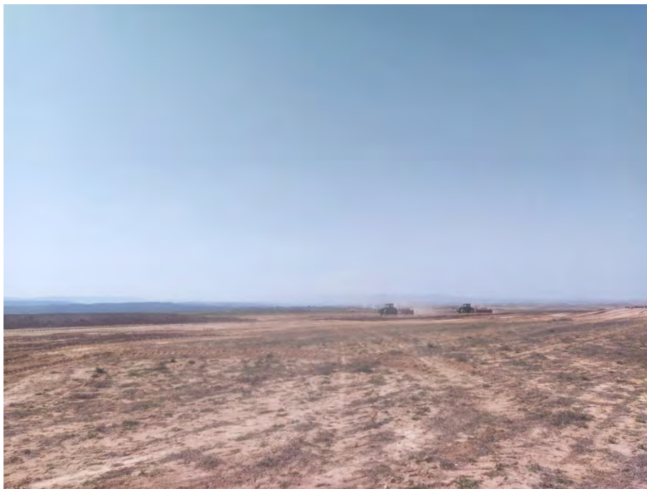
Fotografía 14. Movimiento de tierra Castillo 1
