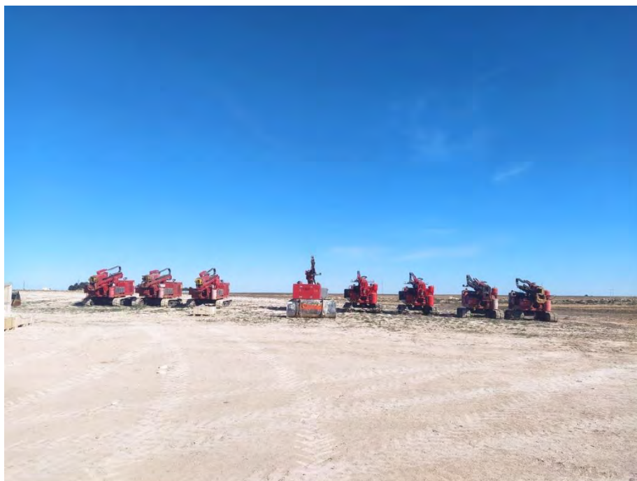
Fotografía 15. Hincadoras, todavía sin utilizar.
