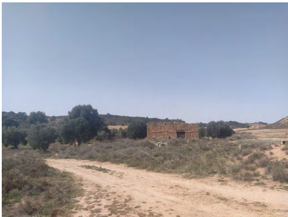
Fotografía 29. Caseta con balizado provisional (Caseta de Val Martinez)
