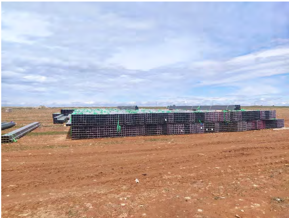
Fotografía 2. Zona de acopio y casetas.
