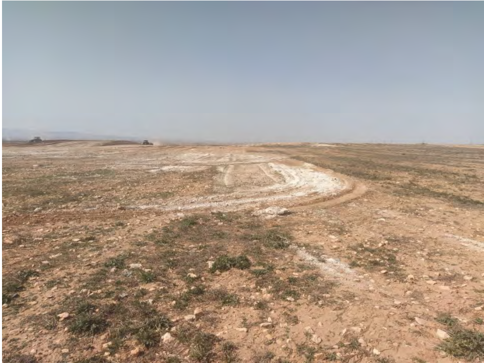
Fotografía 19. Movimiento de tierra Castillo 1
