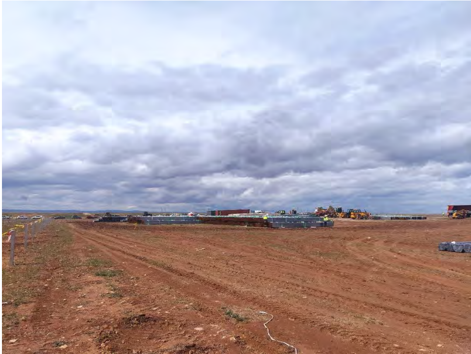
Fotografía 1. Zona de acopio y casetas.
