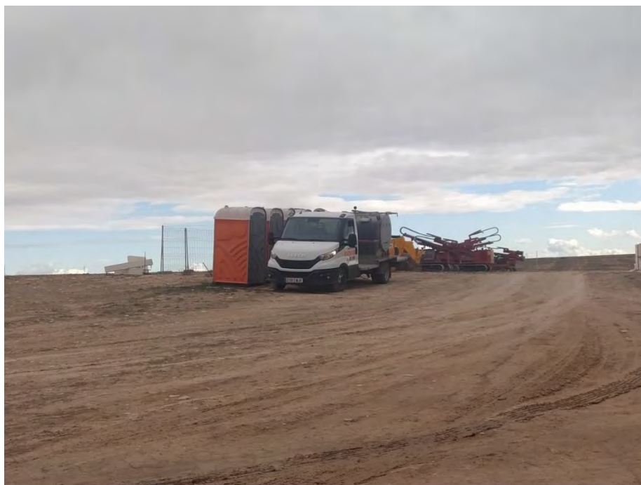
Fotografía 3. Limpieza de baños químicos.
