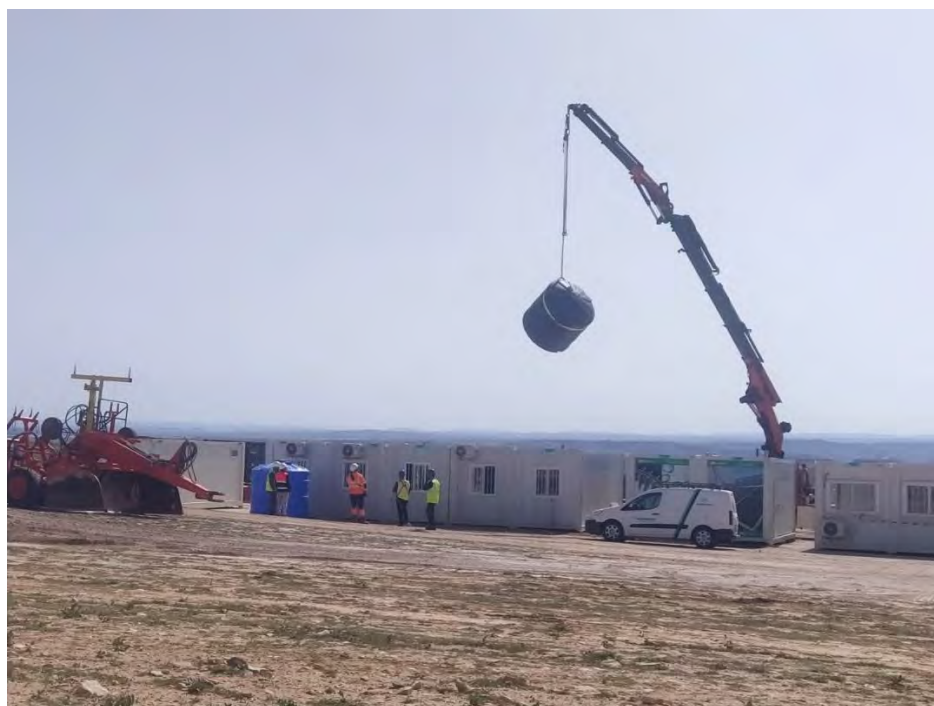
Fotografía 26. Zona de acopios. Descarga de depósito y fosa séptica.
