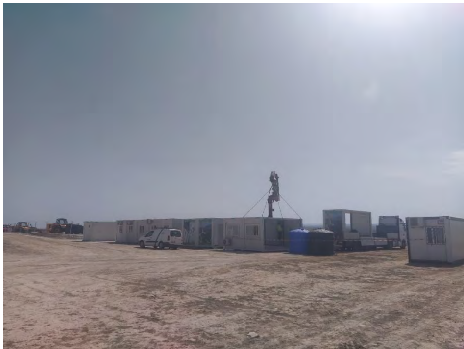
Fotografía 22. Descarga de casetas de obra.
