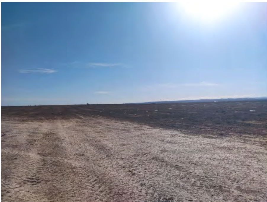
Fotografía 14. Hincas sobre el terreno para su posterior colocación. Castillo 1
