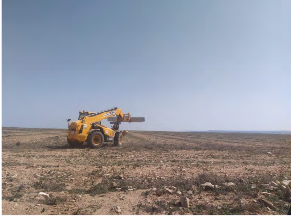
Fotografía 13. Maquinaria transportando hincas.
