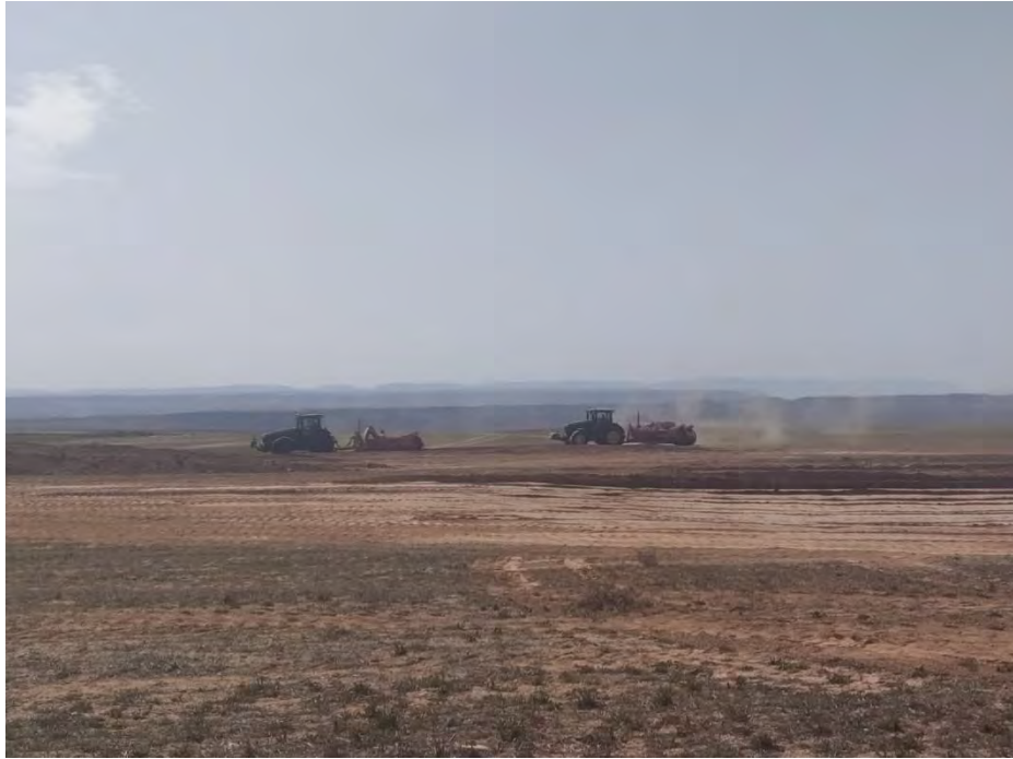
Fotografía 15. Movimiento de tierra Castillo 1
