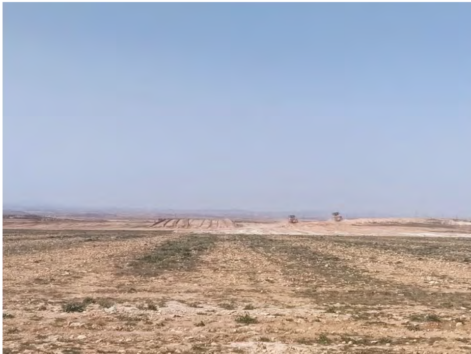
Fotografía 12. Movimiento de tierra Castillo 1
