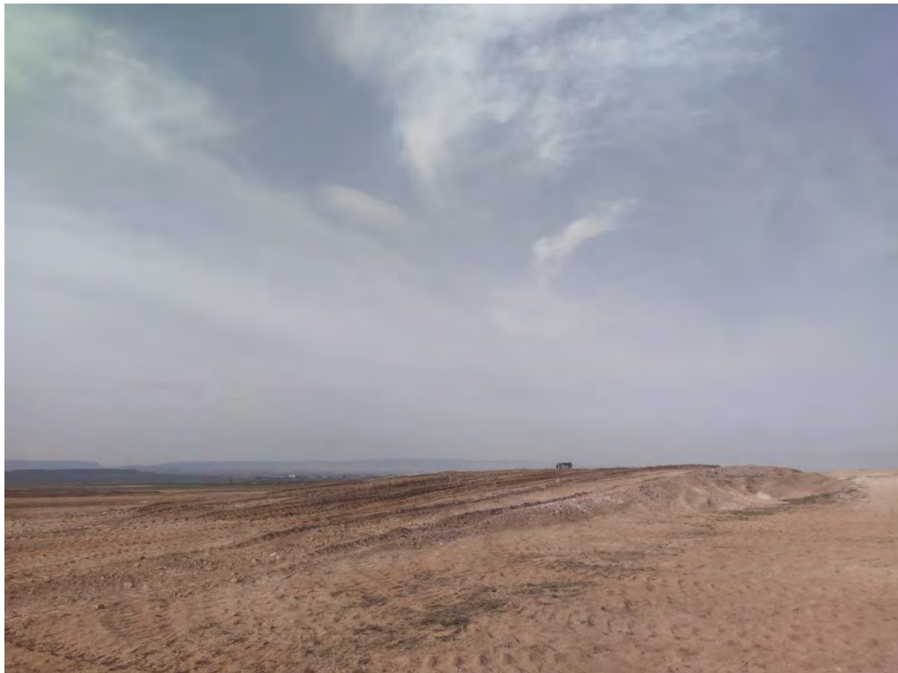
Fotografía 2. Movimiento de tierra Castillo 1
