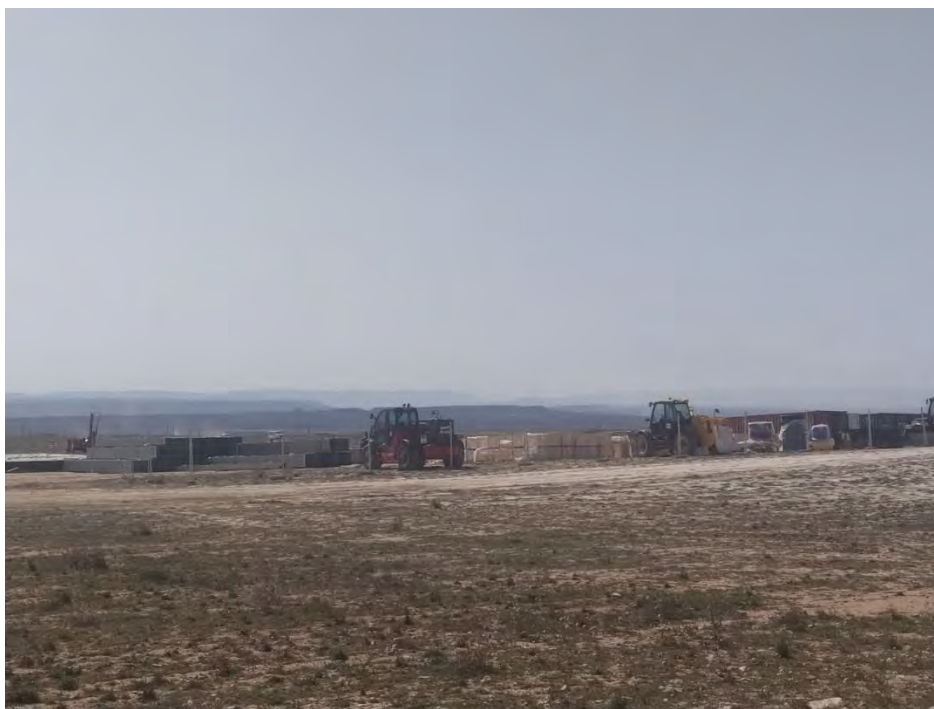
Fotografía 25. Zona de acopios.
