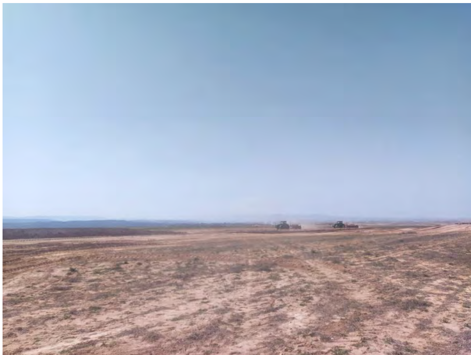
Fotografía 14. Movimiento de tierra Castillo 1
