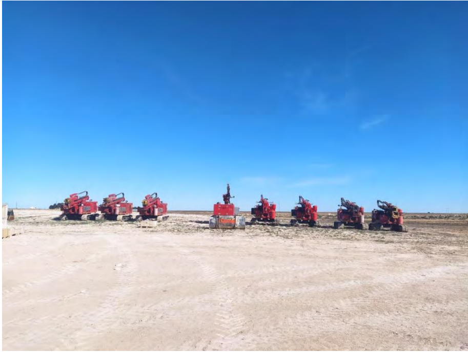
Fotografía 15. Hincadoras, todavía sin utilizar.
