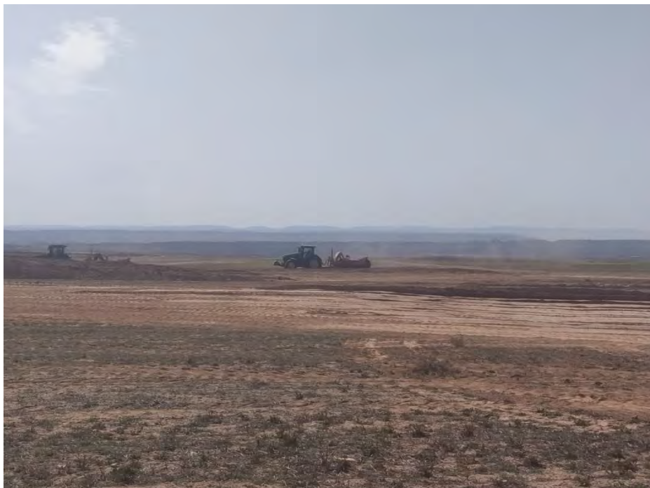
Fotografía 16. Movimiento de tierra Castillo 1
