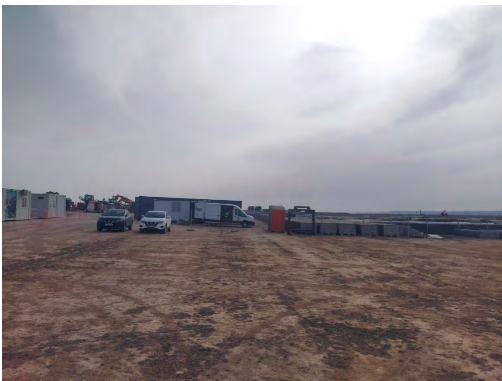
Fotografía 14. Zona de acopio y casetas.
