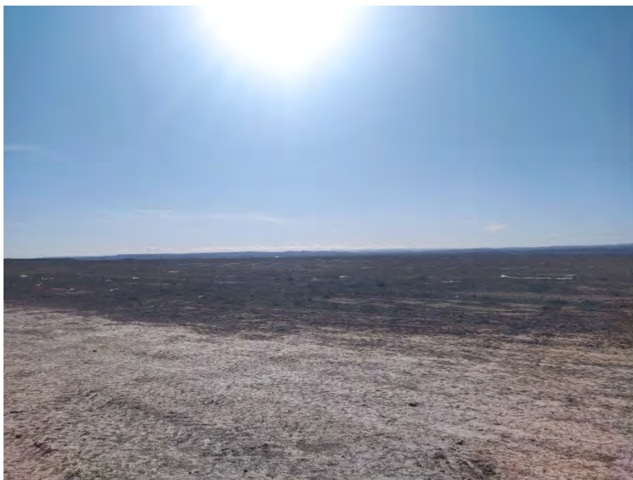
Fotografía 13. Hincas sobre el terreno para su posterior colocación. Castillo 1
