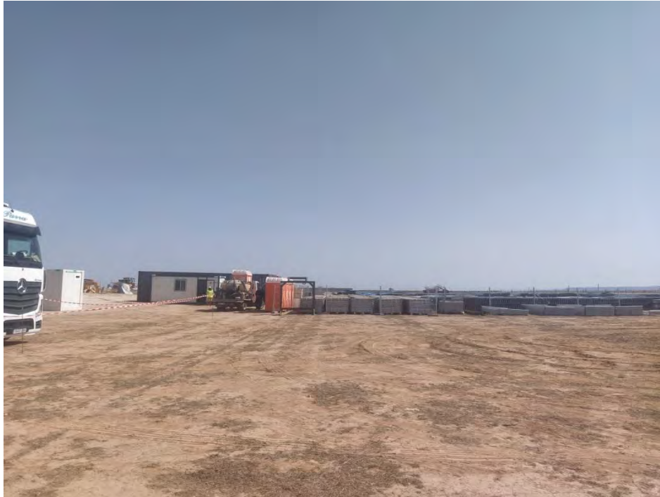
Fotografía 23. Zona de acopios.
