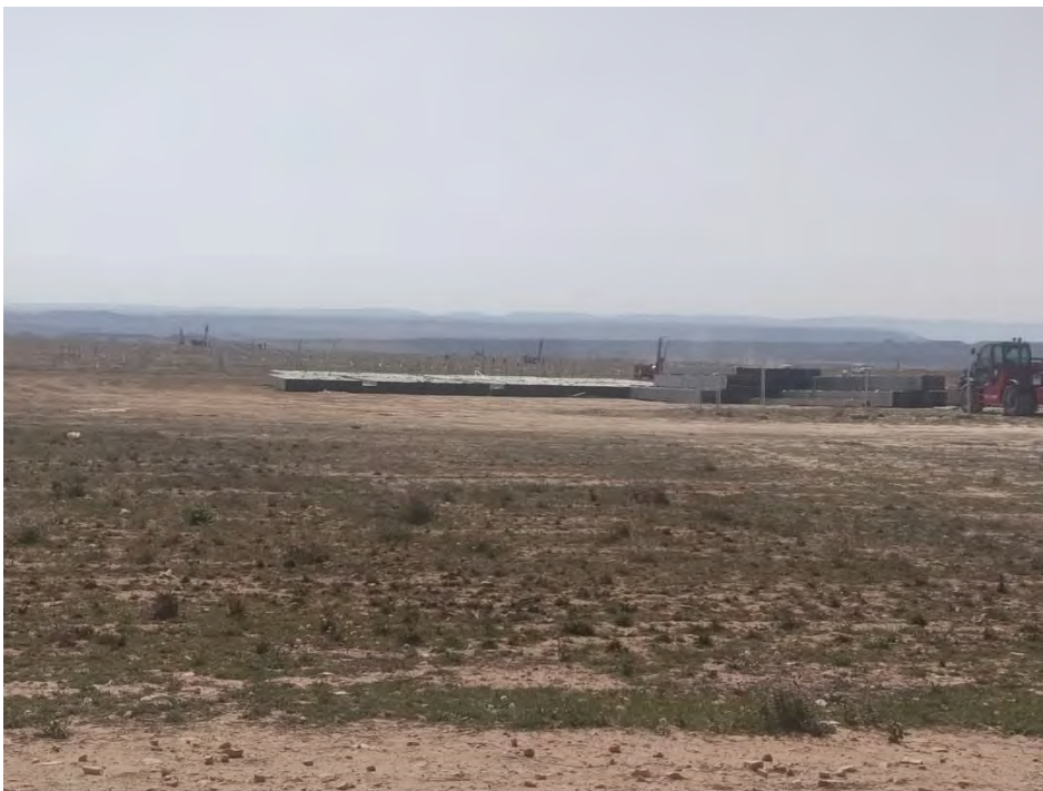
Fotografía 24. Zona de acopios.
