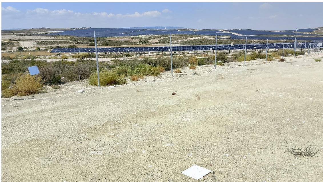
Fotografía 4. Vallado perimetral con las placas anticolidión desprendidas en Cartujos 2 Parcela 8
