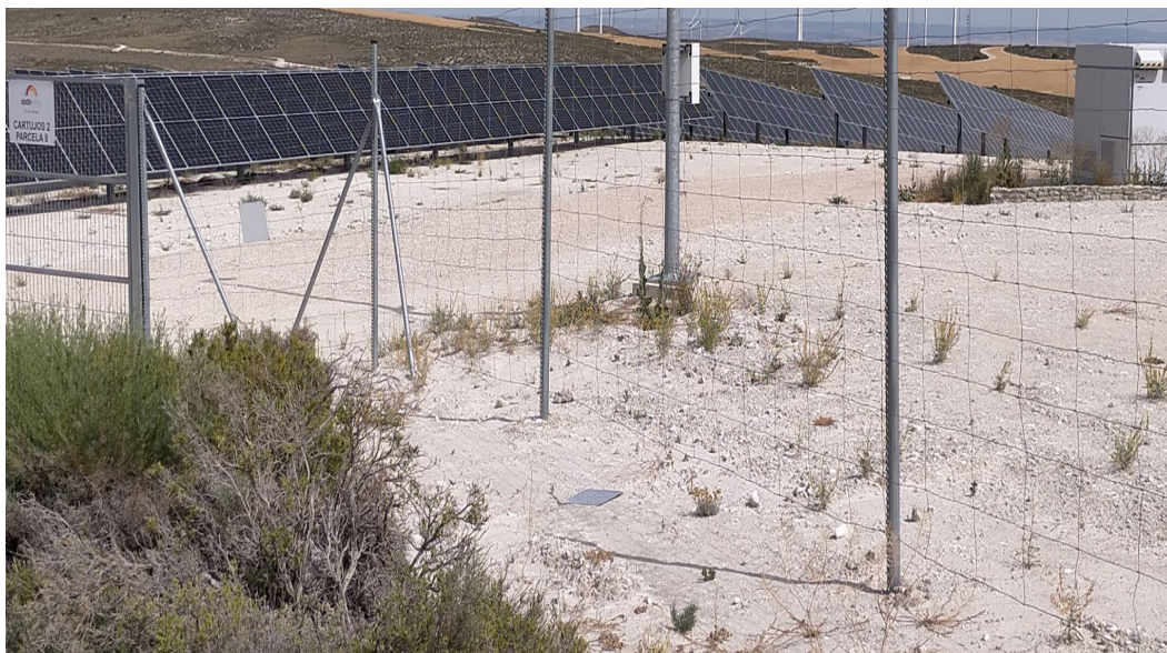
Fotografía 4. Vallado perimetral con las placas anticolidión desprendidas en Cartujos 2 Parcela 8.
