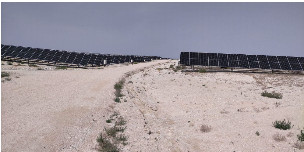
Fotografía 3. Vista de un drenaje paralelo a un camino en pendiente en Cartujos 1 Parcela 5.
