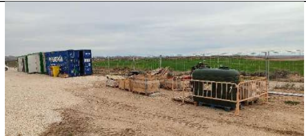
Punto limpio en la zona de acopio 1 y área temporal de repostaje
