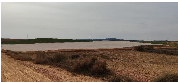
Zona de acopio 3 terminada. Desde camino
