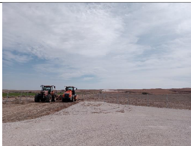
Zona de acopio 3 en proceso de realizacion. Desde la entrada.
