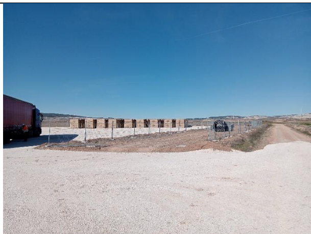
Zona de acopio de tubos, arquetas y otros.
