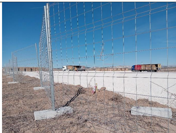
Detalle del estaquillado y vallado de obra provisional.
