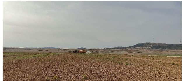
Campa conjunta para futuras infraestructuras auxiliares. Durante el proceso de humectación del terreno para el asentamiento de la zahorra.
