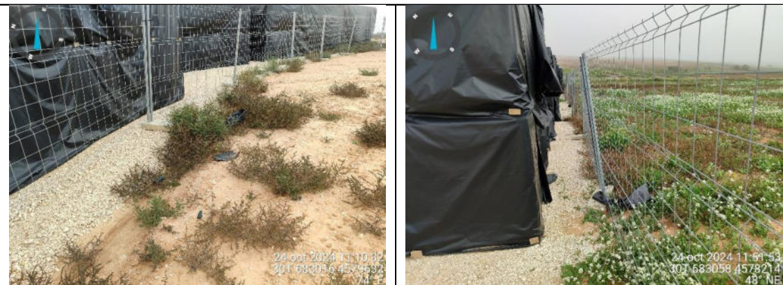
Acopios temporales de lonas retiradas y la presencia en diversos puntos de las campos de pedazos de estas lonas.
